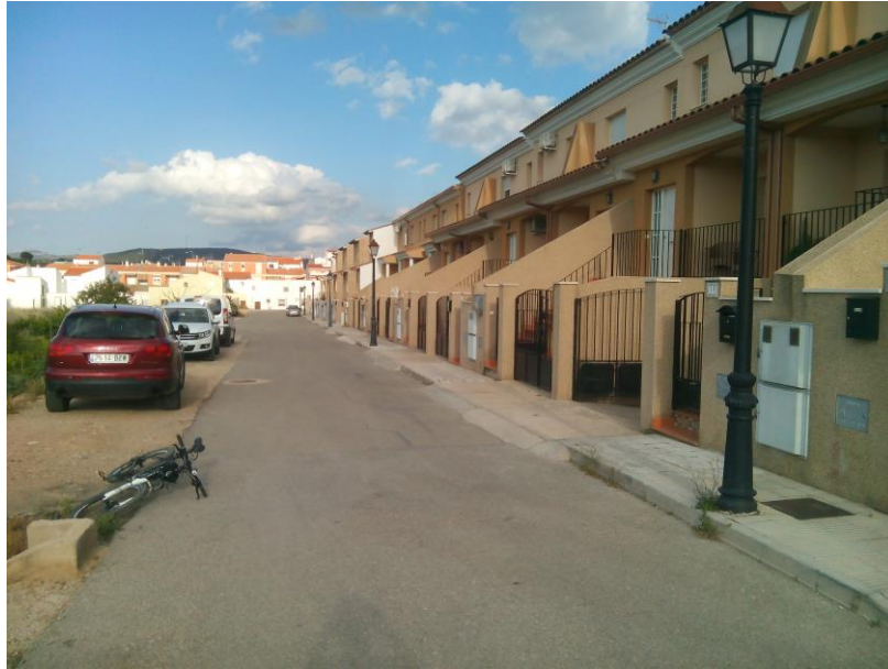
Vista general de la C/ Montemayor, orientada hacia aguas abajo
