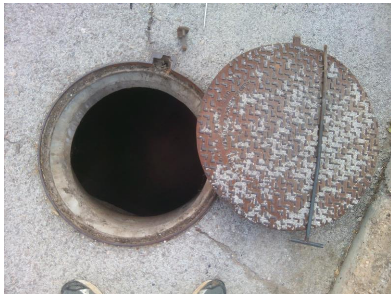
Apertura de pozo de pluviales
