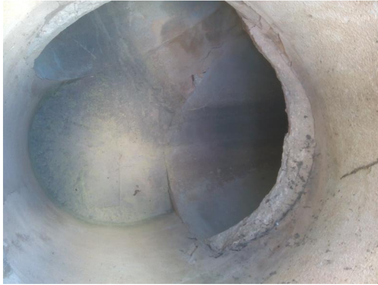
Interior de pozo de pluviales, giro de 90°
