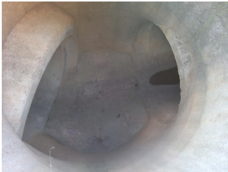
Interior de pozo de pluviales con restos de la última lluvia
