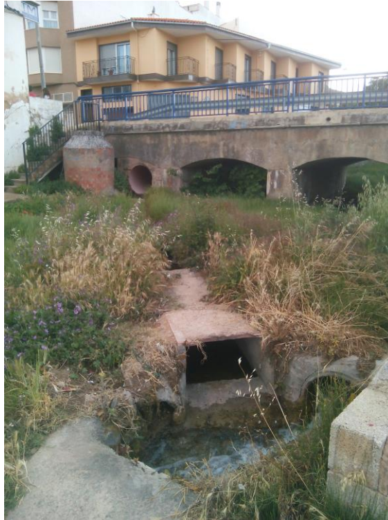
Entorno del tubo de vertido
