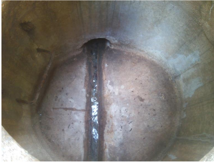
Interior de pozo de registro
