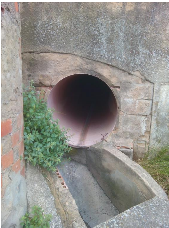
Exterior del tubo de vertido
