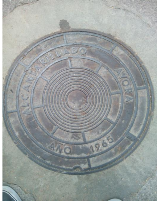
Tapa de alcantarillado
