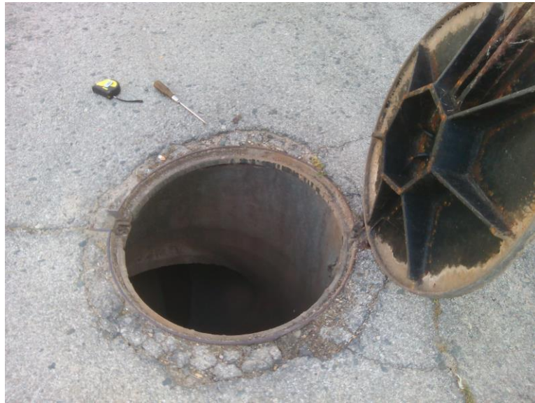
Apertura de pozo de pluviales
