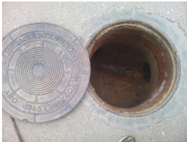
Apertura de pozo de registro
