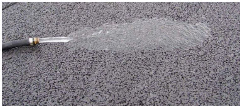
Ejemplo de pavimento permeable.
