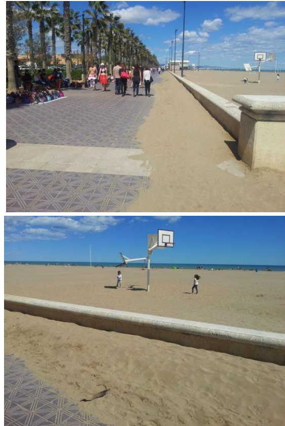
Figura 3. Invasión de arenas en paseo marítimo
