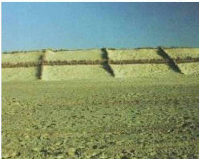
Figura 13. Bardisas de espertina dispuestas en trama ortogonal. Detalle de colocación
