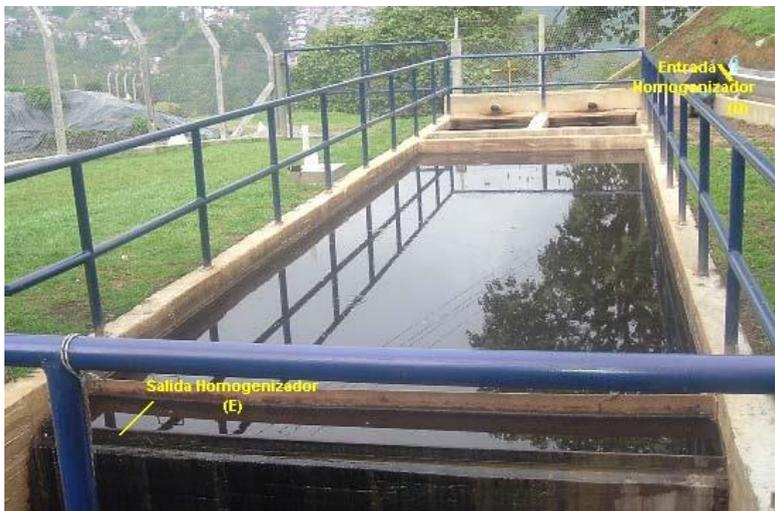
**Imagen 8.-** Tanque de homogeneización.
