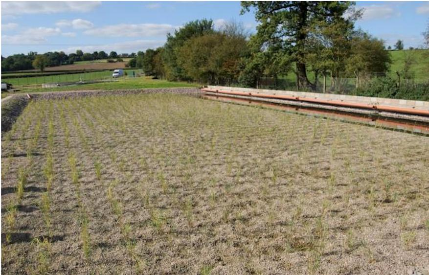
**Imagen 9.-** Humedal artificial de flujo subsuperficial horizontal.
