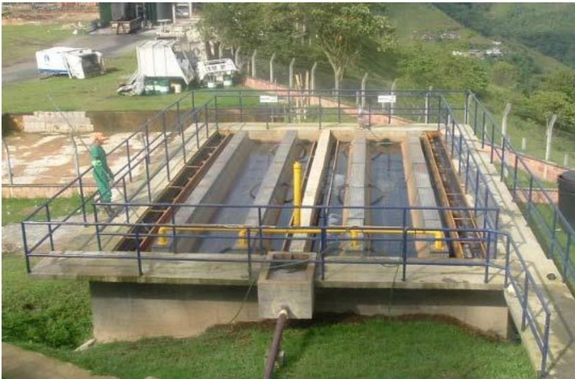
**Imagen 5.-** Reactor UASB de flujo vertical.
