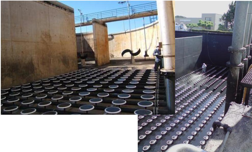
**Imagen 12.-** Parrillas de difusores y aireador en un reactor biológico.
