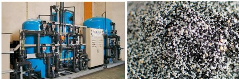
**Imagen 20.-** Instalación de intercambio iónico y resina.
