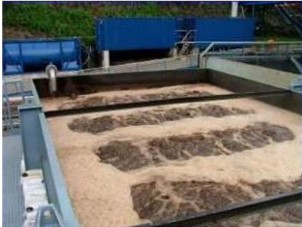
**Imagen 7.-** Reactor MBR en funcionamiento.
