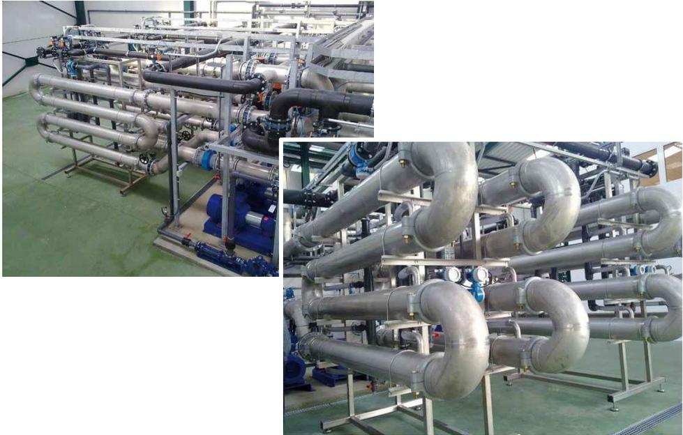
**Imagen 20.-** Instalación de ultrafiltración.
