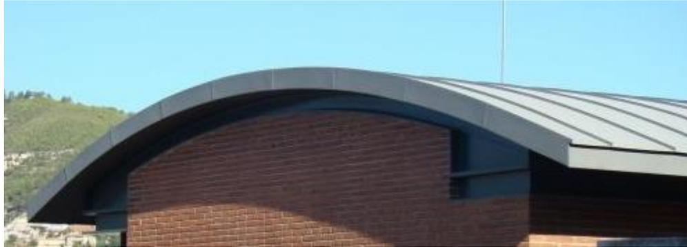
Figura 11 : Ejemplo de cubierta con panel sándwich curvo
