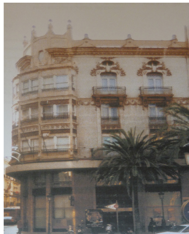
▲ Imagen 19. Fachada calle Barcas antes de realizar intervención de AIC Equip. Se puede observar el mirador en la cuarta planta.
