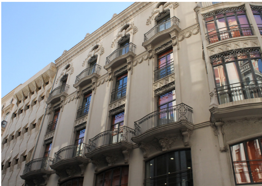
▲ Imagen 71. Fachada calle Pascual y Genís
