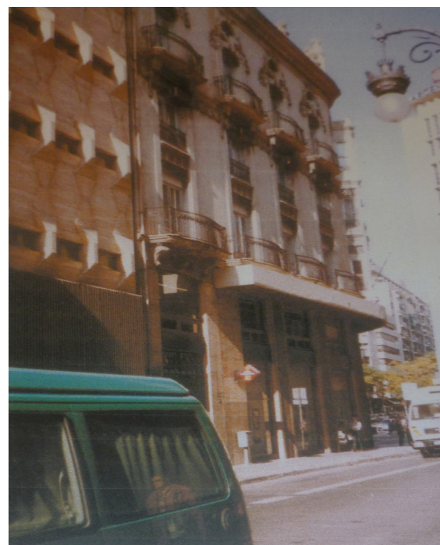
▲ Imagen 21. Fachada Pascual y Genís antes de realizar intervención.
