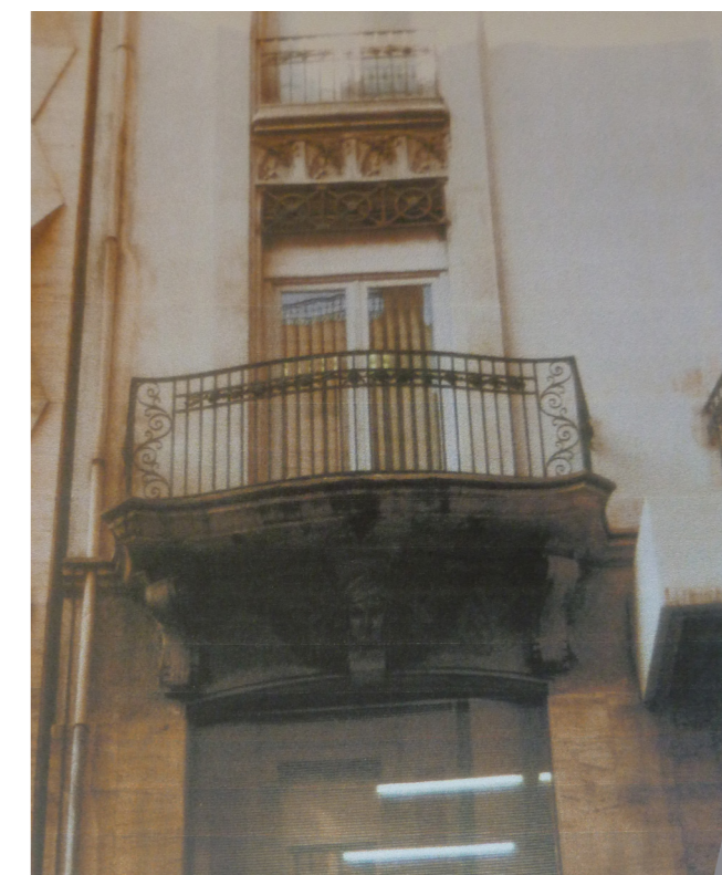
▲ Imagen 22. Acceso por calle Pascual y Genís antes de realizar intervención de AIC Equip, podemos ver el aplacado de travertino en toda la Planta Baja.
