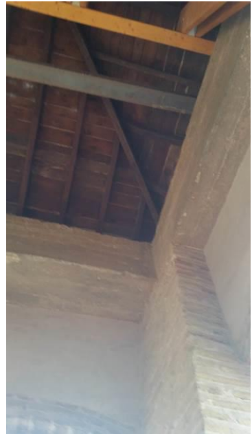
Ilustración 21 Cubierta de San Pedro, 2015. Pablo Torres
