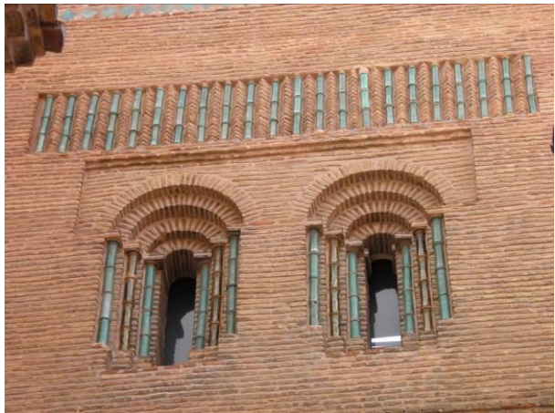
Ilustración 18 Ventanas triple arquivolta, 2015. Pablo Torres
