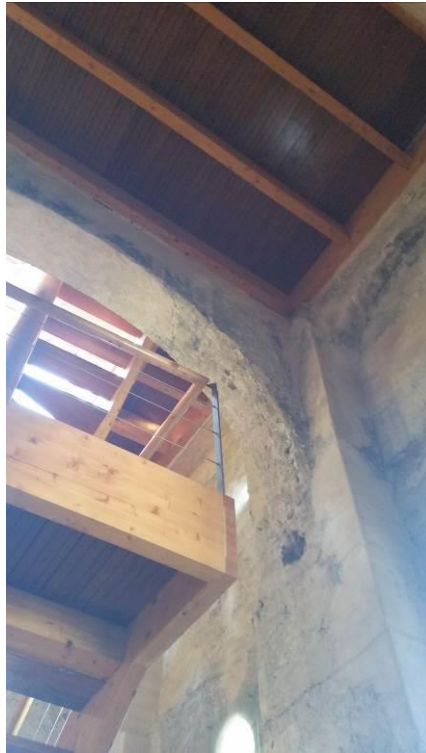
Ilustración 23 Forjado de madera de San Pedro, 2015. Pablo Torres
