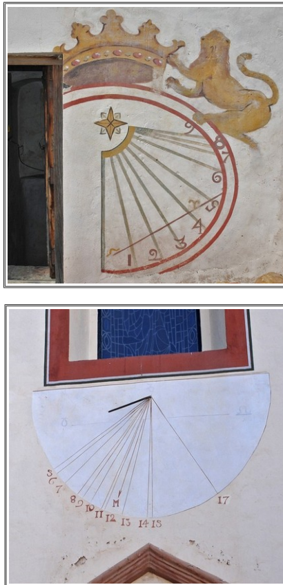
Figura 49 – Cuadrantes solares en Albalat dels Tarongers (Segura Grancha, 2015)
