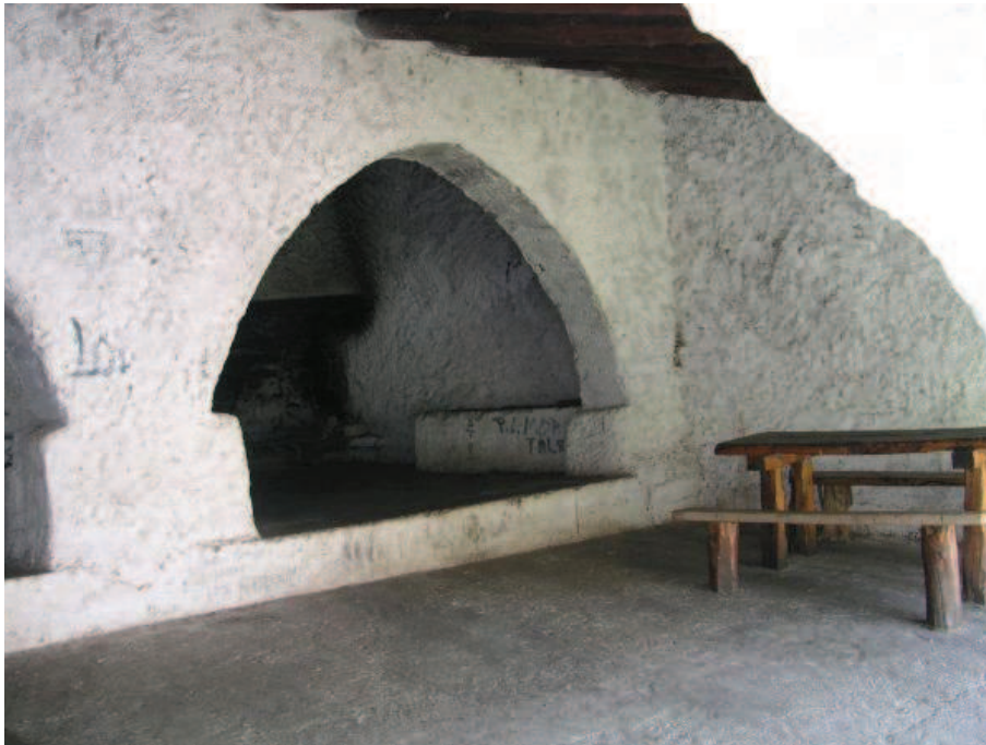
Fig 8 :Refugio puente de la Barraquena. Fuente: Conselleria de Medi Ambient
