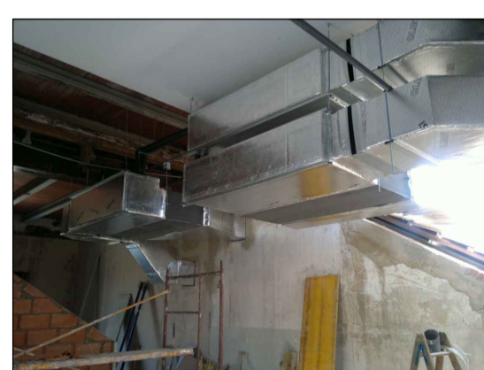
EVAPORADORAS Y SUS CONDUCTOS COLOCADAS EN SALA DE MÁQUINAS INTERIOR
