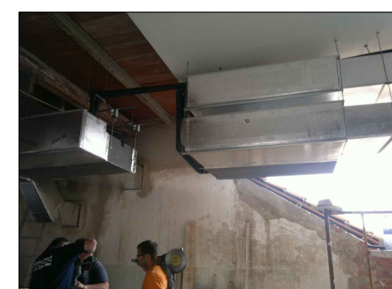
EVAPORADORAS Y SUS CONDUCTOS COLOCADAS EN SALA DE MÁQUINAS INTERIOR
