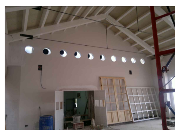
Muecos para colocación de toberas de impulsión de largo alcance en salón baile en zona Este.
