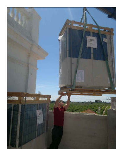
Elevación de las unidades condensadoras a la terraza de torreon para su ubicación definitiva.
