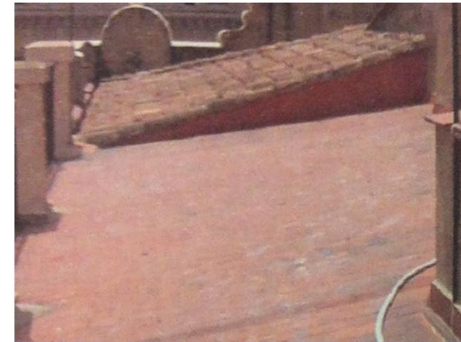
Imágenes de la cubierta transitable, pavimento de arcilla cocida .
