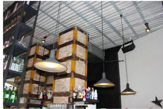
Imágenes de la parte demolida del forjado de entreplanta y refuerzos en los soportes.
