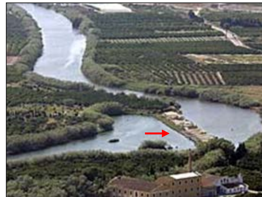
Figura 13. Panorámica del Azud de la Marquesa
