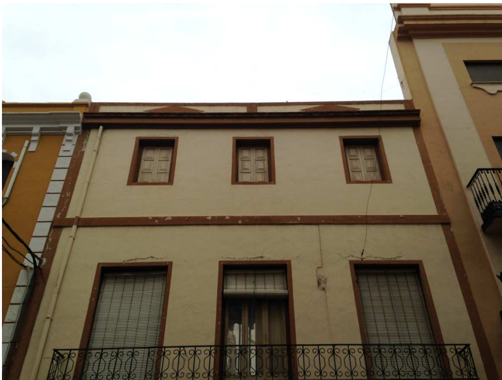
AII2. FACHADA OESTE (II). ESTADO ORIGINAL.
