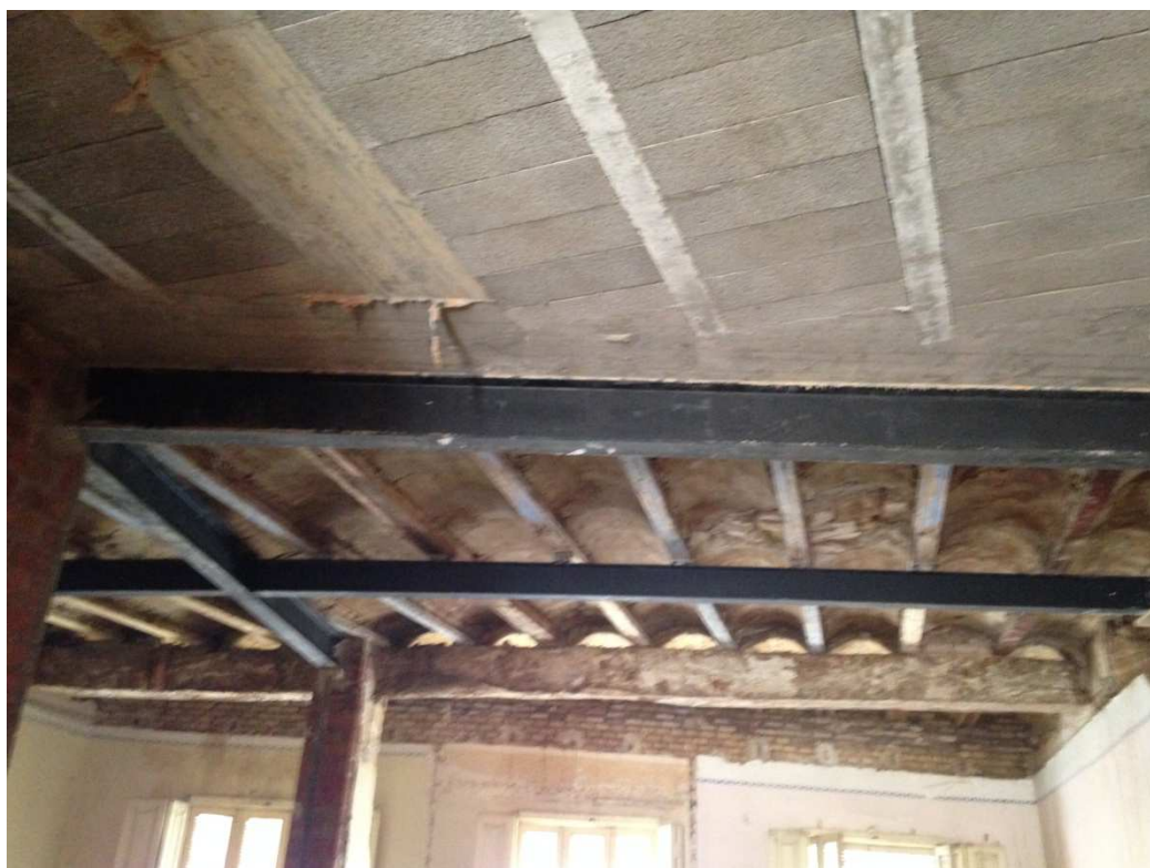
AII10. FORJADOS ORIGINAL Y REHABILITADO. ESTADO REHABILITADO.
