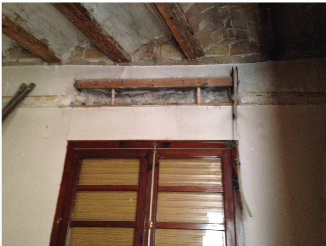
AII5. ENCUESTRO FACHADA OESTE - FORJADO. ESTADO ORIGINAL.
