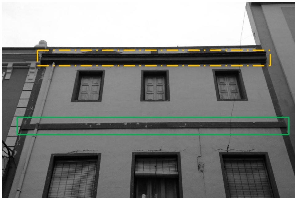
Figura 60. Esquema de puentes térmicos. Estado original. Fachada Oeste.
