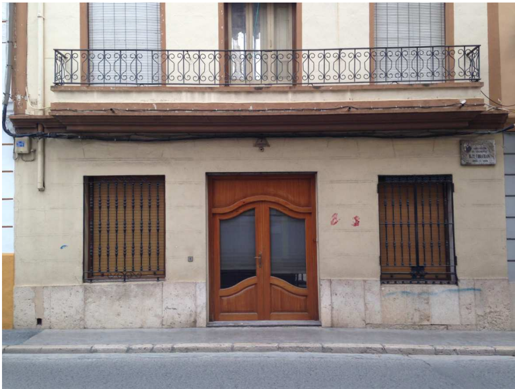
AII1. FACHADA OESTE (I). ESTADO ORIGINAL.
