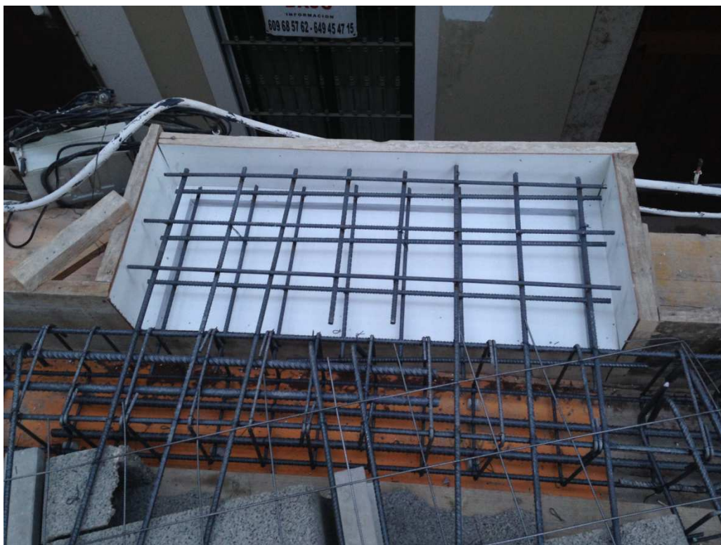
AII9. ENCUENTRO FACHADA ESTE - BALCÓN. ESTADO REHABILITADO.
