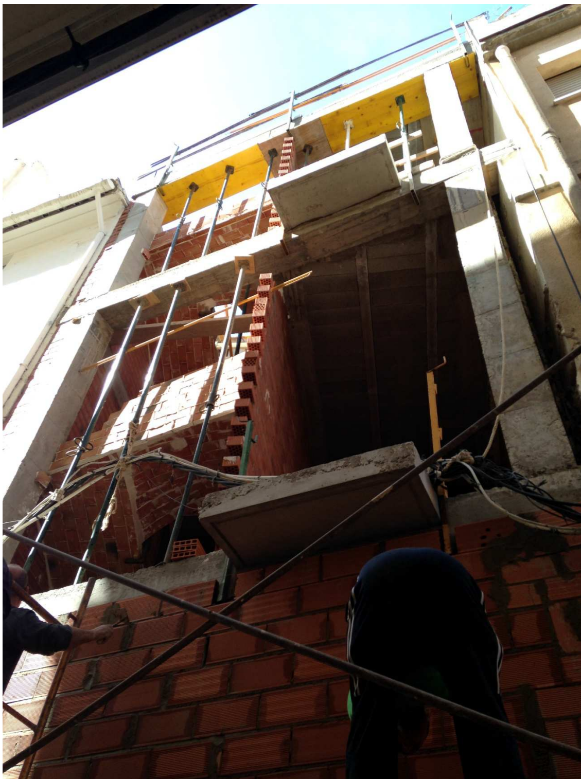
AII8. FACHADA ESTE. ESTADO REHABILITADO.
