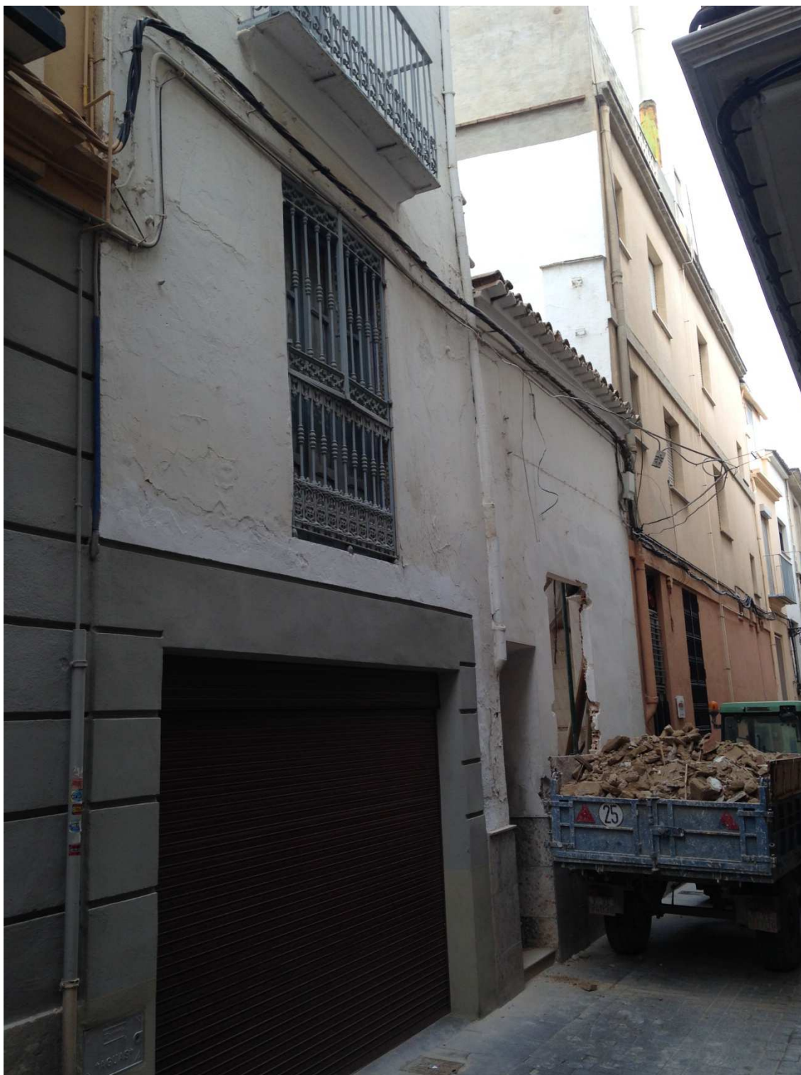
AII4. FACHADA ESTE (II). ESTADO ORIGINAL.
