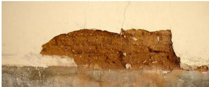
Pérdida del revestimiento en una pared de tapia. El mantenimiento constante es obligado para la durabilidad de estas construcciones.
