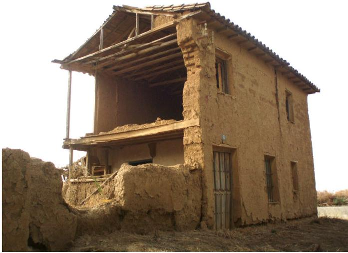
Vivienda de dos plantas en ruina por colapso del frontal posterior debido a falta de mantenimiento. Se puede comprobar el efecto de la escorrentía en la base del muro y la pérdida de sección en diferentes puntos.
