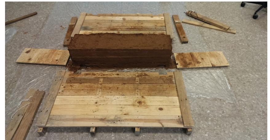
Desencofrado de un módulo de tapia.
