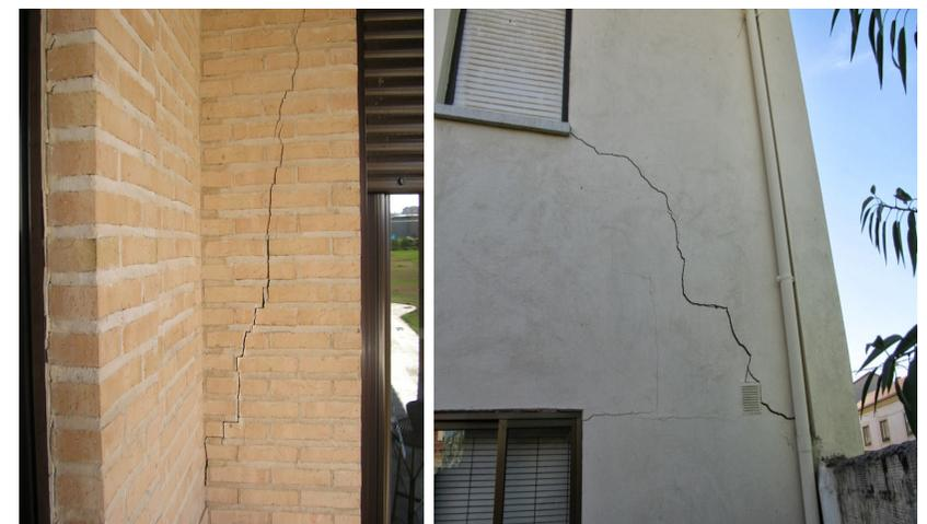
Ref. 26. Grietas y humedades aparecen en diferentes muros de ladrillo, hormigón y bloque.
