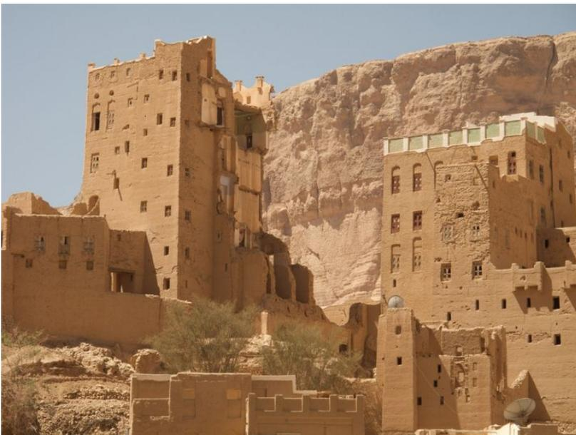
Falta de mantenimiento y pérdida de revestimientos afectan directamente a la urabilidad de las estructuras de tierra expuestas a la intemperie. Fuente. UNESCO
