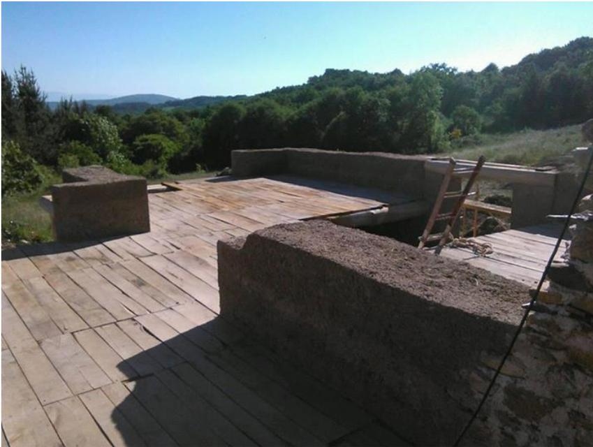
Vivienda de cob con muros de carga de 40cm con forjados y dinteles de madera maciza. Arranque de la primera planta.
