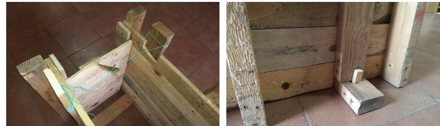
Proceso de ejecución de un tapial (encofrado) y detalles
