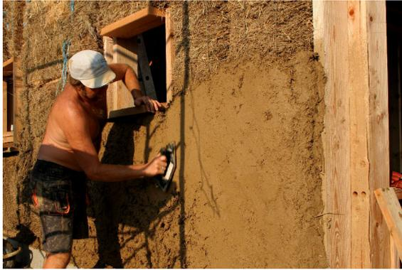
Aplicación de un revoco de tierra en vivienda autoconstruida de balsas de paja.
