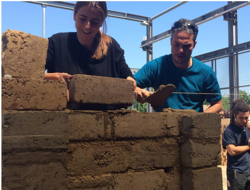
Construcción de muro con bloques de adobe de gan formato.
