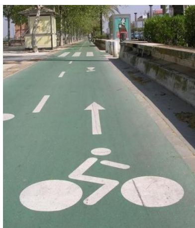
Figura 74. Slurry en vías ciclistas Fuente: pavidepor.com
