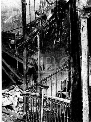
Imagen 7: Teatro Novedades en el incendio del 23 de septiembre de 1928, ABC , 25-09-1928, p.5.
