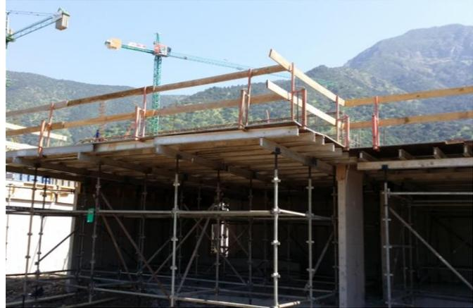
Ilustración 19: Eliminación del riesgo de caída
