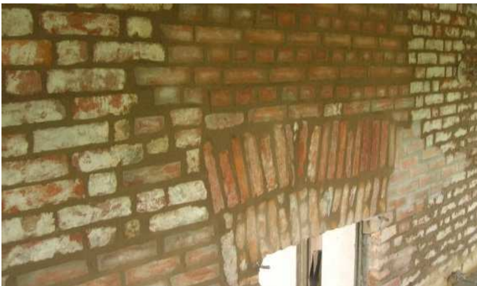
(Ripristino dei paramenti murari con sistema cuci-scuci)
