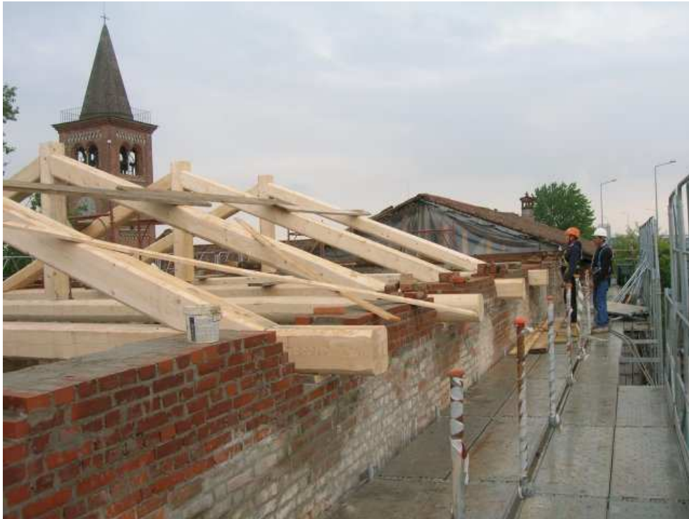
(Ricostruzione della copertura con nuove capriate lignee)
