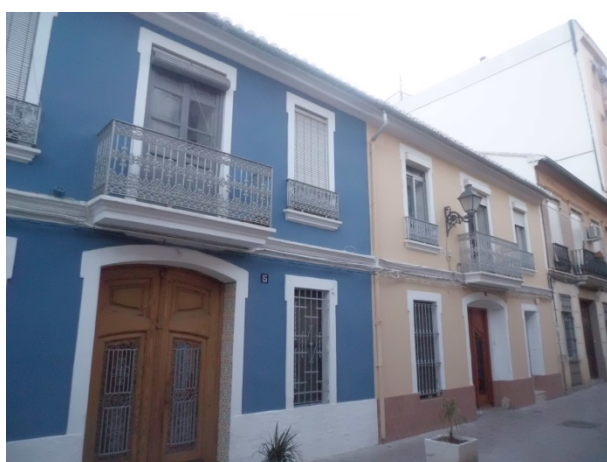
Figura 44: Delimitación de fachadas mediante el color
