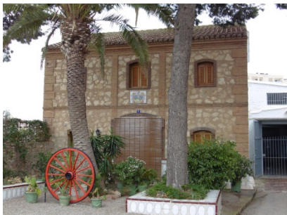
Alquería con mampostería y ladrillo
