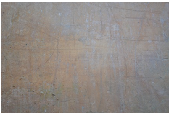
Figura 32: Revoco liso o bruñido
