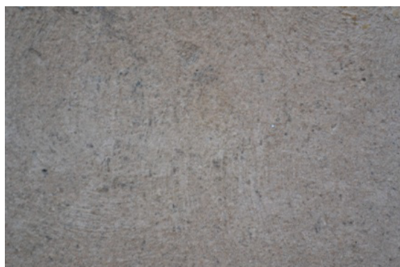
Figura 33: Revoco liso lavado
