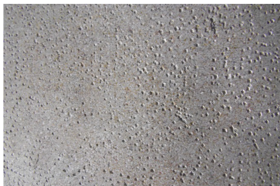
Figura 37: Revoco rugoso a la martellina o abujardado
