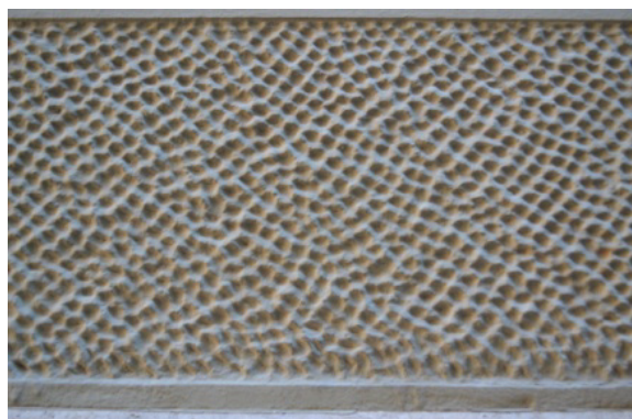
Figura 38: Revoco rugoso picado
