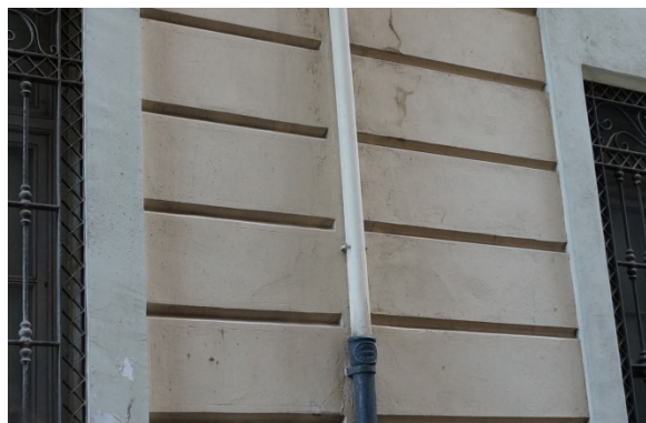
Figura 40: Revoco avitolado
