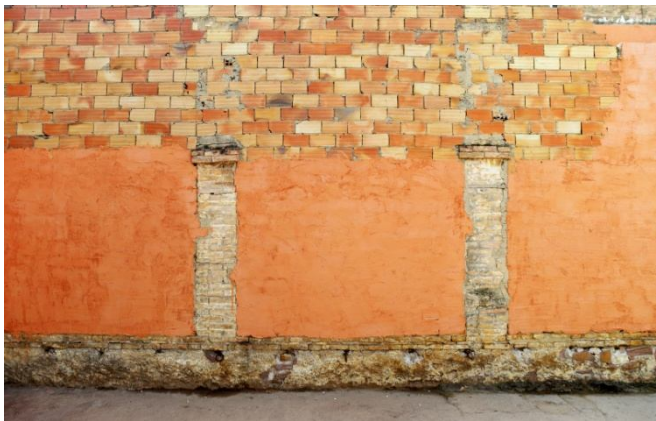
Figura 53 Pilastri inglobati nella muratura
