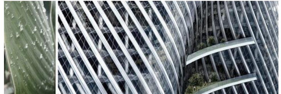
Imagen 1.10 Fachada con canales conductores de agua de lluvia
