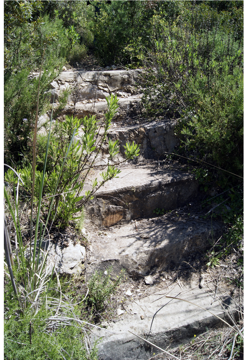
Imagen: Restos escalera Casa Barranc de l' Aigua (imagen propia)
