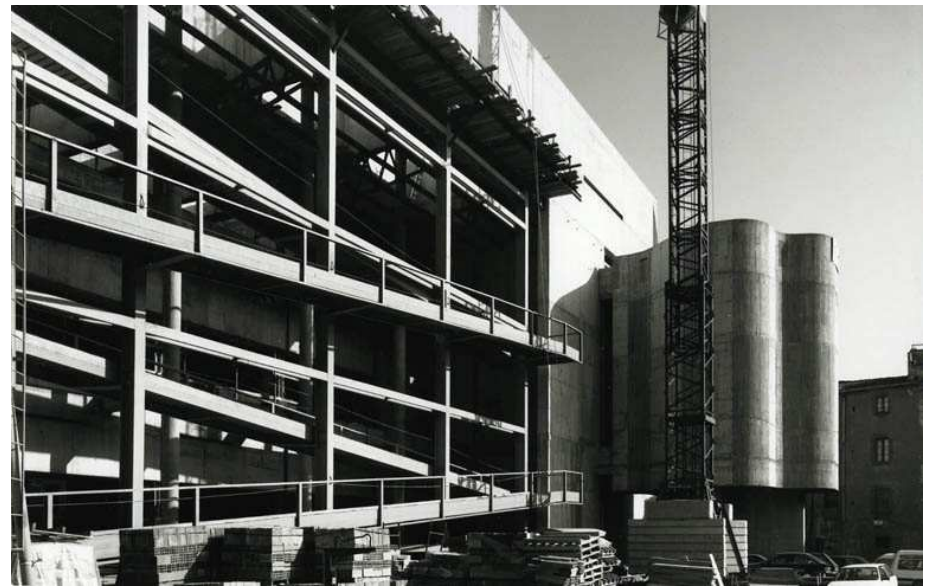
Figura 25. MACBA en construcción (1994)
