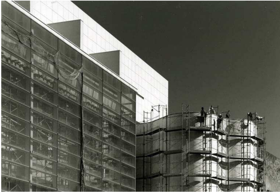
Figura 23. MACBA en construcción (1994)
