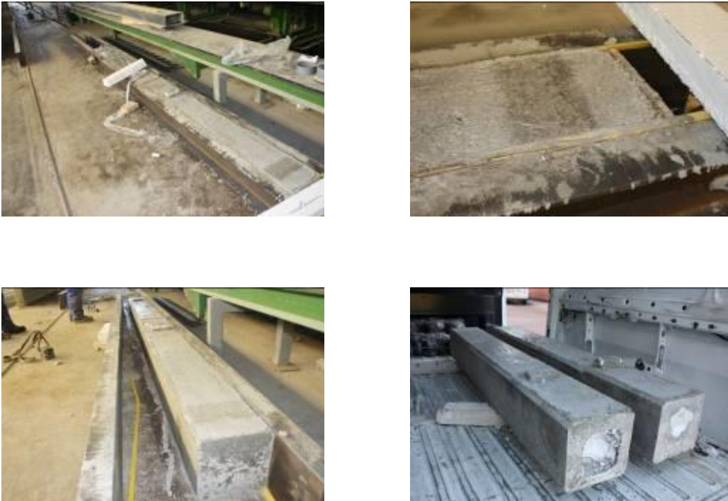
Figura 20: proceso de desencofrado y transporte
