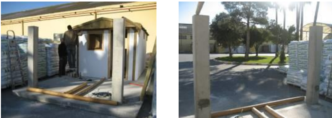
Figura 24: pilares de hormigón ligero utilizando cáscara de coco como árido fueron colocados en la estructura de una vivienda prefabricada de bajo coste.
