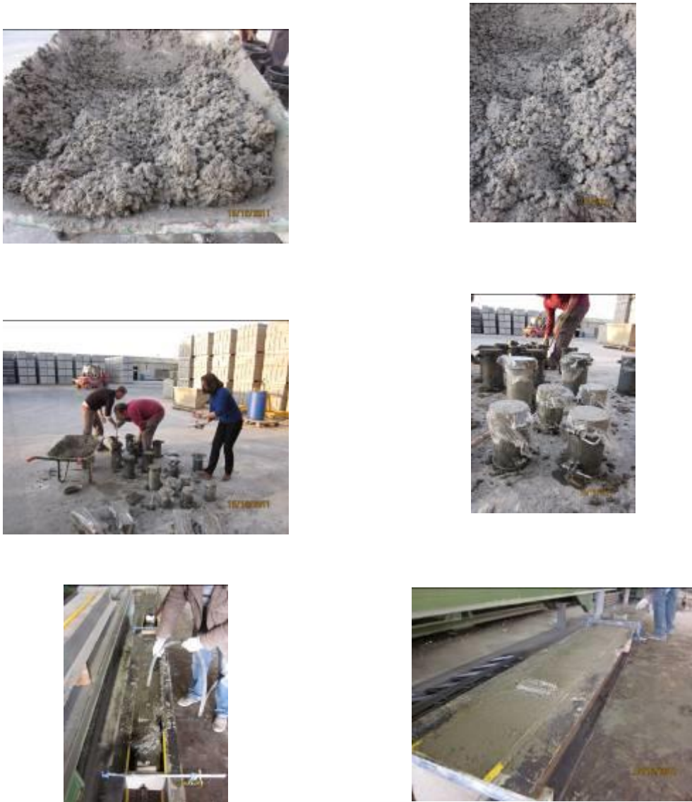
Figura 19: proceso de llenado de moldes de pilares y probetas de laboratorio
