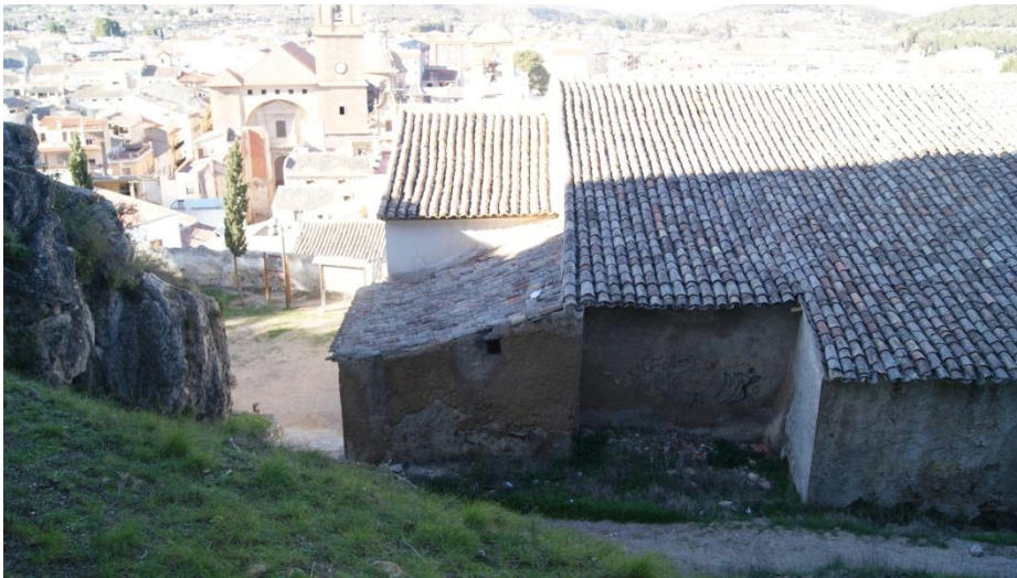
Figura 2.77 – Diferencia de cotas de cubierta. (David Clarí, 2014)
