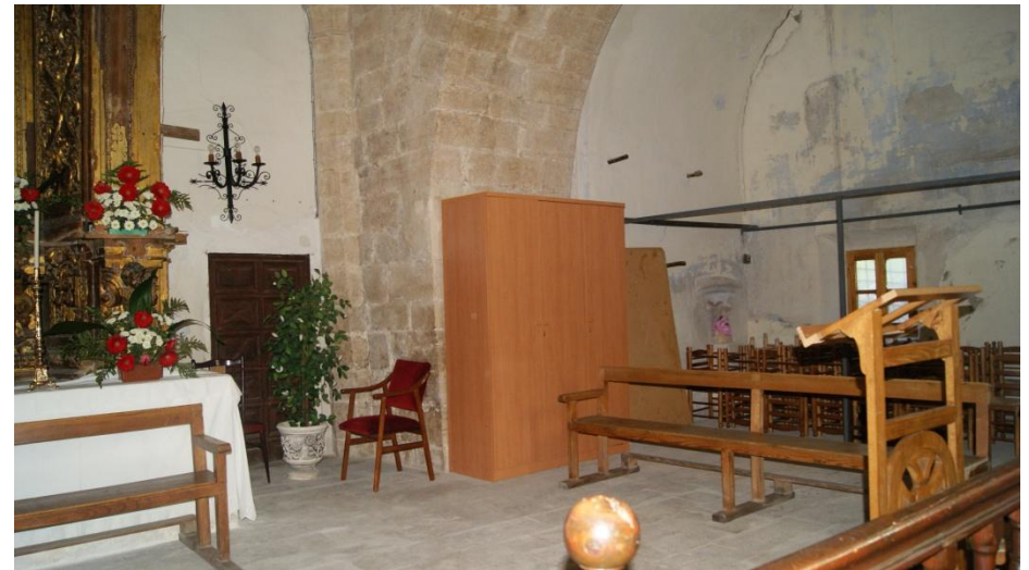
Figura 2.49 – Muro de sillería en el ábside edificio. (David Clarí, 2014)
