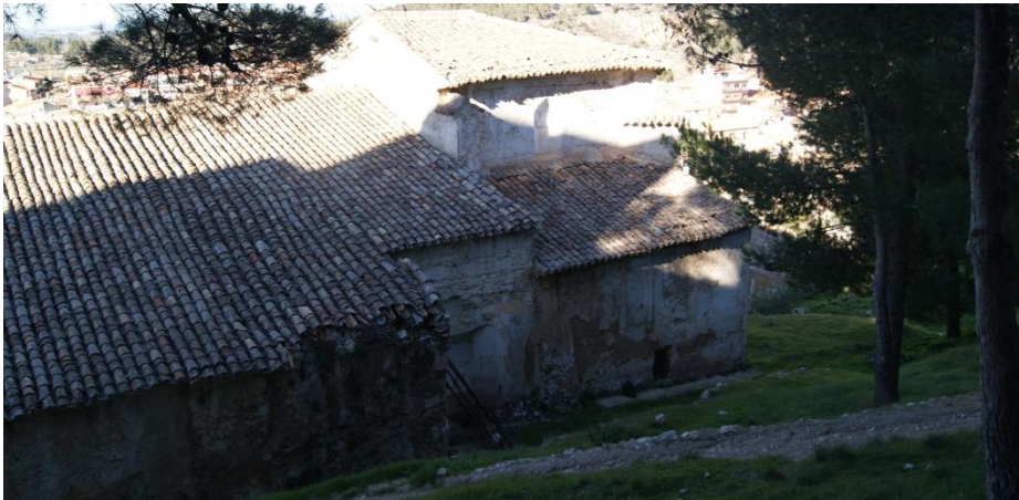
Figura 4.2 – Apuntalamiento en el muro de fachada sur. (David Clarí, 2014)
