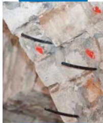
Detalle de la fijación de los tubos de inyección
