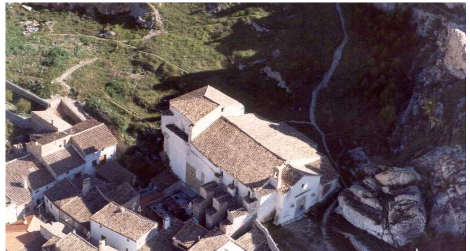
Figura 2.22 – Vista aérea del edificio tras la reparación. (Diputación de Valencia, 1991)
