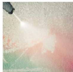
Lavado, con agua a presión, de hormigón tratado con WallGard GRAFFITI BARRIER
