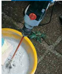
Preparación de la mezcla de Mape-Antique I
