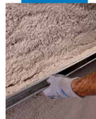
Reglado de Mape-Antique Strutturale NHL
