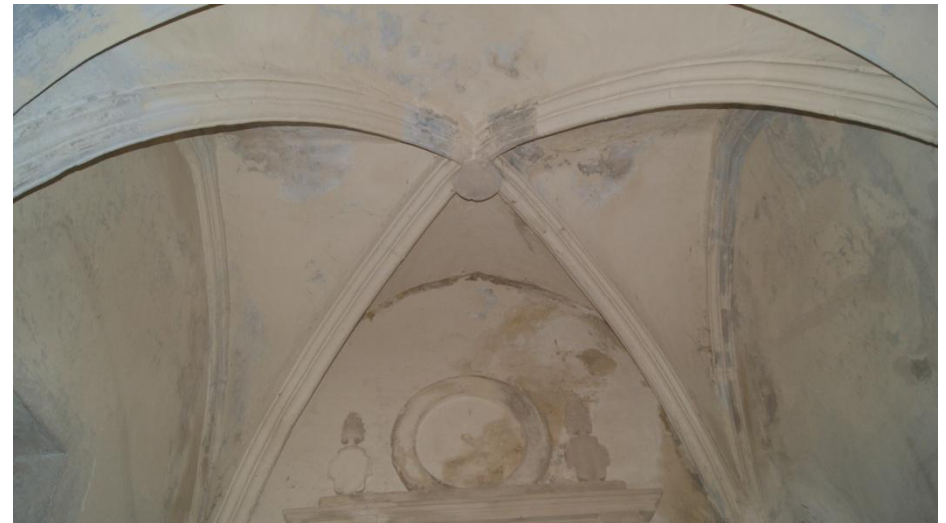
Figura 2.60 – Vista de la bóveda de crucería de una capilla lateral. (David Clarí, 2014)
