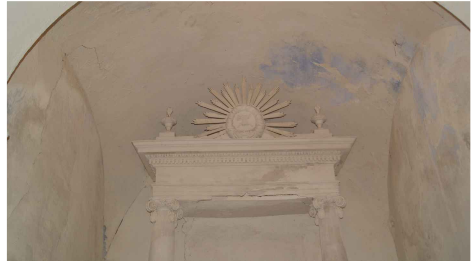
Figura 2.72 - Bóveda de cañón apuntado en el lado de la Epístola. (David Clarí, 2014)
