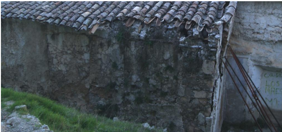
Figura 2.92 – Vegetales superiores en la fachada sur del edificio. (David Clarí, 2014)
