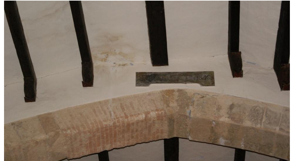
Figura 2.120– Reconstrucción en ladrillo del arco apuntado de la tercera crujía. (David Clari, 2014)
