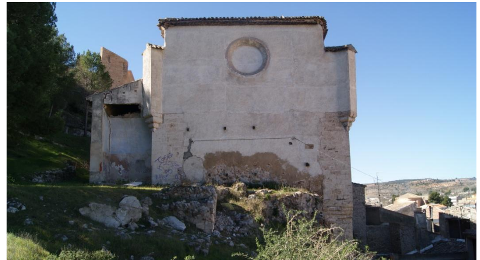
Figura 2.28 – Estado actual de la fachada oeste del edificio. (David Clarí, 2014)
