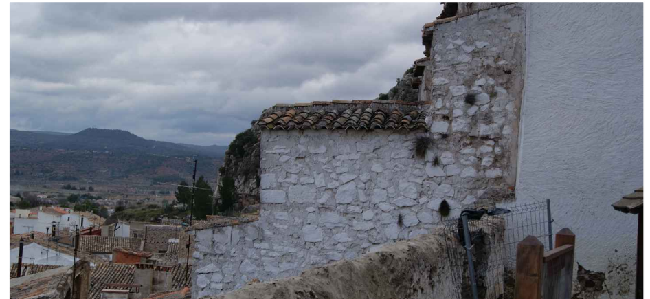
Figura 2.43 - Mampostería careada en uno de los contrafuertes de la fachada norte. (David Clarí, 2014)
