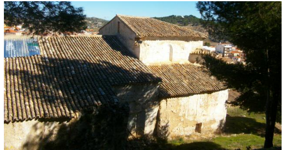
Figura 2.123– Reparación en cubierta. (Aytm. Ayora, 2014)
