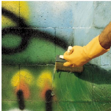
Aplicación de WallGard GRAFFITI REMOVER GEL con brocha
