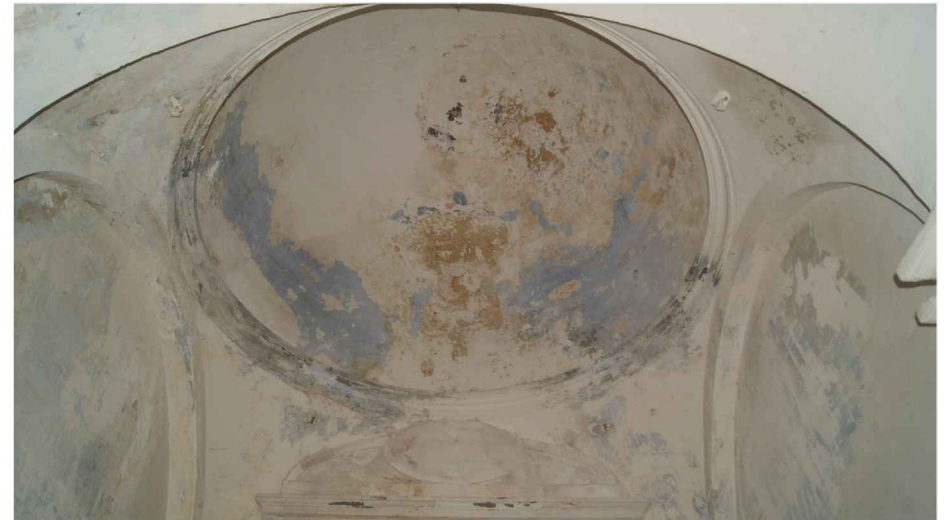
Figura 2.74 - Cúpula apoyada sobre pechinas en el lado de la Epístola. (David Clarí, 2014)
