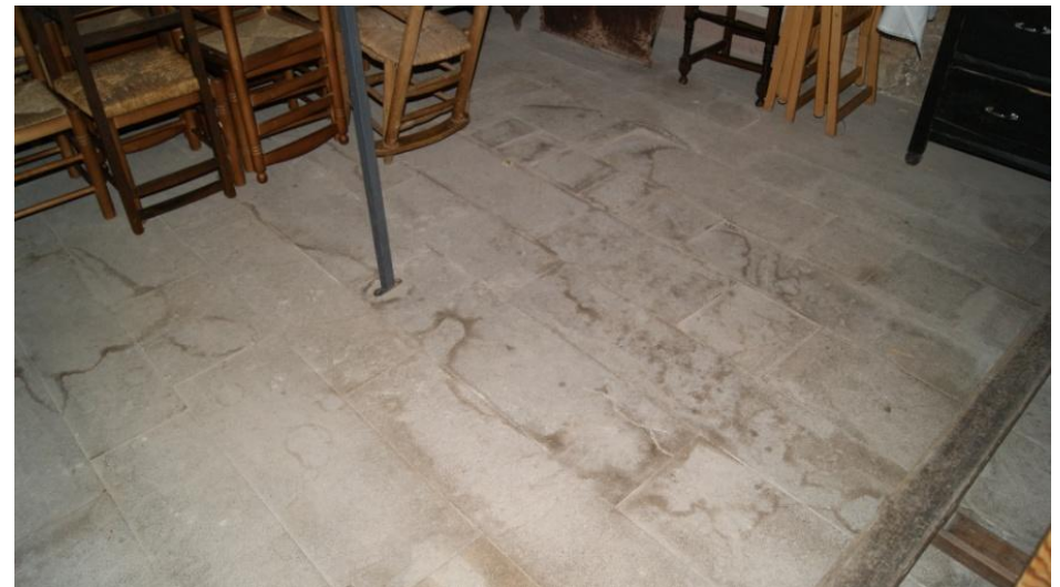
Figura 2.87 – Vista del pavimento del edificio. (David Clarí, 2014)
