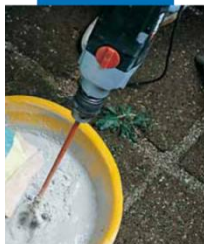
Preparación de la mezcla de Mape-Antique I
