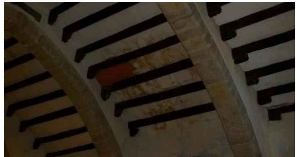
Figura 2.124– Reparación en el interior del edificio. (Aytm. Ayora, 2014)
