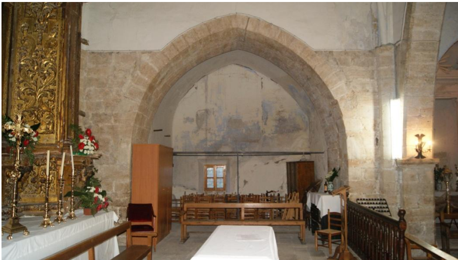
Figura 2.47 – Sillería en el lado de la Epístola del interior del edificio. (David Clarí, 2014)
