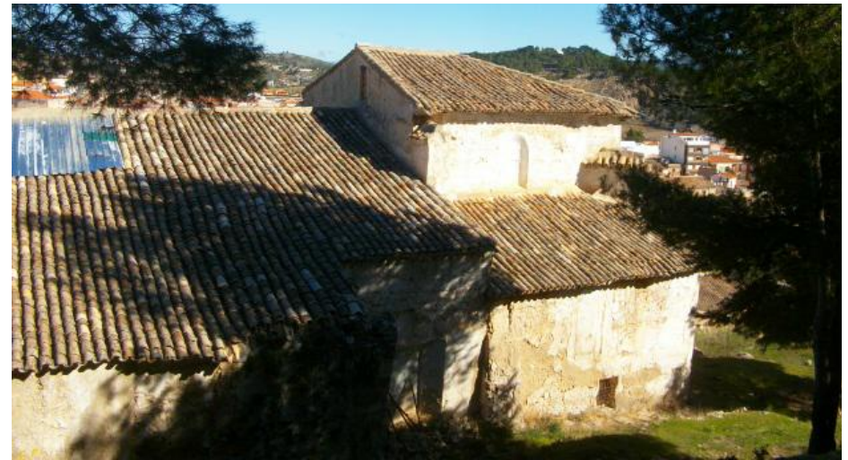
Figura 4.7 – Estado actual de la cubierta del edificio. (Aytm. Ayora, 2014)
