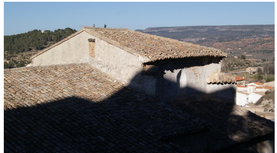
Figura 2.122– Reparaciones en revestimientos y cubierta. (David Clarí, 2014)
