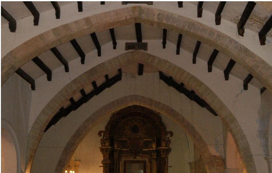
Figura 2.116– Arcos apuntados de la nave central. (David Clarí, 2014)
