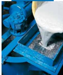
Relleno de la bomba de inyección con Mape-Antique I
