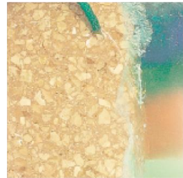
Eliminación del grafito mediante cepillado y lavado
