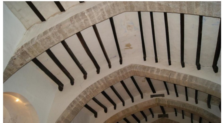
Figura 2.86 – Vista de un revestimiento de yeso en el edificio. (David Clarí, 2014)
