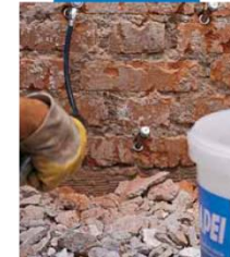
Inyección de Mapestop a baja presión
