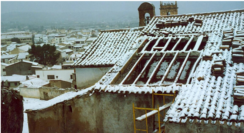
Figura 2.19 – Desmontado de cubierta en 1991. (Diputación de Valencia, 1991)
