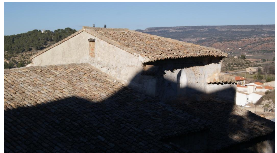
Figura 4.30– Cubierta del edificio. (David Clarí, 2014)
