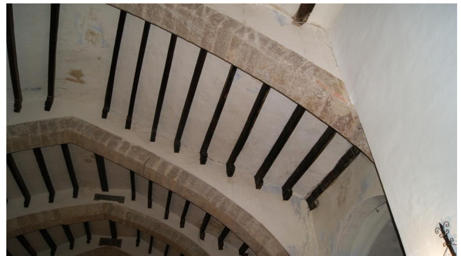
Figura 2.76 – Vista interior de la segunda crujía. (David Clarí, 2014)
