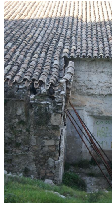
Figura 2.24 y 2.25 – Vista del apuntalamiento en la fachada sur. (David Clarí, 2014)
