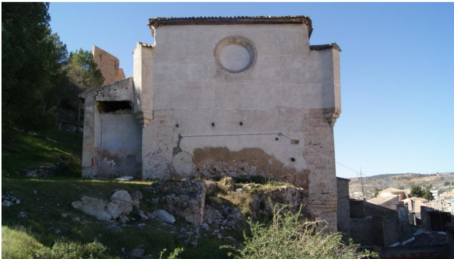
Figura 2.46 – Muro de sillería en la fachada este del edificio. (David Clarí, 2014)
