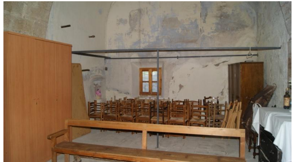
Figura 2.119– Perfiles huecos anclados a suelo y muros la bóveda de cañón apuntado. (David Clarí, 2014)
