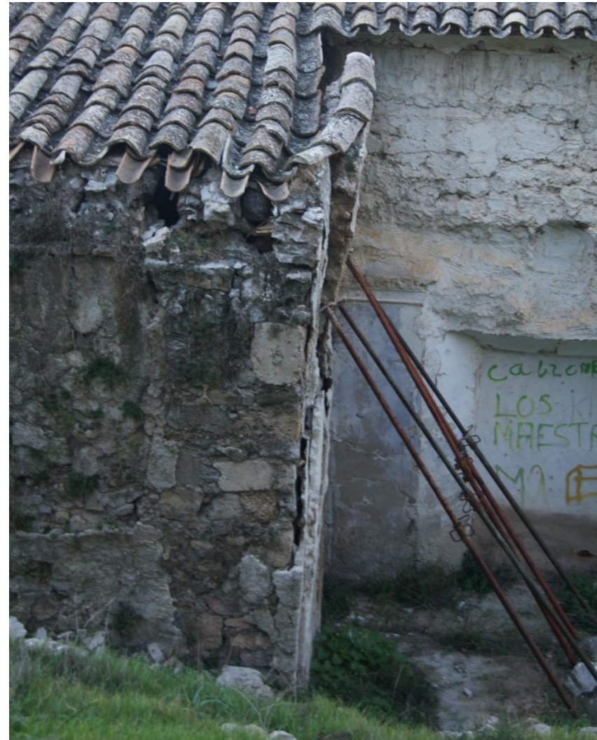
Figura 4.3 – Apuntalamiento en el muro de fachada sur. (David Clarí, 2014)
