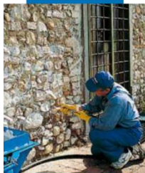
Inyección de consolidación con Mape-Antique I
