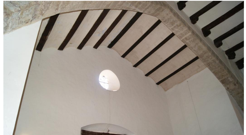
Figura 2.78 Vista de la primera crujía del edificio. (David Clarí, 2014)
