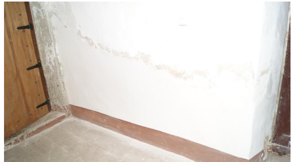
Figura 2.85 – Vista de un revestimiento de cal en el edificio. (David Clarí, 2014)
