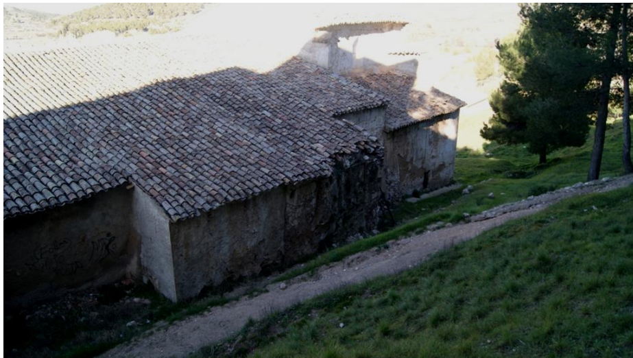
Figura 2.27 – Estado actual de la fachada sur del edificio. (David Clarí, 2014)
