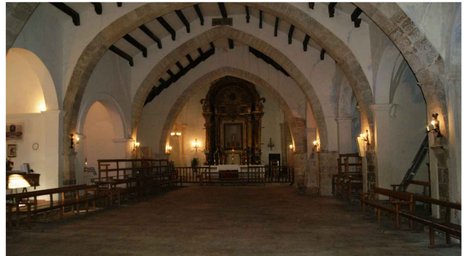
Figura 2.56 - Vista de los accesos a las capillas laterales. (David Clari, 2014)
