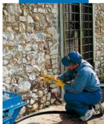
Inyección de consolidación con Mape-Antique I
