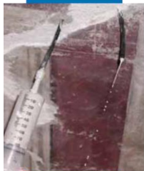
Inyección de Mape-Antique F21 con frescos
