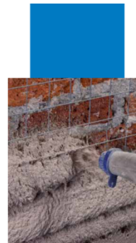
Aplicación por proyección de Mape-Antique Strutturale NHL
