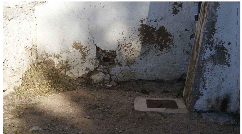
Figura 2.41 - Vista la composición del muro en la fachada principal. (David Clarí, 2014)
