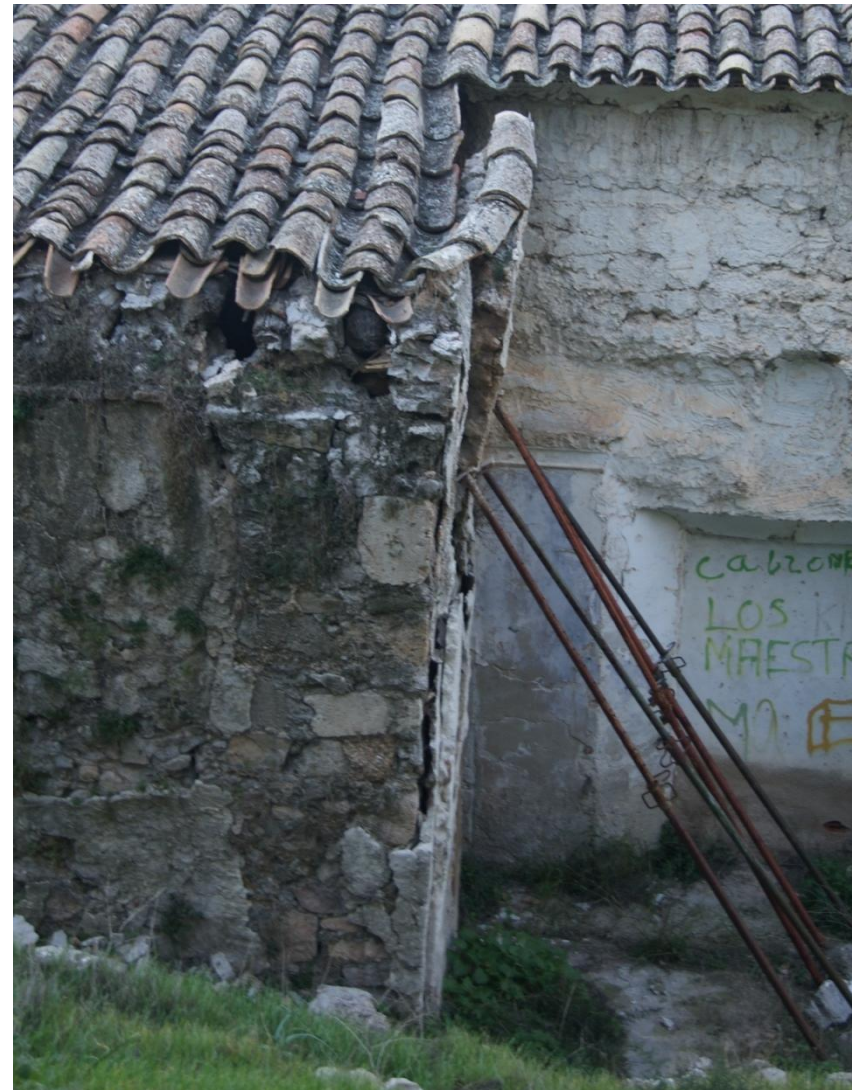
Figura 4.28 – Apuntalamiento en el muro de fachada sur. (David Clarí, 2014)
