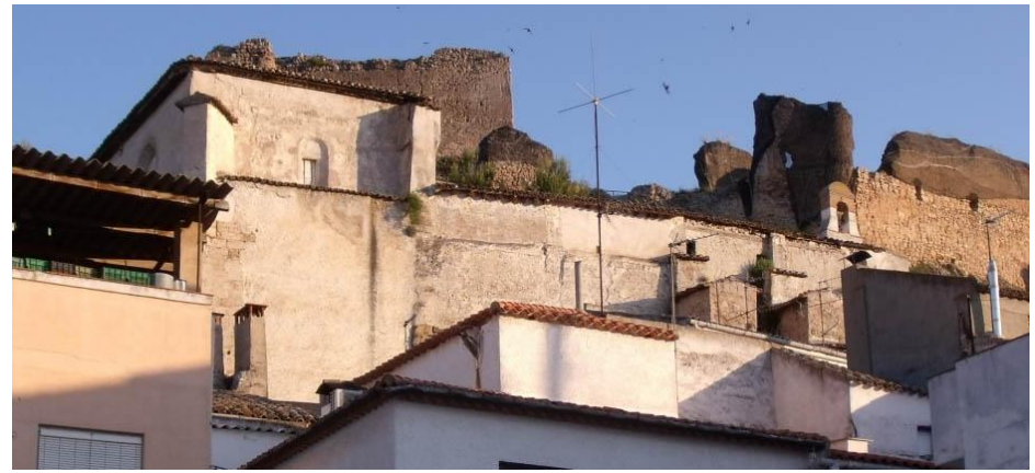
Figura 2.94 – Vegetales superiores en la fachada norte del edificio. (David Clarí, 2014)
