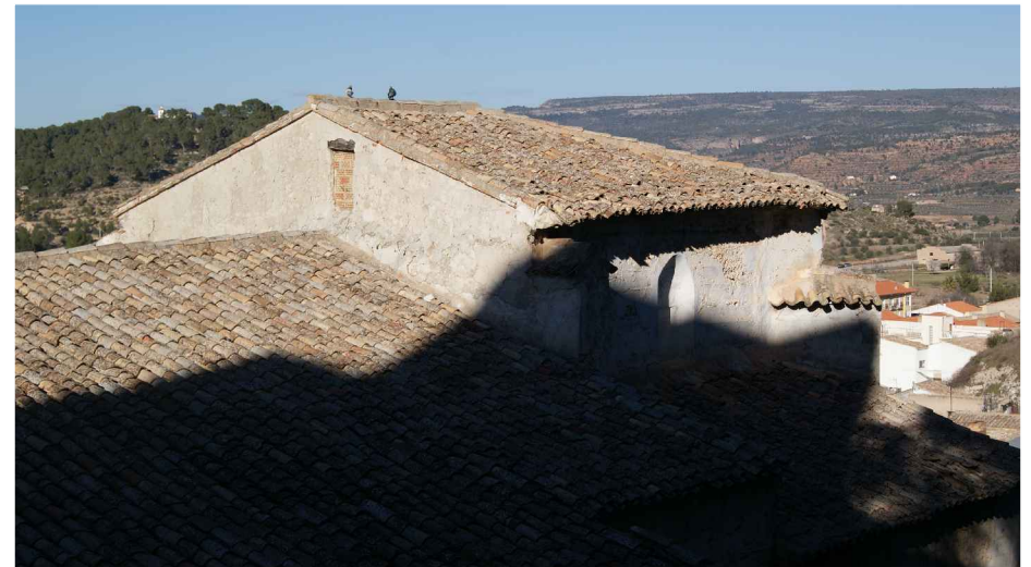
Figura 2.83 - Vista de la cubierta sobre el presbiterio del edificio. (David Clarí, 2014)
