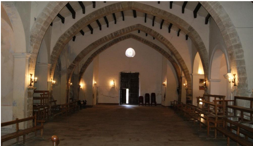
Figura 2.117– Arcos apuntados de la nave central. (David Clarí, 2014)
