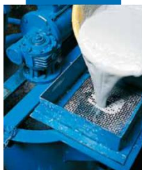
Relleno de la bomba de inyección con Mape-Antique I
