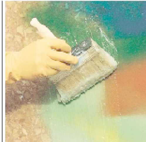
Aplicación de WallGard GRAFFITI REMOVER GEL sobre piedra natural
