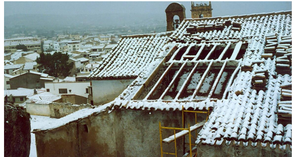
Figura 2.75 – Desmontado de cubierta en 1991. (Diputación de Valencia, 1991)
