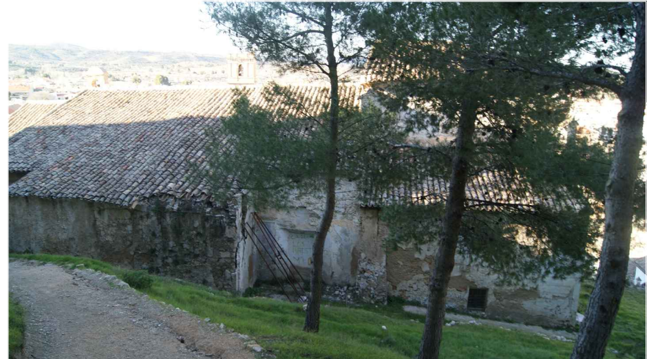
Figura 2.40 - Vista del muro de mampostería ordinaria en fachada sur. (David Clarí, 2014)
