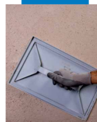
Fratasado de Mape-Antique Strutturale NHL
