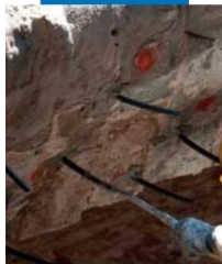
Inyección de Mape-Antique F21 en un muro de piedra
