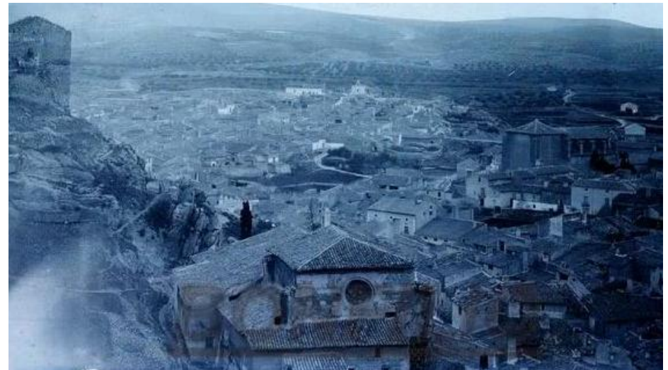
Figura 2.10 – Vista de las construcciones adosadas al presbiterio en los años 50. (Archivo de Bonfilio Martínez)
