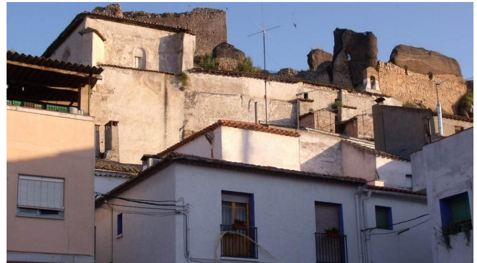
Figura 2.29 – Estado actual de la fachada norte del edificio. (David Clarí, 2014)
