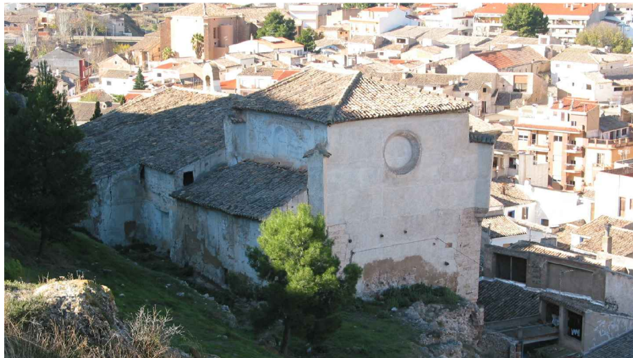
Figura 2.82 - Vista de la cubierta sobre el presbiterio del edificio. (GVA, 2002)
