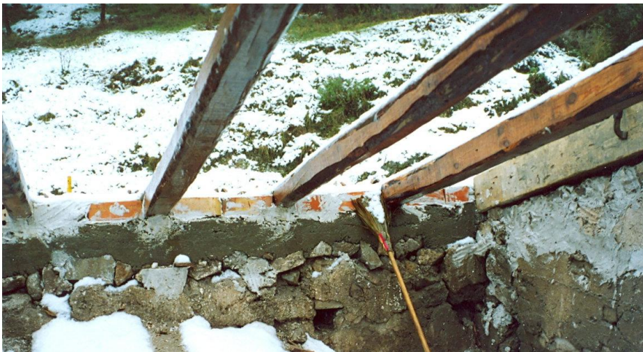
Figura 2.20 – Desmontado de cubierta en 1991. (Diputación de Valencia, 1991)
