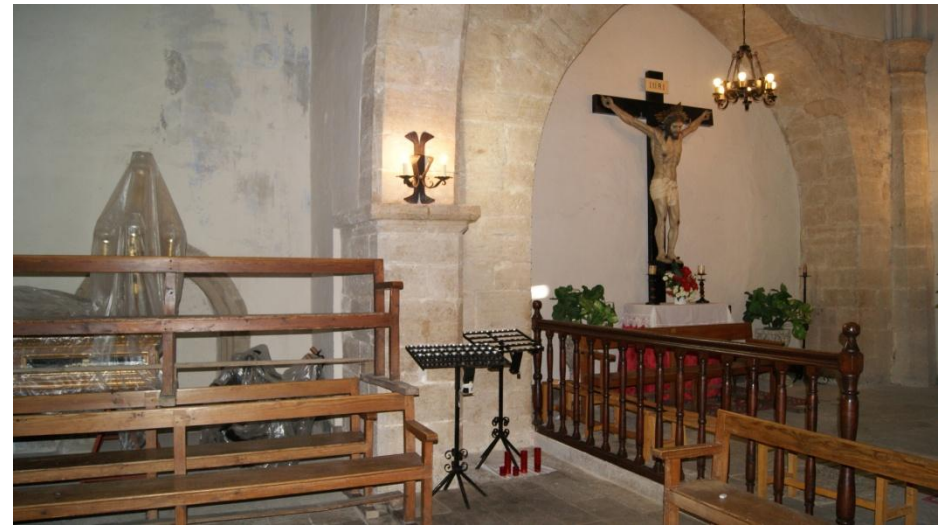
Figura 2.48 – Sillería en el interior de la fachada norte. (David Clarí, 2014)
