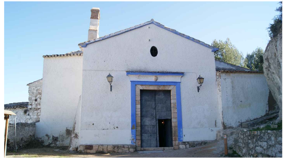
Figura 2.58 - Vista de la fachada principal del edificio. (David Clarí, 2014)
