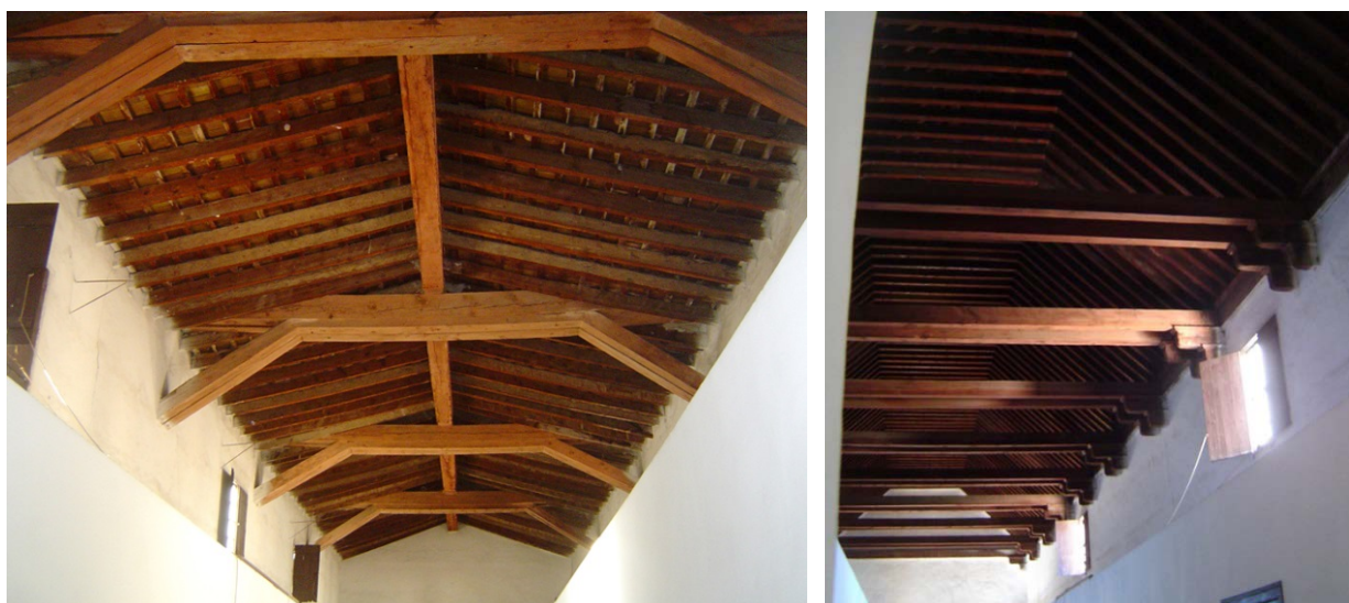
Figura 5.3. Armaduras de cubierta de los dos dormitorios del Real Monasterio de la Santísima Trinidad.
