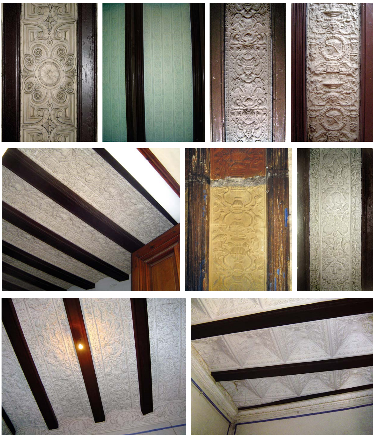
Figura 4.48. Paneles modulares de yeso. Palacio de los Centelles; Palacio de la familia Mercader; dos ejemplos en casa en calle Calatrava 3; Palacio de Malferit; Palacio en Herbés y tres ejemplos en el Castillo de Benisanó.
