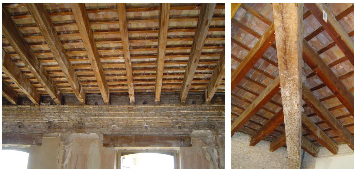
Figura 5.6. Ejemplos de cubiertas con estructura de jácenas.
