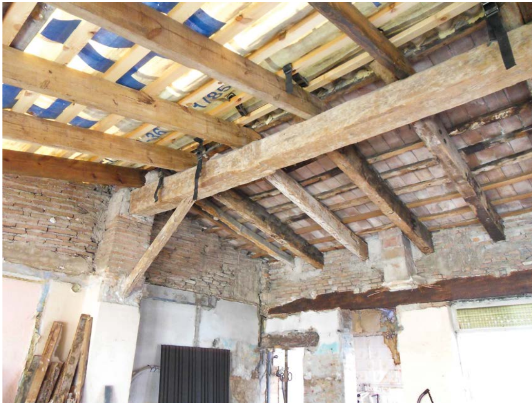
Figura 7.15. Estructura de la cubierta. Faldón este parcialmente desmontado durante las obras de restauración.
