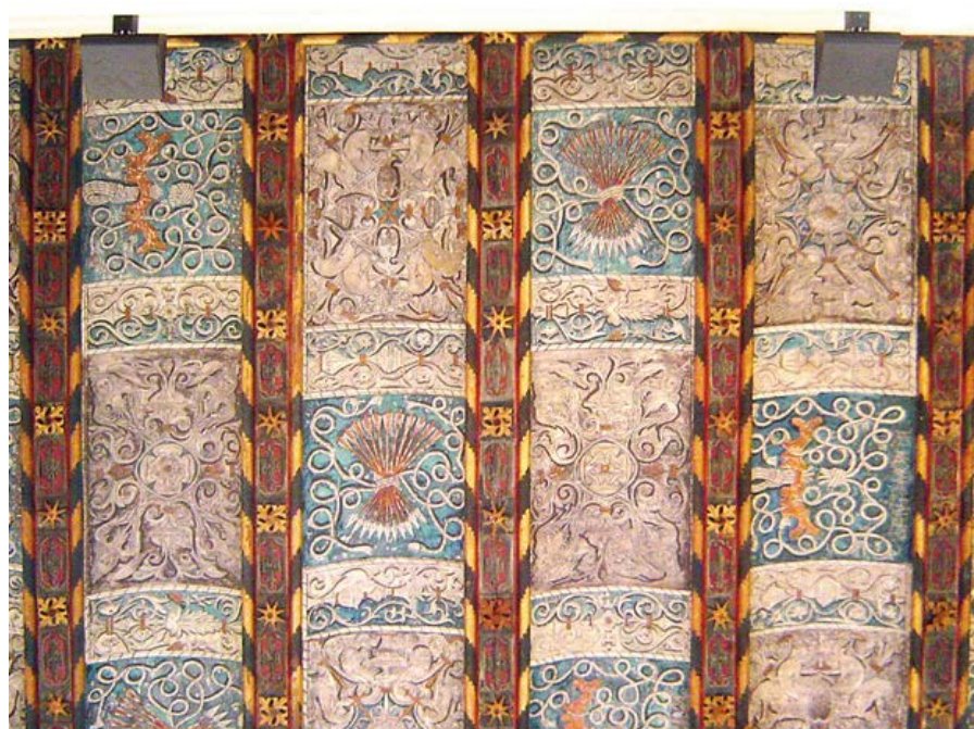
Figura 4.32. Forjados de revoltones decorado sobre la escalera principal del Palacio de la Aljafería en Zaragoza, 1488-1495. La decoración con influencias italianas tiene como motivos decorativos representaciones de yugos con nudos gordianos y flechas, símbolos respectivamente del rey Fernando II de Aragón y de la reina Isabel I de Castilla.
