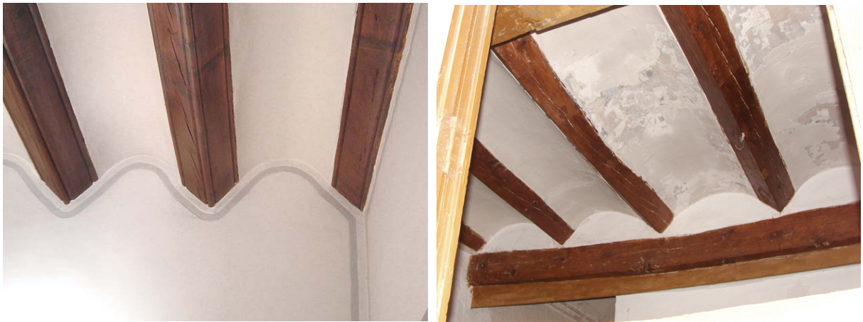
Figura 4.42. Forjado del Palacio del Intendente Pineda y de un taller en Calle Na Jordana.
