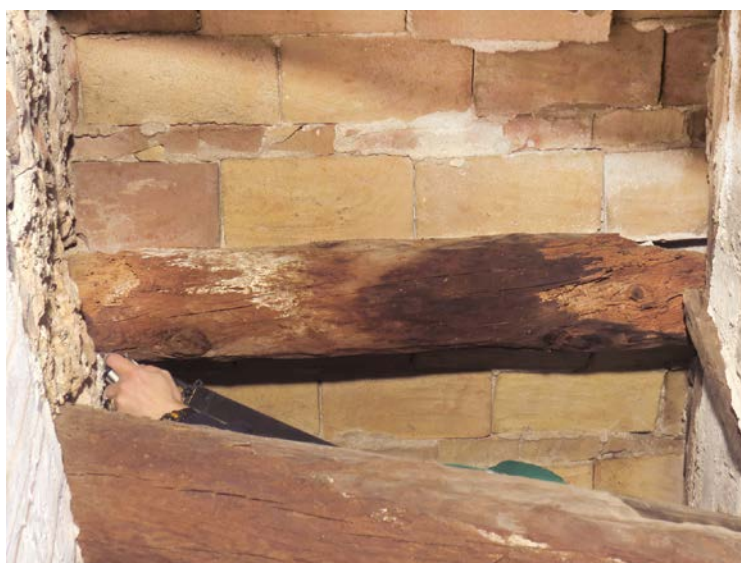
Figura7.57. Degradación en ambos apoyos de la viga 3A_41. (Grupo de investigación IRP-UPV – CNR-IVALSA)
