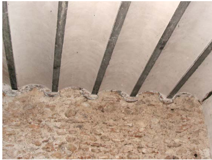
Figura 7.42. Forjado de vigas de hormigón. Habitación 0S. (Grupo de investigación IRP-UPV – CNR-IVALSA)
