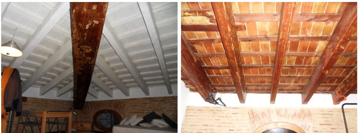
Figura 5.14. Edificio en calle de las Monjas (cub-07).
