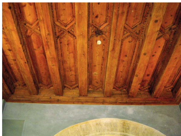
Figura 4.25. Ejemplo de forjado en el Palau d'En Bou
