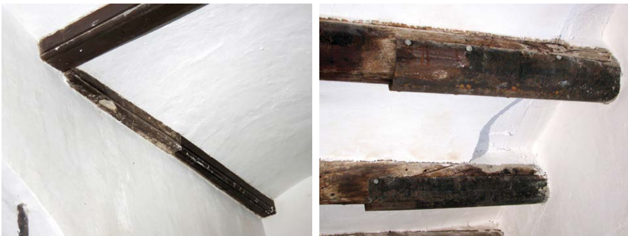
Figura 7.41. Intervenciones en las estructuras. Reparación con yeso de la viga 0L_22. Reparación con planchas metálicas en las vigas 1E_04-05. (Grupo de investigación IRP-UPV – CNR-IVALSA)
