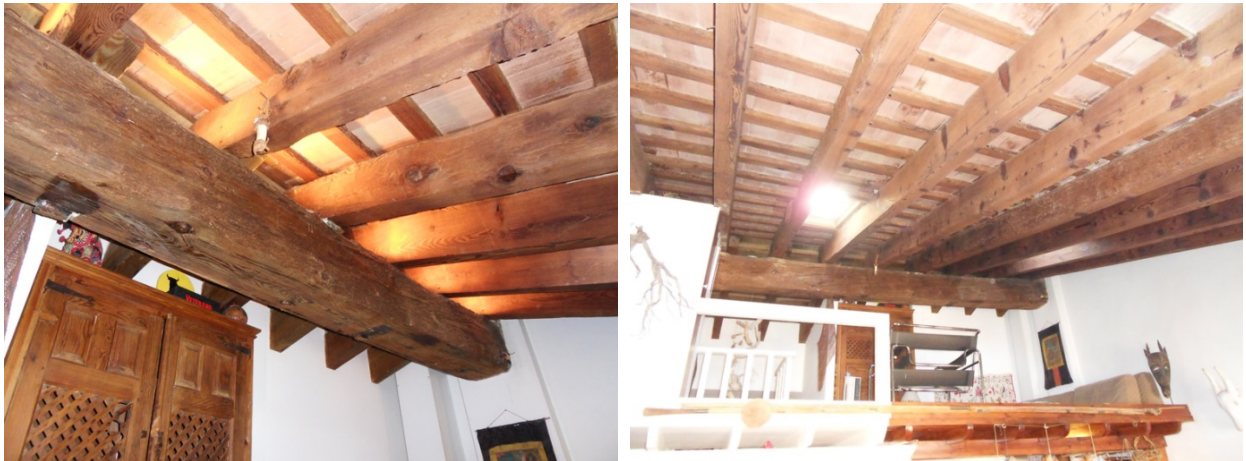
Figura 5.13. Edificio en la calle del Conde de Montornés 14 (cub-06).
