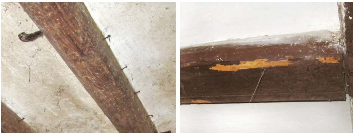
Figura 7.50. Ataque por anóbidos viga 0R_02 y degradación por cerambícidos en la viga 0N_04. (Grupo de investigación IRP-UPV – CNR-IVALSA)
