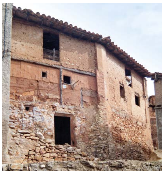
Figura 9.7. La viga que se ha podido datar en el año 1725 es la que se ve dispuesta horizontalmente en la fachada.
