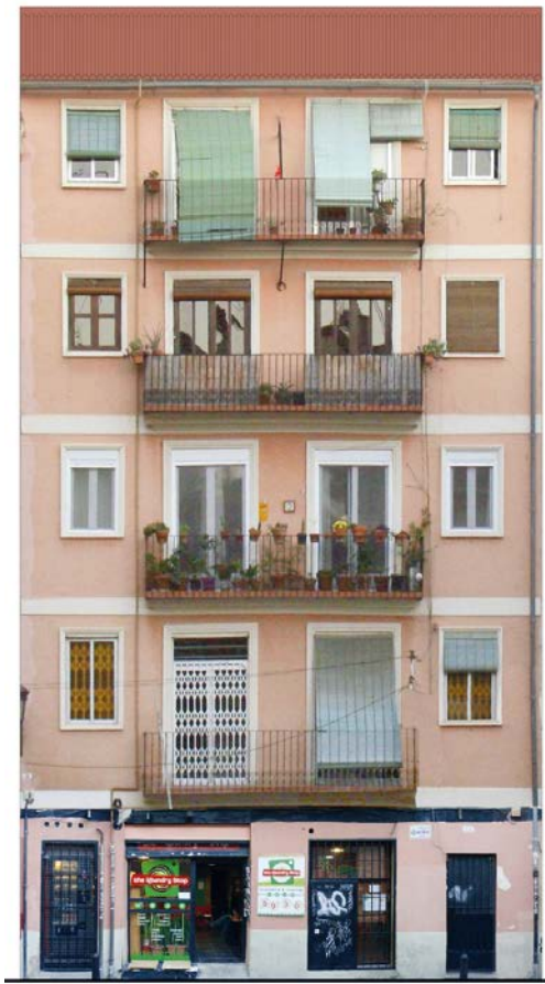
Figura 7.2. Fotoplano de la fachada principal del edificio de mediados del siglo XIX en el centro histórico de Valencia, en calle Baja 17, objeto de la inspección visual.
