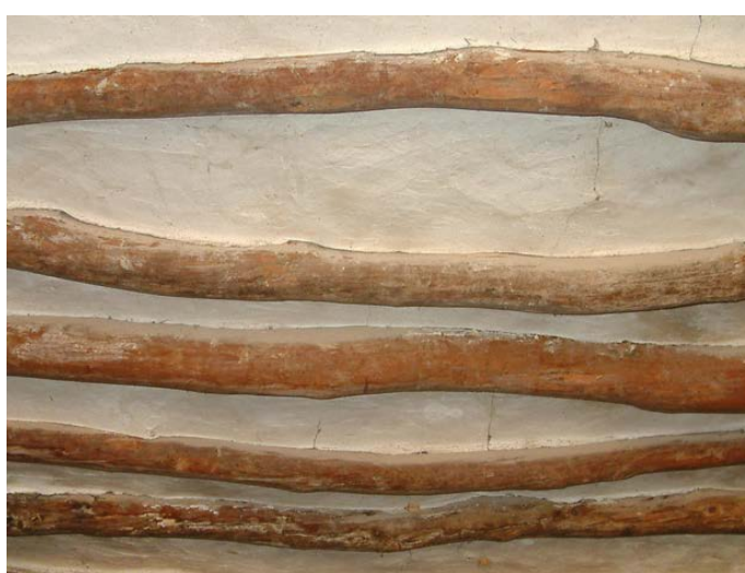
Figura 4.38. Viguetas muy torcidas utilizadas como elementos estructurales de un forjado de un edificio rural cerca de Elda, Alicante.
