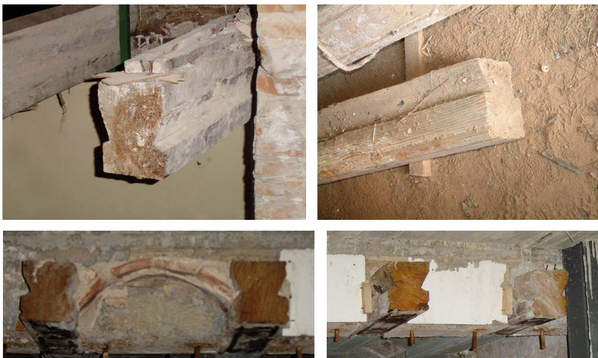
Figura 4.35 Ejemplos de vigas macizas.
