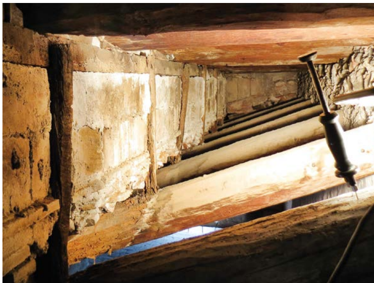
Figura 7.55. Murete entramado que sustenta la estructura volada que soporta el pasillo superior. (Grupo de investigación IRP-UPV – CNR-IVALSA)
