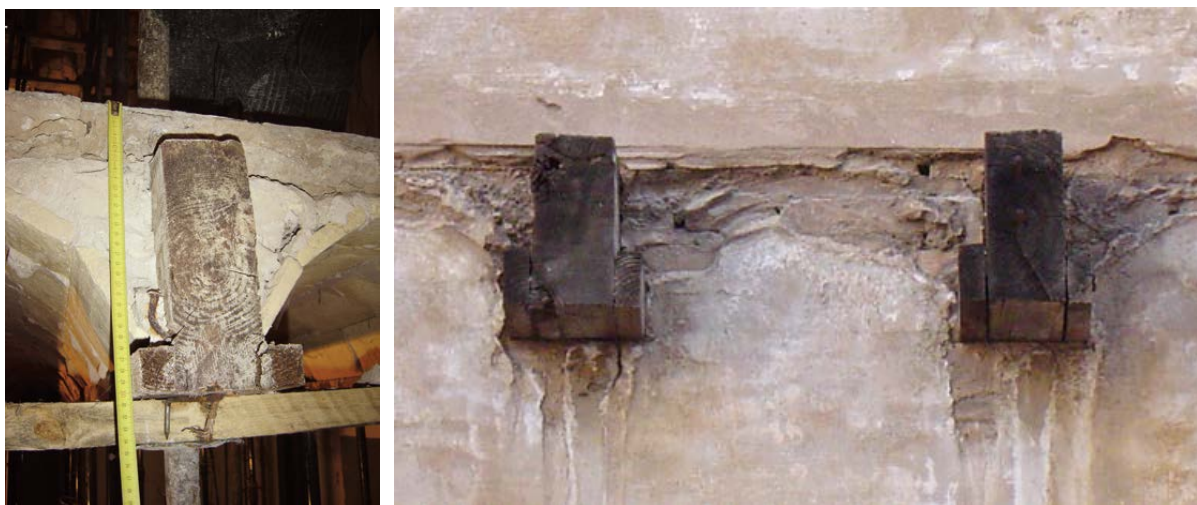
Figura 4.36 Ejemplos de vigas compuestas.
