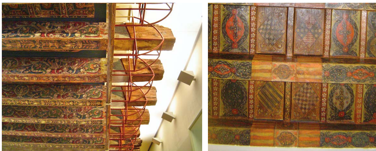
Figura 4.29. Forjados con superposición de capas decorativas. Palacio de Dos Aguas y Palacio de los Almirantes de Aragón.
