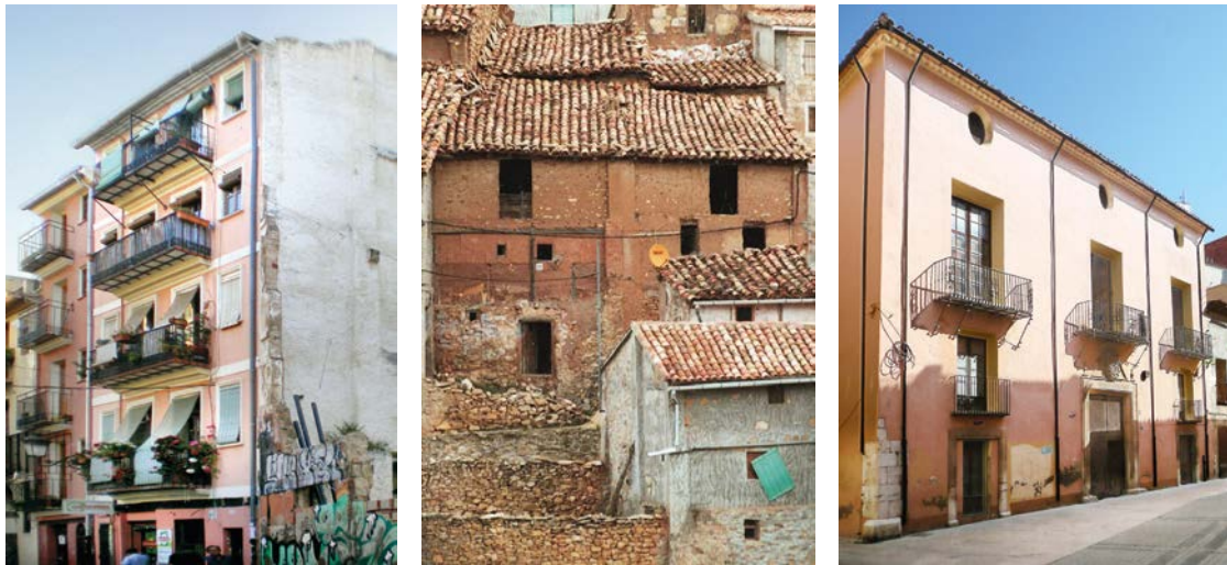
Figura 7.1. Fachadas de la vivienda de mediados del siglo XIX en calle Baja 17, Valencia, del edificio de arquitectura vernácula en la aldea de Sesga, en el Rincón de Ademuz, y del Palacio del Marqués de Benicarló, de la segunda mitad del siglo XVIII, situado en la ciudad de Benicarló. (Grupo de investigación IRP-UPV)
