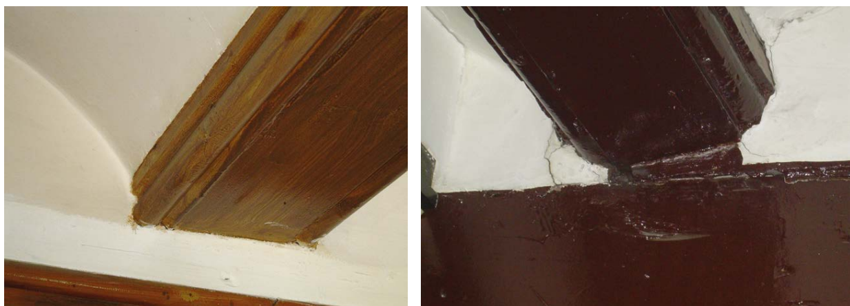
Figura 4.45. Tipos de moldura, a toro y a cuarto de bocel. Casa de la Acción Católica y Facultad de Teología
