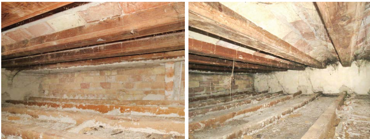
Figura 7.36. Espacio entre el forjado y el falso techo encima de la segunda planta. (Grupo de investigación IRP-UPV – CNR-IVALSA)
