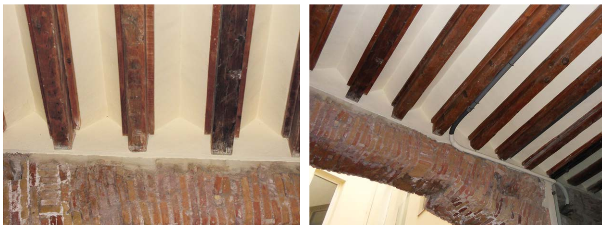
Figura 4.39. Forjado de la calle Caballeros 34.
