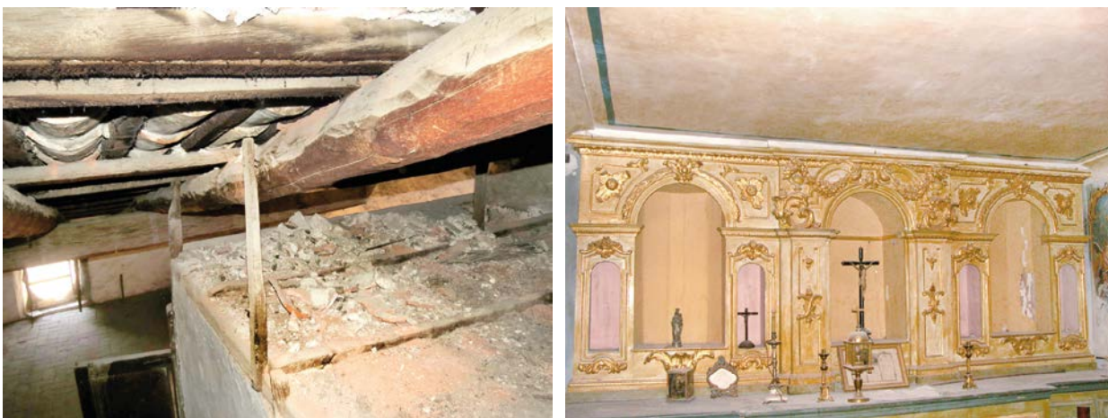
Figura 7.35. Vista del trasdós del falso techo de la habitación 3C. (Grupo de investigación IRP-UPV – CNR-IVALSA)
