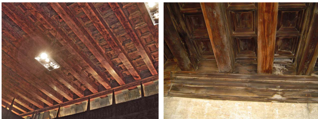
Figura 4.18. Forjados de casetones de la Sala de la Escribanía del Palacio de la Generalitat, y de la Lonja de los Canónigos de la Catedral.
