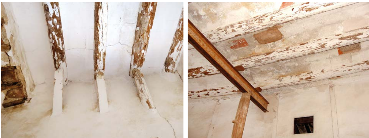
Figura 7.56. Ménsulas en los apoyos oeste de las vigas de 3J. Apuntalamiento en la habitación 3I. (Grupo de investigación IRP-UPV – CNR-IVALSA)
