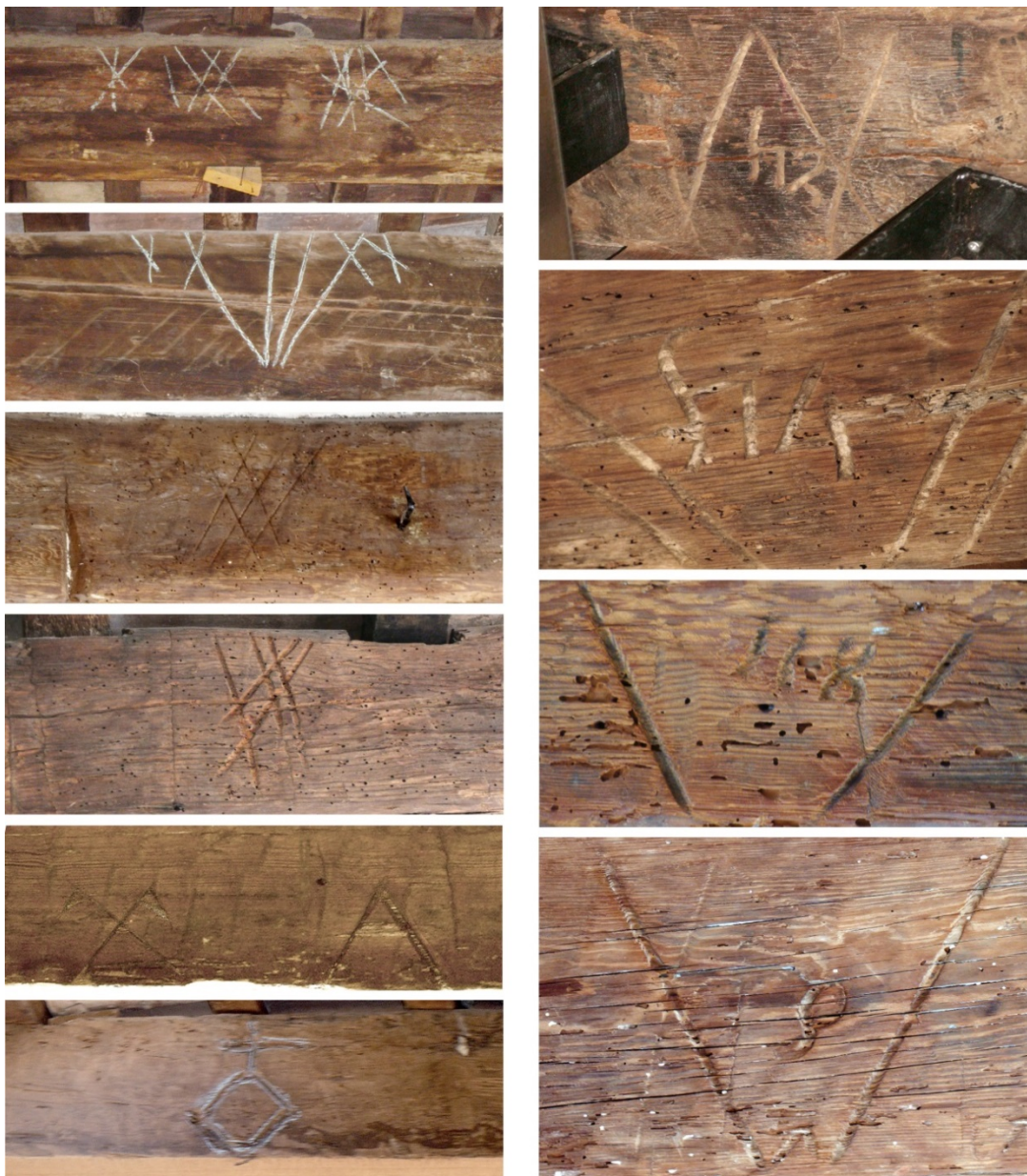
Figura 2.20. Ejemplos de marcas encontradas en forjados y cubiertas del centro de Valencia; a la izquierda posiblemente las de los transportistas o asentistas, a la derecha probablemente las de los marqueadores, se puede leer: f12, f14, f18 , para los diferentes tamaños de filas y q , tal vez para cuaderno . 122
