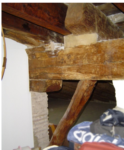
Figura 5.5. Ménsulas y tornapuntas sujetando una jácena. Palacio Lassala.
