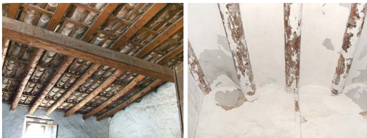
Figura 7.40. Estructuras de la cubierta. Habitaciones 3B y 3I. (Grupo de investigación IRP-UPV – CNR-IVALSA)
