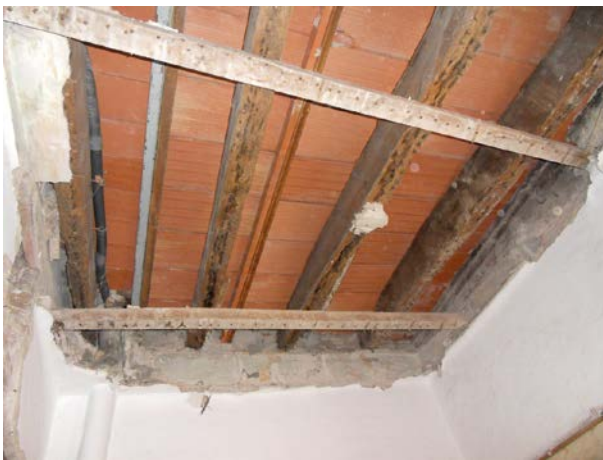
Figura 7.3. Vista del forjado de revoltones.
