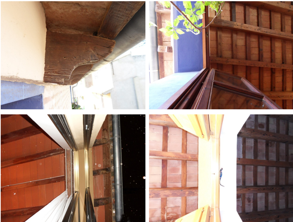
Figura 5.24. Simple geometría del alero del edificio de calle de San Ramon 5 (cub-08). Mismo edificio, separación entre los elementos estructurales de la cubierta y del alero. Dos ejemplos de continuidad entre estructura interior y volada Edificio de viviendas Calle Baja 3 (cub_10) y Edificio de viviendas en Calle del Conde de Montornés 14 (cub-06).
