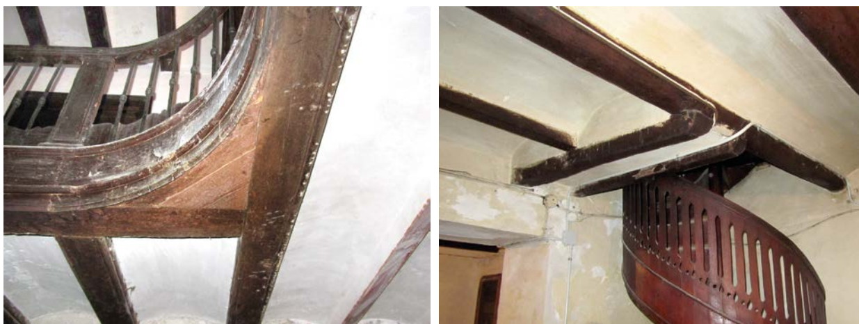
Figura 7.45 Nudo de conexión entre 0N_07, 0N_10 y 0N_08. Escalera de caracol en la habitación 0J y disposición de las vigas 0J_05-08. (Grupo de investigación IRP-UPV – CNR-IVALSA)
