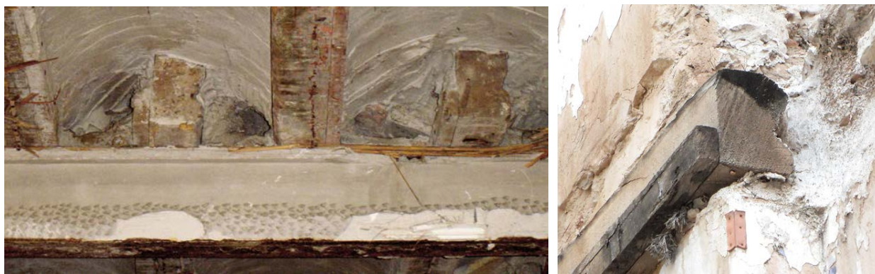
Figura 4.40. Ejemplo de vigas compuestas por dos partes
