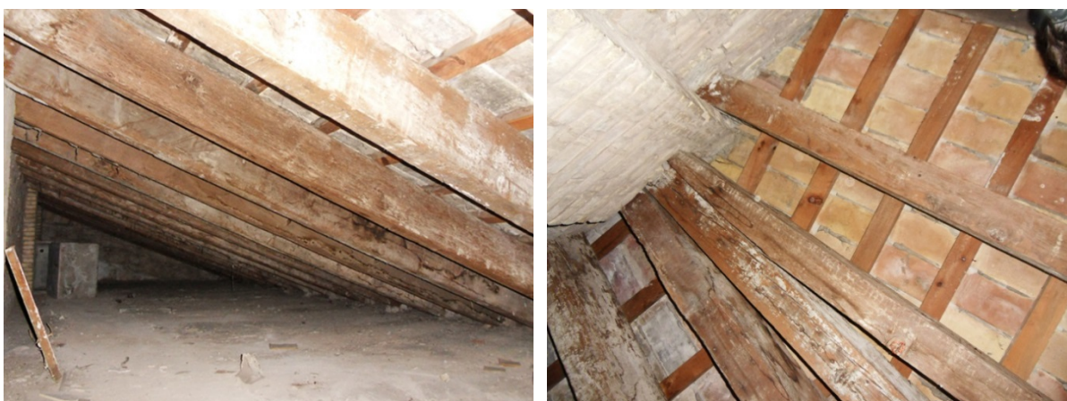
Figura 5.12. Edificio recayente a la calle del Portal de Valldigna (cub-04).
