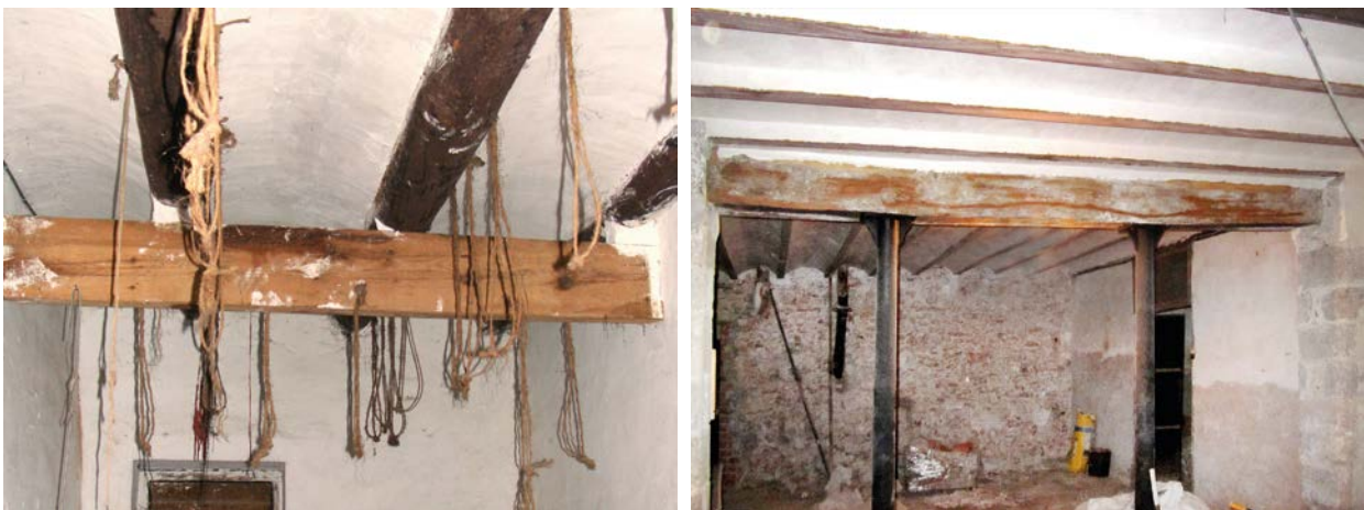
Figura 7.44. Vigas con apoyos intermedios. Habitación 0T y viga 0N_11. (Grupo de investigación IRP-UPV – CNR-IVALSA)
