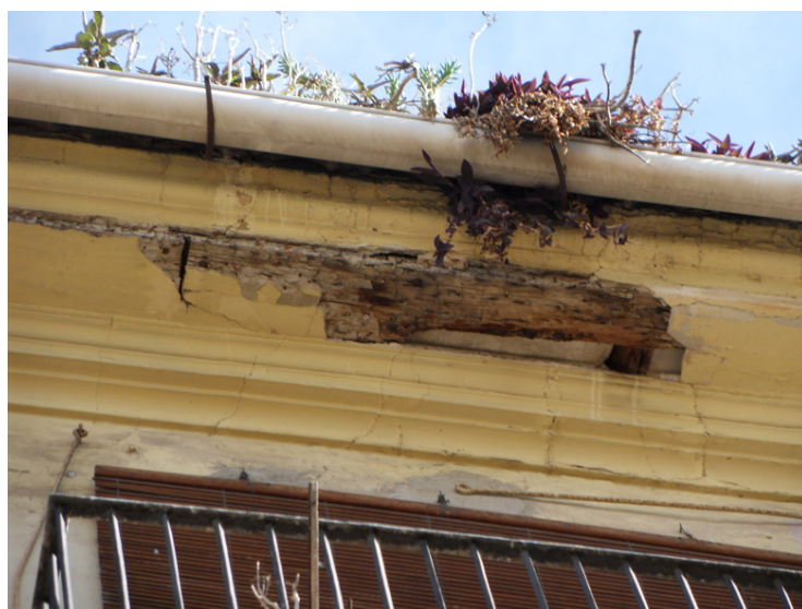
Figura 5.25. Estructura del alero de madera escondida detrás de una cornisa.
