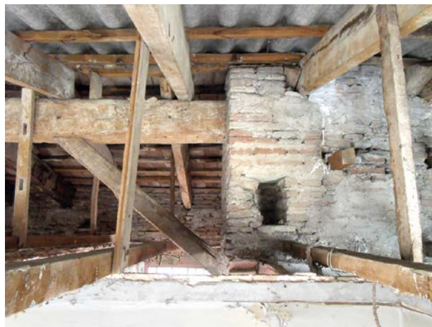
Figura 7.15. Estructura de la cubierta. Faldón este parcialmente desmontado durante las obras de restauración.
