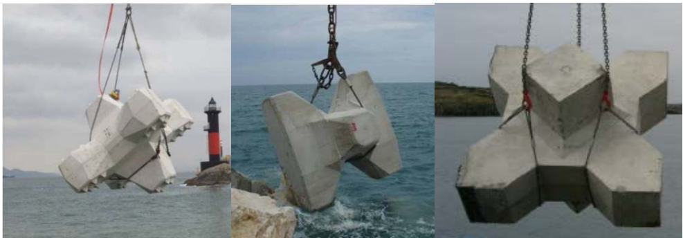
Figura 2.46. Accropode™ II (izquierda), Accropode™ I (centro) y Xbloc® (derecha) izados con eslingas. (Fuente: izq. y central Concrete Layer Innovations y dcha. Reedijk et al. 2005)
