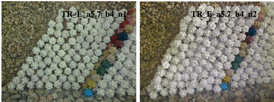
Figura 5.5. Manto construido con la malla de colocación estática para tronco recto a/D_n = 1.500 y b/D_n = 1.053 del dique de San Andrés. Primera capa (izq.) y segunda capa (dcha.). (Fuente: propia)
