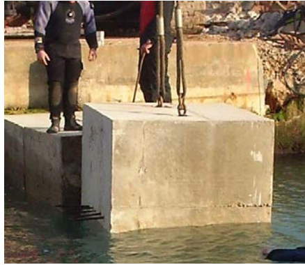
Figura 2.45. Colocación de bloque mediante cadenas conectadas a asas embebidas. (Fuente: empresa SATO)
