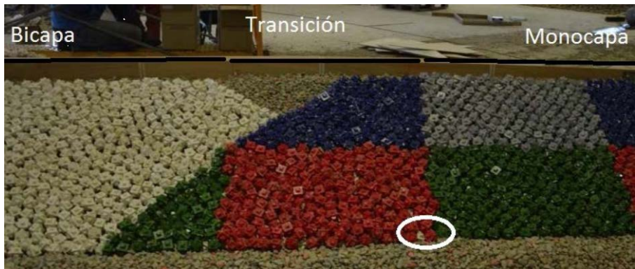
Figura 3.12. Avance de la protección monocapa sobre filtro de Cubípodos. (Fuente: Manual del Cubípodo 2015)
