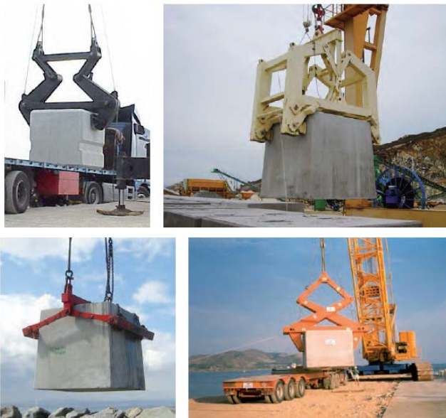
Figura 2.48. Distintos tipos de pinzas para manipulación de bloques de hormigón cúbicos. (Fuente: Guía de Buenas Prácticas para la Ejecución de Obras Marítimas, 2008)
