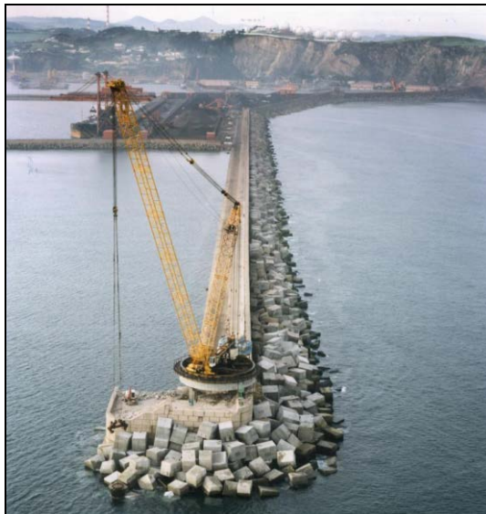
Figura 2.37. Grúa de gran capacidad sobre raíles durante la construcción del dique Príncipe de Asturias (Puerto de Gijón). (Fuente: empresa SATO)
