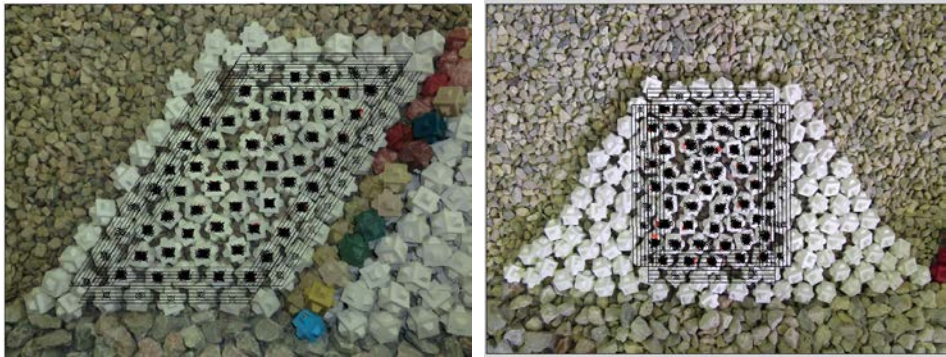
Figura 4.21. Desplazamiento del área de referencia para el conteo de unidades. Tramo recto (izq.) y tramo curvo (dcha.). (Fuente: propia)
