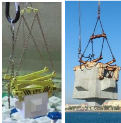
Figura 4.19. Pinza doble de colocación de Cubípodos. A escala (izq.) y real (der.). (Fuente: propia)
