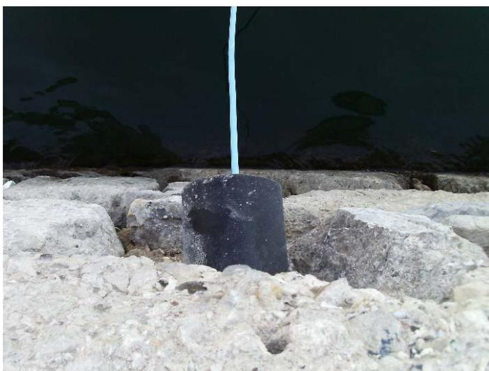
Fotografía 19. Detalle del extremo del tubo pasacables situado en la pared vertical del muelle próxima a la jaula.
