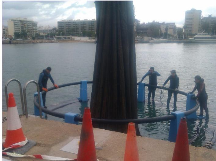
Fotografía 8. Cambio de red, paso 2. Se va saltando la red de la barandilla y se va amarrando al gancho de una grúa. Una vez se ha colgado completamente la red, se eleva y se extrae al muelle.
