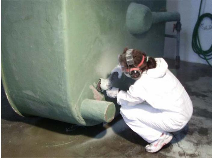
Fotografía 26. Reparación tanques para el mantenimiento de las doradas. Lijado de los tanques con una radial.
