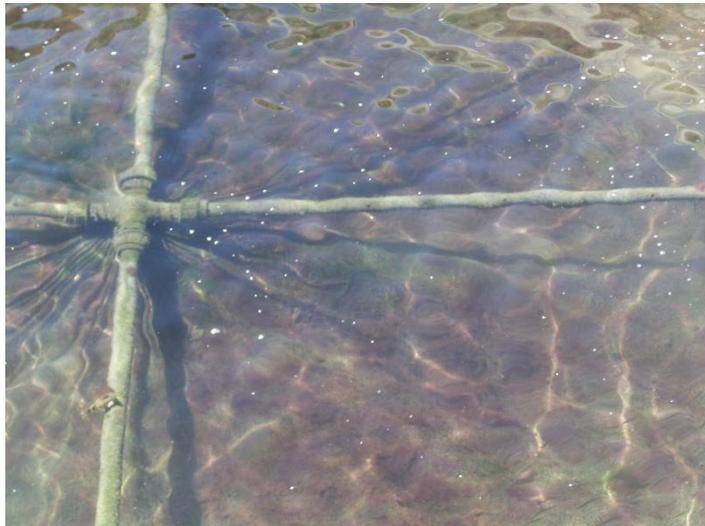
Fotografía 25. Red de la estructura secundaria a finales del mes de julio de 2013, donde se puede apreciar una gran cantidad de organismos adheridos que ocasionan el cierre de la luz de la malla.
