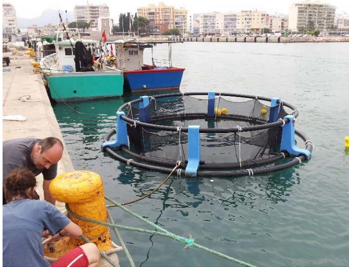
Fotografía 4. Montaje de la jaula experimental, paso 4. Se fija la jaula a los norayes contiguos, permitiendo cierto movimiento de la jaula para evitar daños bajo condiciones meteorológicas adversas. Se instalan boyas que señalizan la instalación de la jaula.
