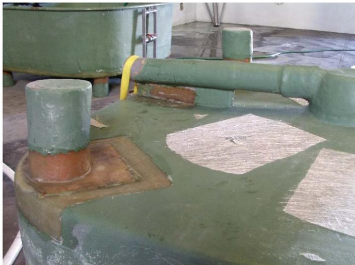
Fotografía 29. Reparación tanques para el mantenimiento de las doradas. Una vez lijados se aplica fibra de vidrio con resina para prevenir fugas de agua.
