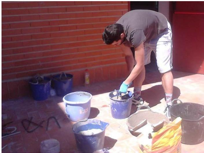
Fotografía 5. Fabricación de los muertos empleados para mantener la posición de la jaula y las boyas de señalización.
