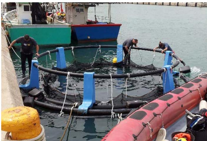
Fotografía 2. Montaje de la jaula experimental, paso 2. Se introduce la red y el anillo anticorriente en el agua, y se amarra el anillo anticorriente al anillo de flotación con una separación entre ambos de unos 5 m. Se fija la red al anillo de flotación.
