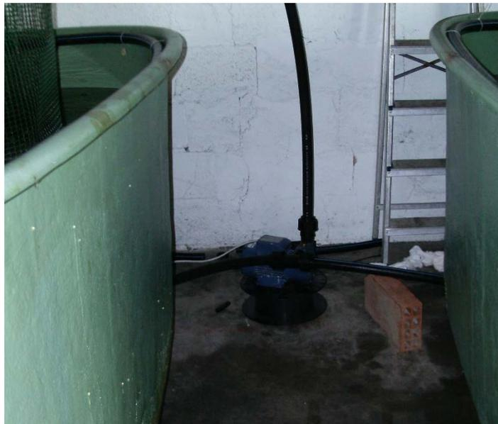
Fotografía 31. Bomba de superficie empleada para la recirculación de agua de los dos tanques.
