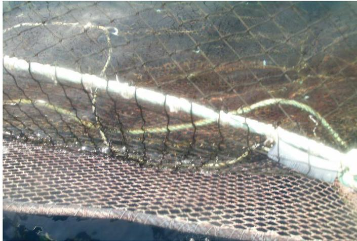
Fotografía 44. Dispositivo de Piagua. Detalle de la red del lateral de la jaula. Presenta movimiento en oblicuo debido a las corrientes.
