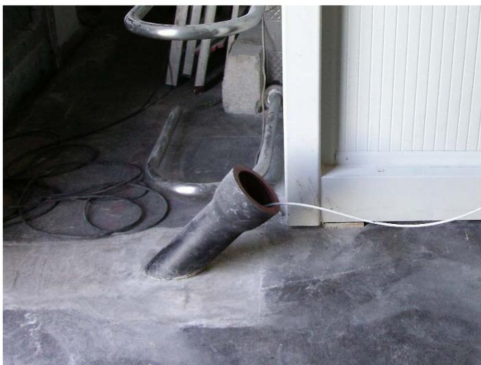
Fotografía 18. Detalle del extremo del tubo situado en el interior del tinglado que se emplea para llevar los cables hasta la jaula.
