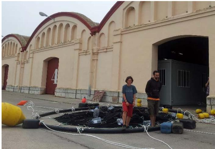
Fotografía 1. Montaje de la jaula experimental, paso 1. En tierra se amarra la parte más profunda de la red al anillo anticorriente. Se emplean bidones llenos de agua para proporcionar flotabilidad a la red y al anillo y poder así realizar el montaje desde la superficie.
