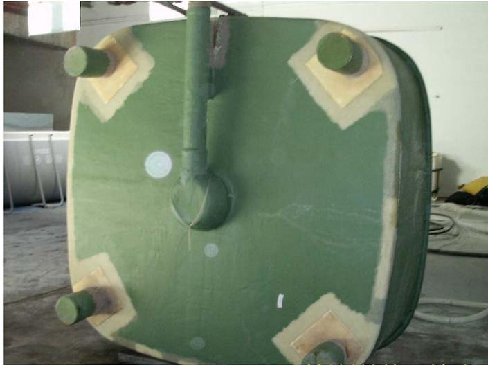
Fotografía 28. Reparación tanques para el mantenimiento de las doradas. Lijado de la parte interna del tanque.
