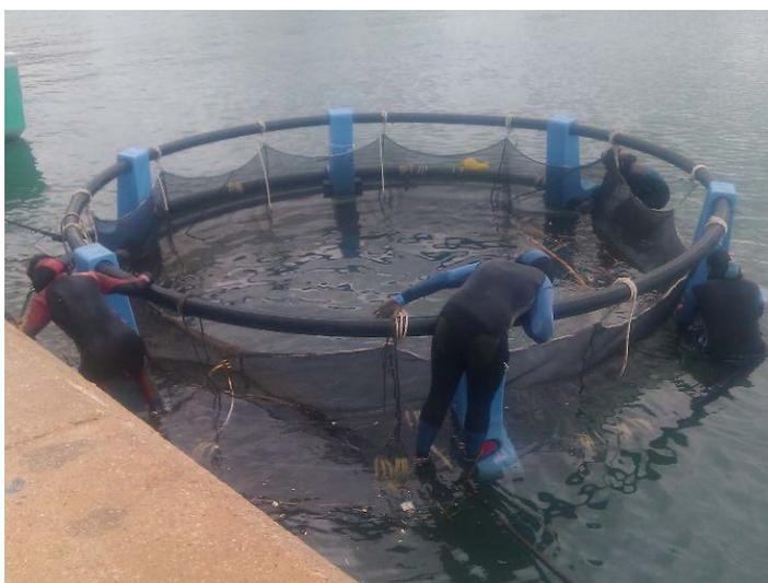
Fotografía 7. Cambio de red, paso 1. Se sube a mano el anillo anticorriente y se fija próximo al anillo de flotación. A continuación se suelta la red del anillo anticorriente y del anillo de flotación, quedando asegurado de la barandilla.
