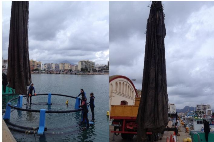
Fotografía 9. Cambio de red, paso 3: Una vez se tiene la red en el muelle y se sostiene en alto con ayuda de la grúa y se limpia con una hidrolimpiadora.
