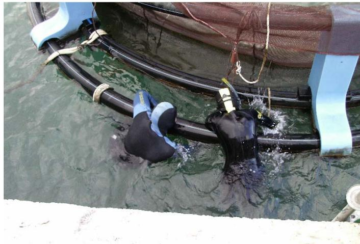
Fotografía 13. Tareas de mantenimiento de la jaula: eliminación de mejillones y otros organismos adheridos a los anillos y a los cabos, y comprobación de la red, los cabos, los muertos y las boyas de señalización.
