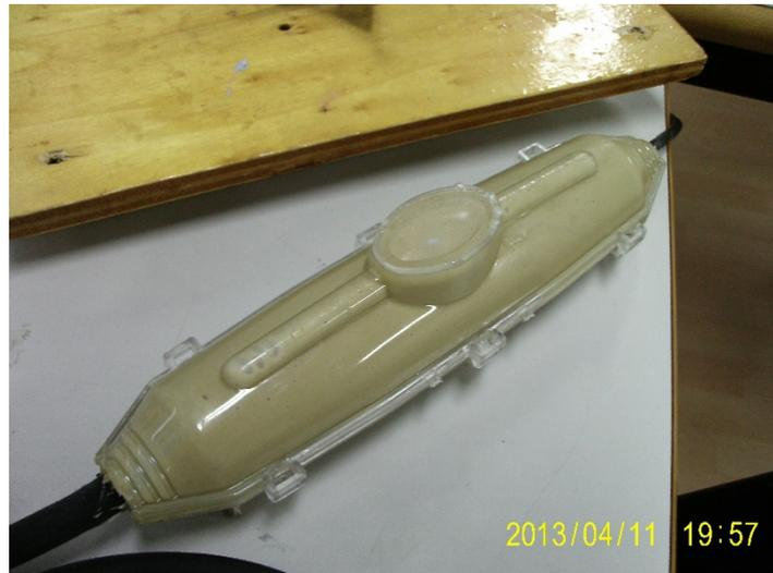
Fotografía 20. Detalle del tipo de unión empleada para empalmar el cable de los transductores.
