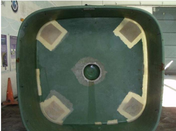
Fotografía 27. Reparación tanques para el mantenimiento de las doradas. Lijado de la parte interna del tanque.
