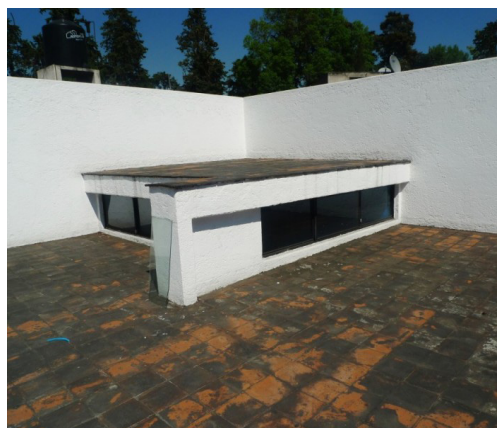
Fig. 57: Lucernario desde cubierta. Casa Gilardi.
