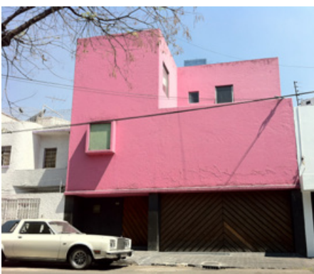
Fig. 39: Fachada Casa Gilardi. Google maps.
