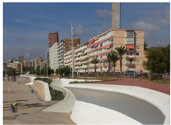
Imagen 69: Rampa que comunica playa y paseo Fotografía propia
