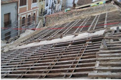
Ilustración 33: Levantamiento techumbre
