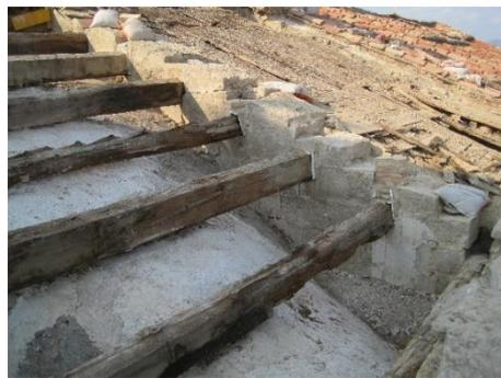
Ilustración 82: Protección cabezas vigas
