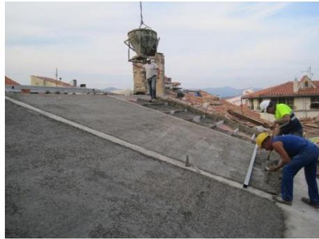
Ilustración 80: Mortero regulación y nivelación
