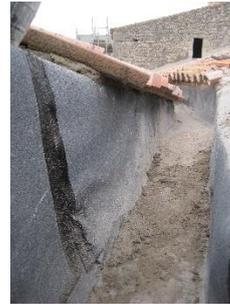
Ilustración 124: Colocación laminas
