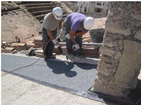
Ilustración 83: Lamina impermeabilización
