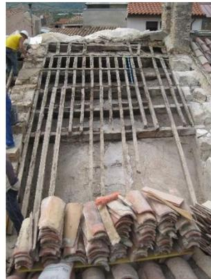
Ilustración 76: maderas en pie, acopio tejas
