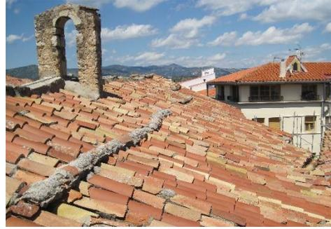
Ilustración 34: Espadaña y cubierta con teja árabe
