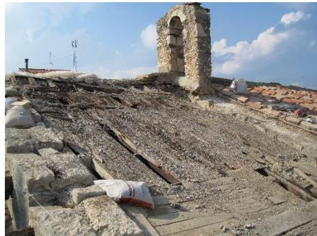
Ilustración 74: desmontaje cubierta, tejas
