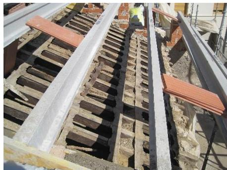
Ilustración 78: Viguetas pretensadas
