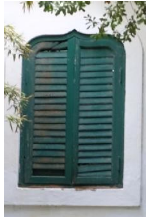
Fig. 50 Arco conopial, fachada. Fuente : Propia
