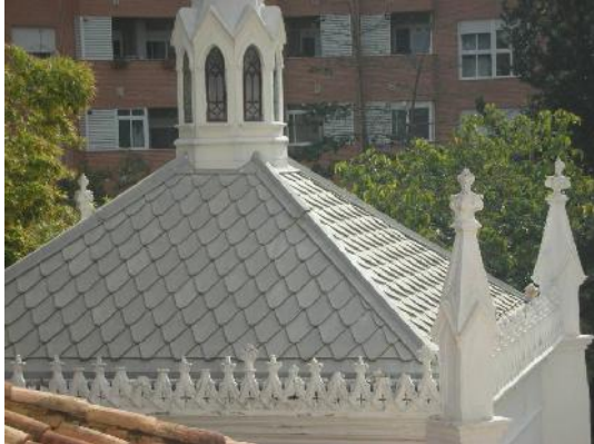
Fig. 30 Cubierta. Fuente: Propia
