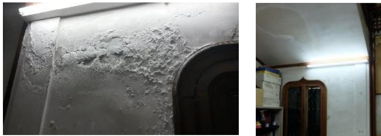
Fig. 63 Unión de la casa principal al núcleo central. Fuente: Propia.
