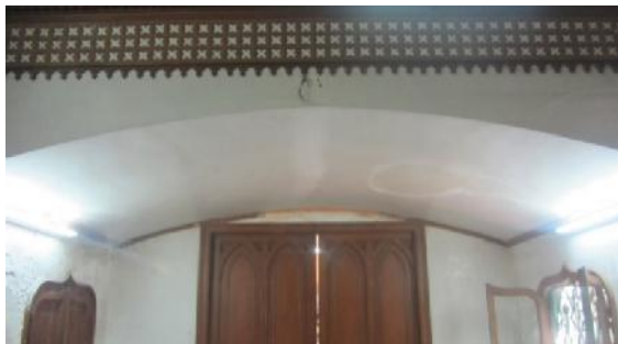
Fig. 34 Bóveda rebajada Zona de Acceso. Fuente: Propia.
