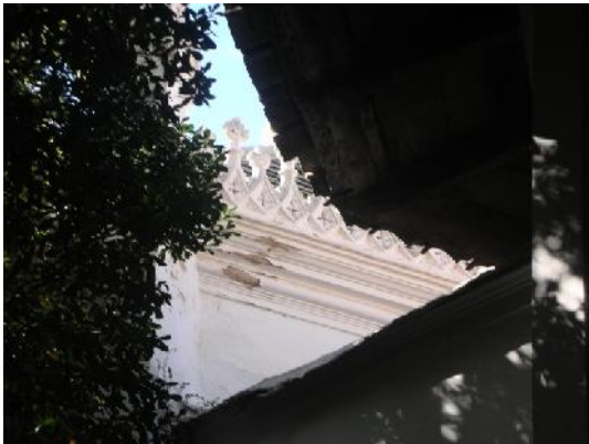
Fig. 61 Cubierta zona de unión casa principal. Fuente: Propia.
