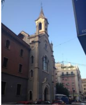
Fig. 21 Fachada actual antigua Casa de la misericordia. Fuente: Propia.
