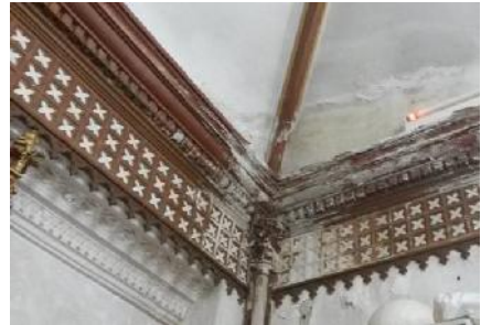
Fig. 69 Encuentro de la cornisa. Fuente: Propia.
