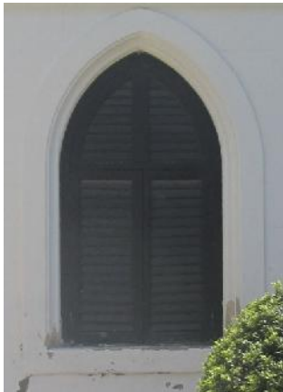
Fig. 49 Arco Apuntado, fachada. Fuente : Propia
