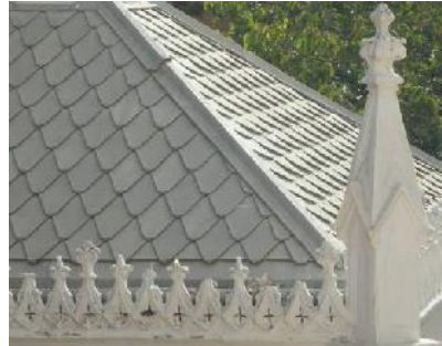
Fig. 55 Crestería Trenor. Fuente: Propia.
