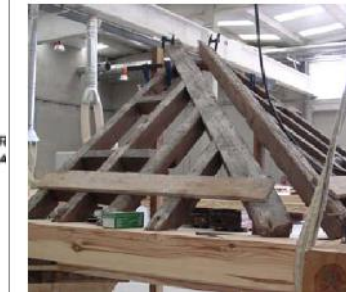
Fig. 46Detalle estructura bóveda. Fuente: TD
