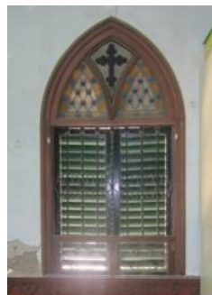
Fig. 32 Ventana corredera Fuente: Propia.
