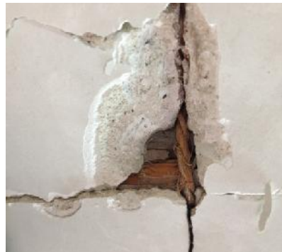
Fig. 48 Bóveda capilla Trenor. Fuente : Propia
