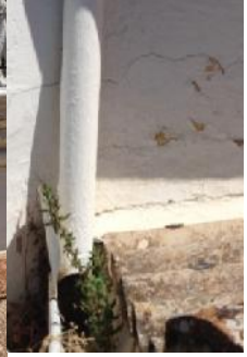
Fig. 60 Detalle bajante cubierta principal 1. Fuente: Propia.
