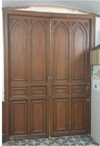
Fig. 53 Puerta acceso casa principal. Fuente: Propia
