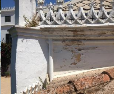
Fig. 59 Detalle bajante cubierta principal 1. Fuente: Propia.
