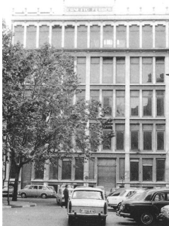
Fachada de los almacenes Ernesto Ferrer cuya composición muestra la estructura reticulada de hormigón armado. Demetrio Ribes 1918.
