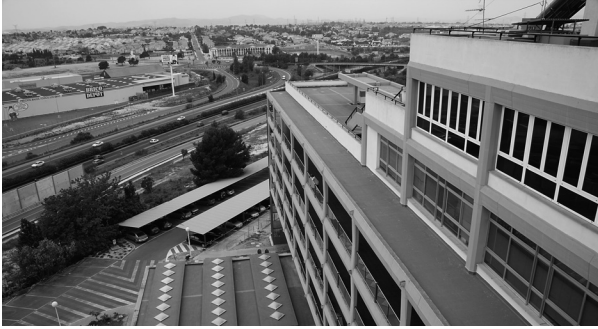
Vista volumen gimnasio con marquesina de entrada atirantada. Fot. Ximo Michavila.
