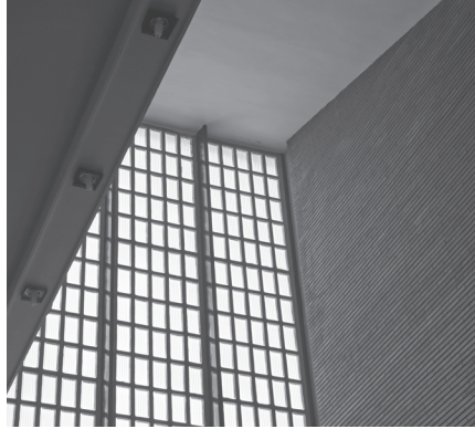
Detalle apoyos arranque estructura en muro interior. Fot. Ximo Michavila
