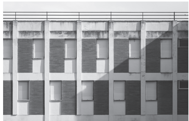
Detalle composición de fachada en planta de habitaciones. Fot. Ximo Michavila
