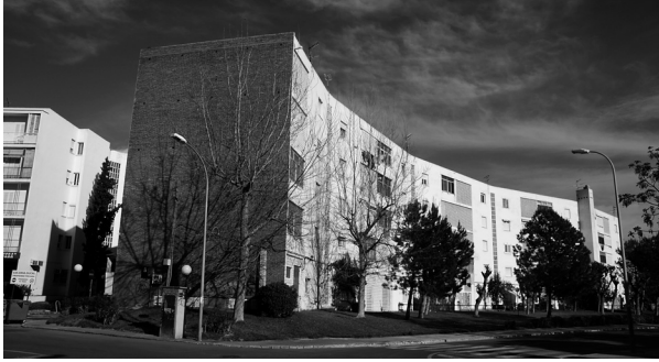
Vista fachada noroeste del bloque E. Fot. Ximo Michavila
