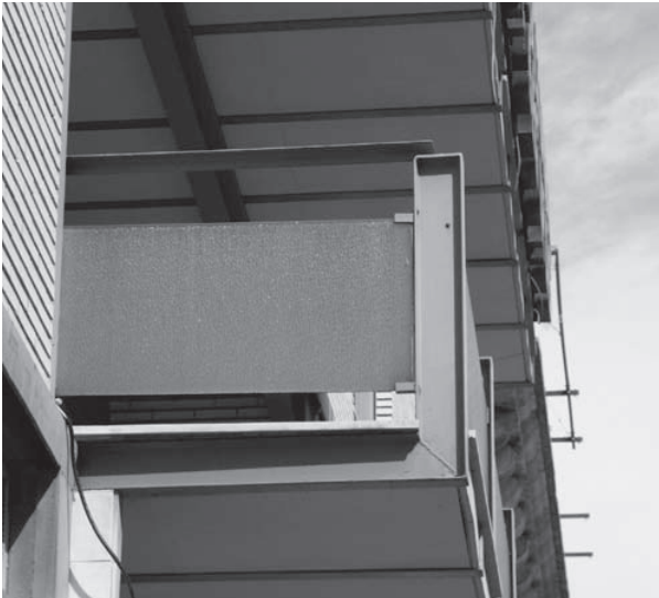
Detalle barandilla balcón principal. Fot. Ximo Michavila.
