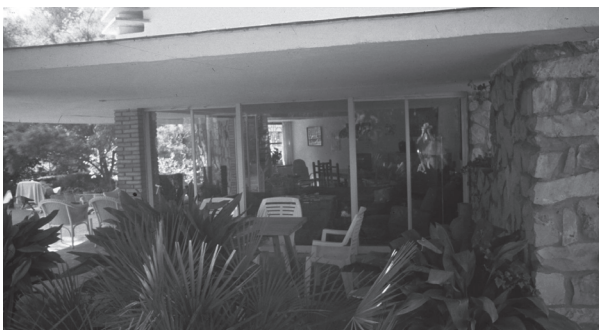
Detalle muro de mampostería. Fot. Juan José Estellés
