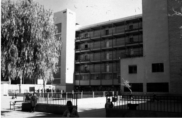
Fachada sur. Fot. Ximo Michavila.
