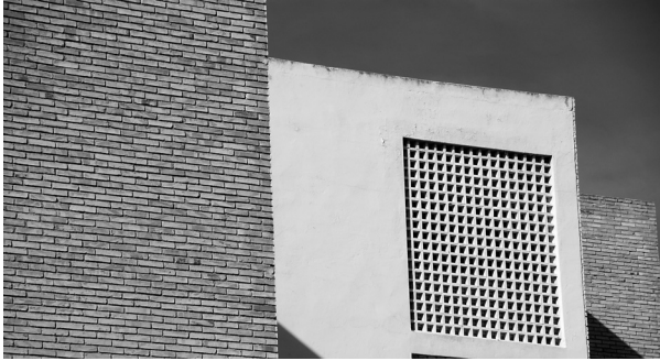
Detalle fachada bloque A y B. Fot. Ximo Michavila
