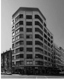
Edificio Llopis. Calle San Vicente, 51. R. Roso. 1935.
