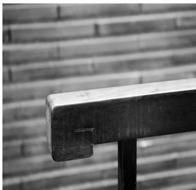
Detalle de barandillas y pasamanos. Fot. Ximo Michavila
