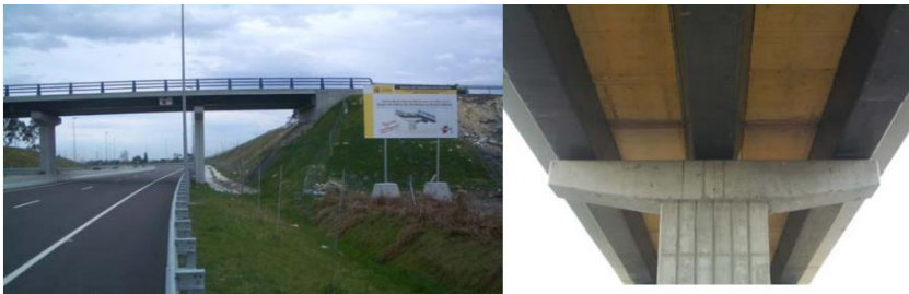
Fig. 1.1 Primer puente híbrido construido en España (2004). Acciona Infraestructuras.
