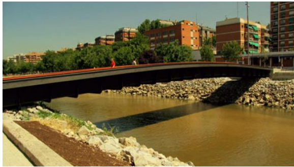
Fig. 2.34 Pasarela peatonal en Madrid sobre el río Manzanares, 2012. ( http://www.fomento.gob.es/AZ.BBMF.Web/documentacion/pdf/A24849.pdf )
