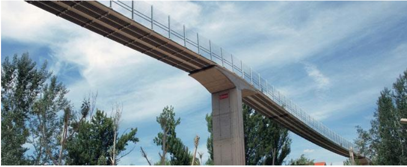
Fig. 2.33 Pasarela peatonal en Cuenca sobre el río Júcar, 2012 ( http://www.mpt.gob.es/fondosinversionlocal/castilla-la-mancha/cuenca.html ).
