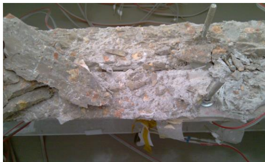
Fig. A1.12 Detalle de la interfase más débil resina epoxi-hormigón.
