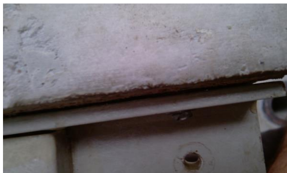
Fig. A1.16 Detalle de la rotura a rasante en el ensayo a flexión 4 puntos de la viga híbrida HYB_HRF_30.
