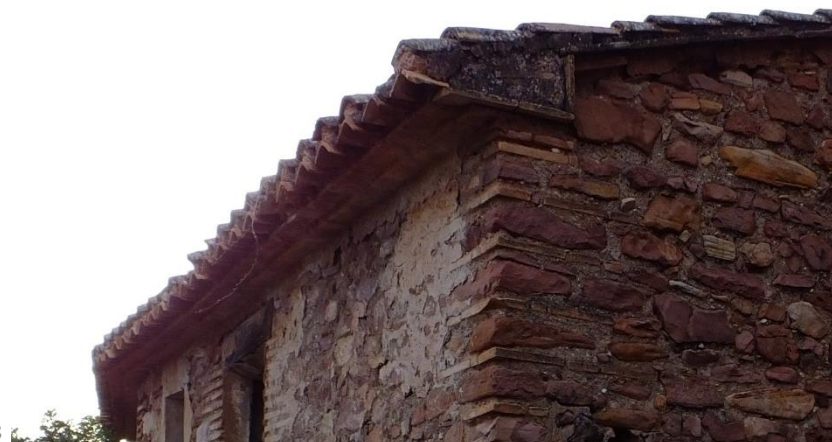
Fig. 57. Alzado sureste. Detalle del alero de rasilla. Fig. 58. Esquina este de la alquería. Solución constructiva de la cubierta.
