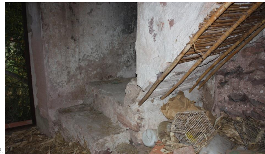
Fig. 27. Alzado interior sureste, cambio de sección en muro medianero (tapia). Fig. 28. Detalle escalera de acceso a la célula c3.
