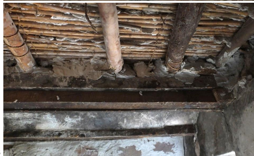
Fig. 55. Forjado unidireccional de la célula c1 de la alquería. Fig. 56. Forjado de rollizos de madera y cañizo de la célula c3.
