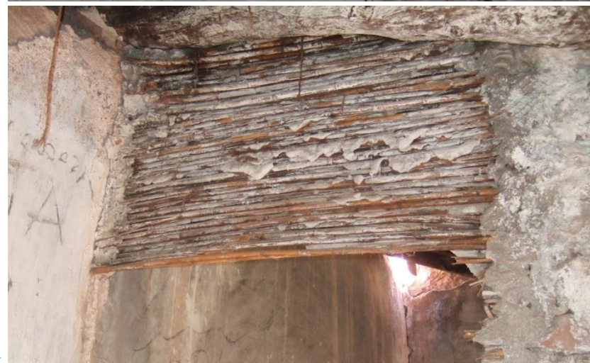
Fig. 63. Distribución de las jácenas de madera respecto a la posición del muro de mampostería que independiza la cota cero de las células c1 y c2. Fig. 64. Tabique realizado con superficies de cañizo revestidas de yeso ubicado en el nivel superior de la alquería.
