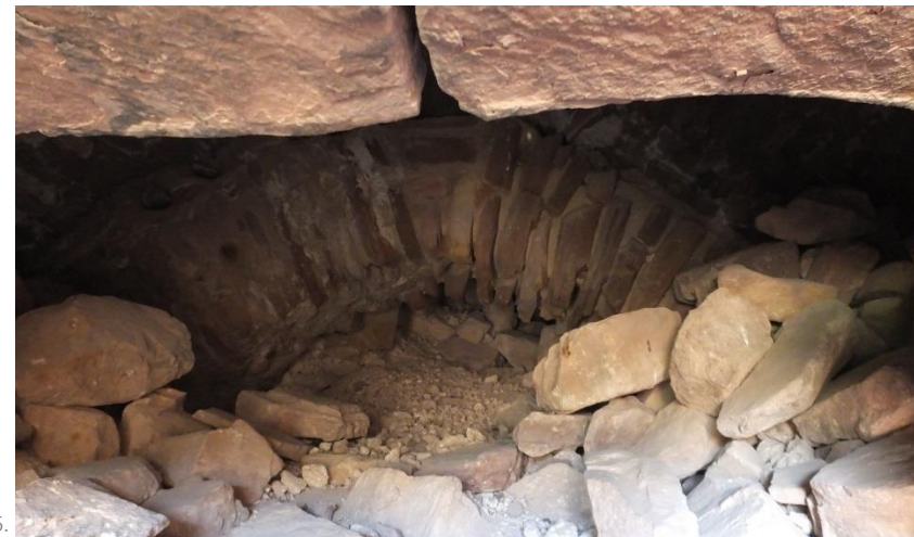
Fig. 15. Acceso al interior de la torre a través de la fachada suroeste. Fig. 16. Interior de la torre, derrumbe de las bóvedas.
