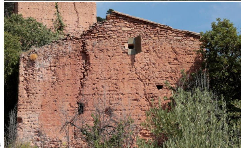
Fig. 53. Esquina este de la alquería. Solución compuesta por ladrillos macizos y lajas de mampostería de rodano. Fig. 54. Alzado suroeste de la alquería.
