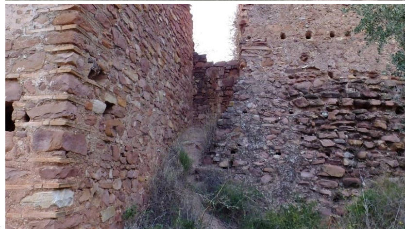
Fig. 40, 41. Alzado sureste de la torre. Base ataludada.
