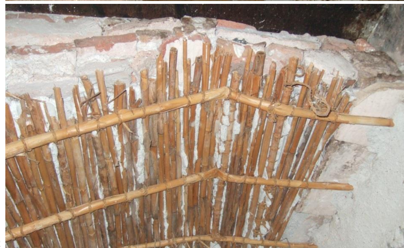
Fig. 61. Detalle del desembarco de la escalera de la célula c2. Fig. 62. Solución constructiva de la escalera de la célula c3 mediante cañas guía y superficies de cañizo.
