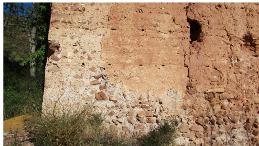
Fig. 50. Encuentro del muro de mampostería y el terreno. Ausencia de zócalo. Fig. 51. 52. Detalle de la parte inferior del alzado suroeste de la alquería.
