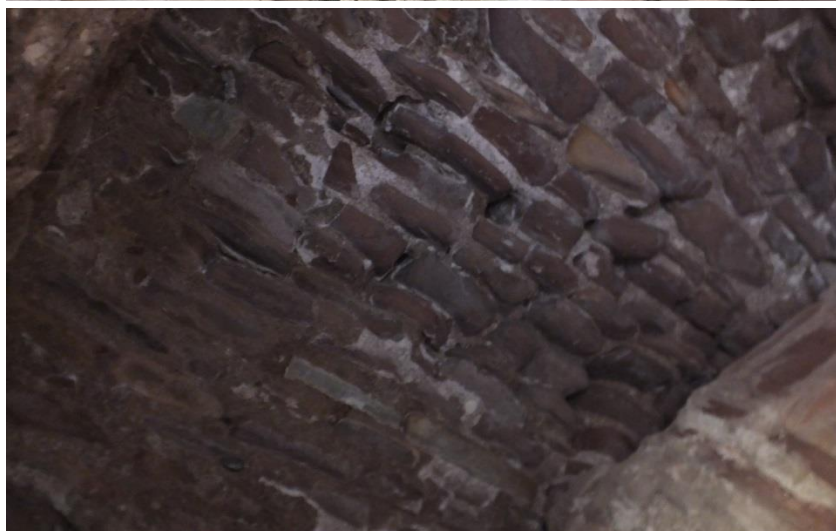
Fig. 44. Vista interior de la torre desde el hueco de acceso. Estado de derrumbe. Fig. 45. Detalle de la bóveda de lajas de rodeno y del arco fajón.
