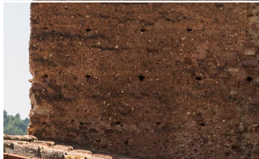
Fig. 42, 43. Detalle de la tapia del lienzo noreste de la torre.
