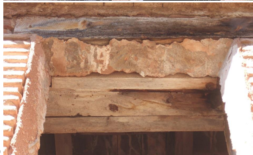
Fig. 59. Arco escarzano de fábrica de ladrillo macizo y dintel de madera como elemento auxiliar de refuerzo. Fig. 60. Detalle del hueco superior de la célula c1, sucesión de secciones de madera para conformar el dintel abarcando el espesor del muro.
