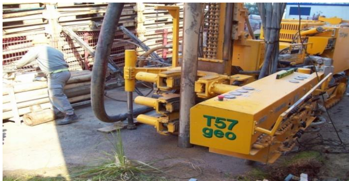
Ilustración 3.3. Perforación con revestimiento.
