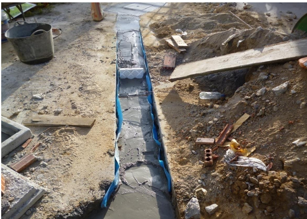
Ilustración 3.10. Hormigonado de las zanjas del conexionado.
