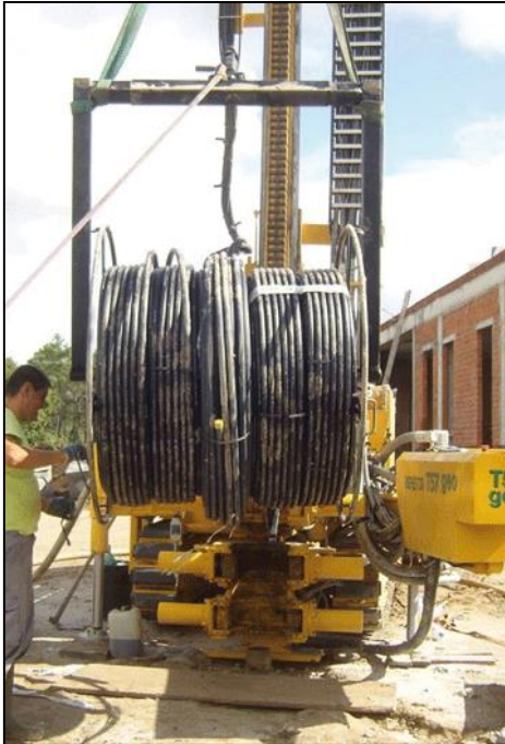
Ilustración 4.5. Introducción de la Sonda en el pozo.
