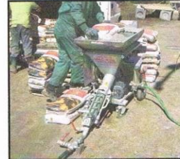
Equipo de inyección de la mezcla geotérmica
