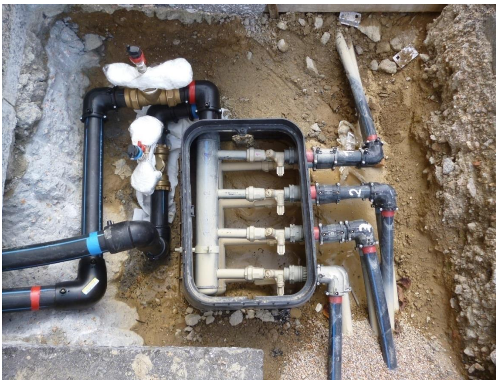
Ilustración 3.11. Circuito de colectores de los Pozos 1, 2 y 3.
