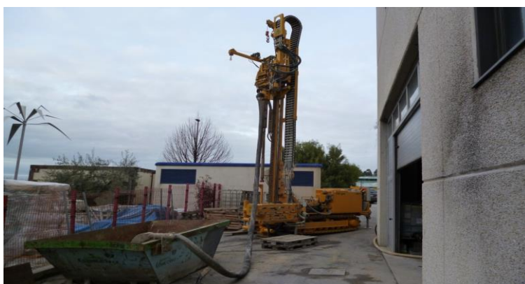
Ilustración 3.5. Decantación de residuos a un contenedor.
