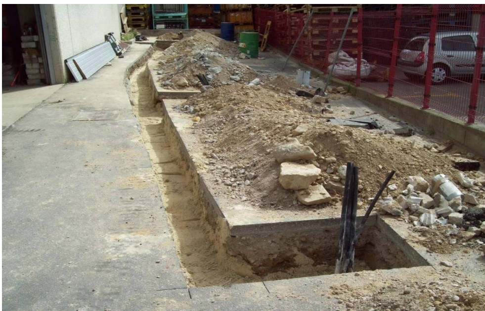
Ilustración 3.9. Zanjas entre los pozos.
