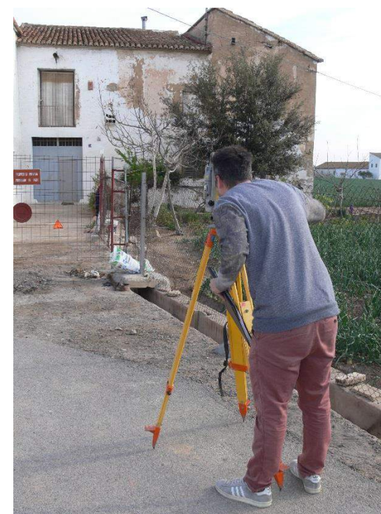
Ilustración 1 Toma de Puntos con Estación Total. Autor Propio. 2015.
