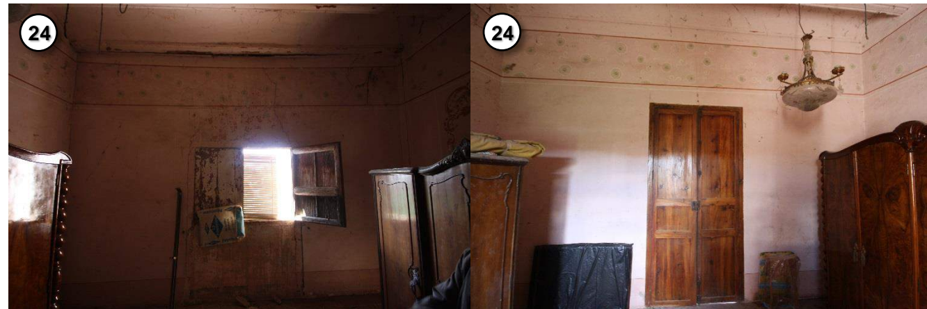
Ilustración 57 Cuarto de la Alquería de Farinós en Planta Primera. Autor Propio. 2015
