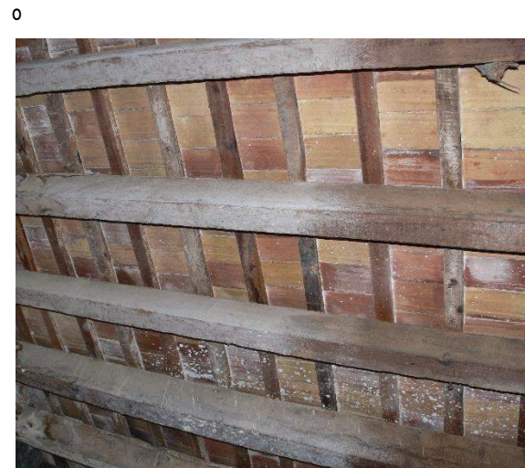
Ilustración 68 Vista cenital estructura de cubierta. Autor Propio. 2015
