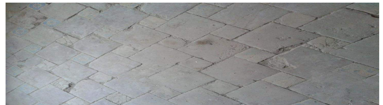
Ilustración 74 Vista Panorámica de la colocación de los pavimentos. Autor Propio. 2015.
