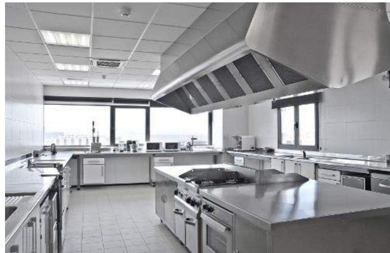
Ilustración 87 Cocina con aspecto similar a la Proyectada. Cocinas industriales. 2011.
