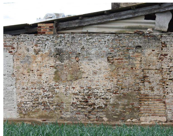
Ilustración 63 Muro de tapia en la fachada Norte. Autor Propio. 2015
