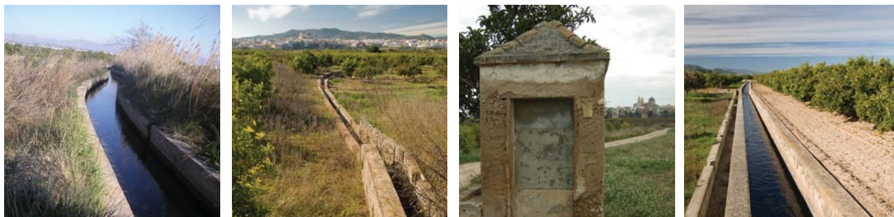
Acequias y elementos del patrimonio hidráulico de Ribarroja. Figura 084
