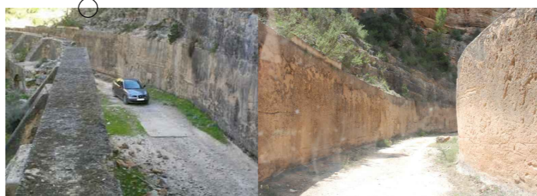
Fig. 5_ Aliviadero del canal
