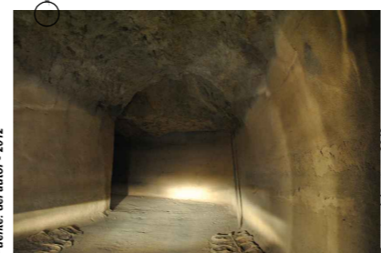
Fig. 4_ Tramo del túnel de conducción de agua
