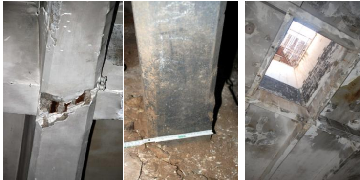
Fig. 25 Detalle de Vigas, zunchos y pilares. Forjado planta primera. Estado actual, 2011. Fuente: el autor
