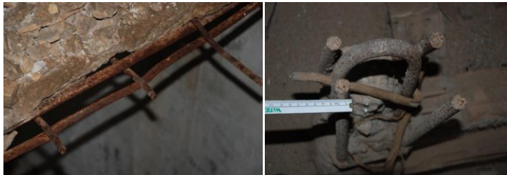
Fig. 23 Detalle de losa de forjado. Detalle armado de pilar. Estado actual, 2013. Fuente: el autor
