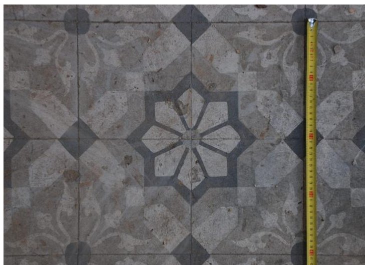
Fig. 10 Detalle diseño del pavimento de sala de máquinas. Estado actual 2014 Fuente: El autor
