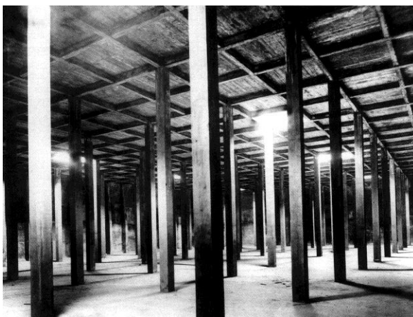
Fig. 16 Depósito en Bron (Rhône, Francia. Hormigones armados Hennebique (1912- 1913). Fuente: SIMONNET, Op. cit., p. 127.
