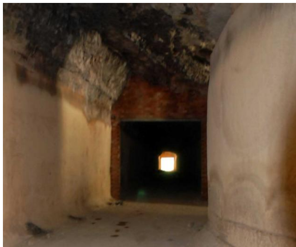
Fig. 3 Vista interior del túnel excavado. 2012 Fuente: del autor.
