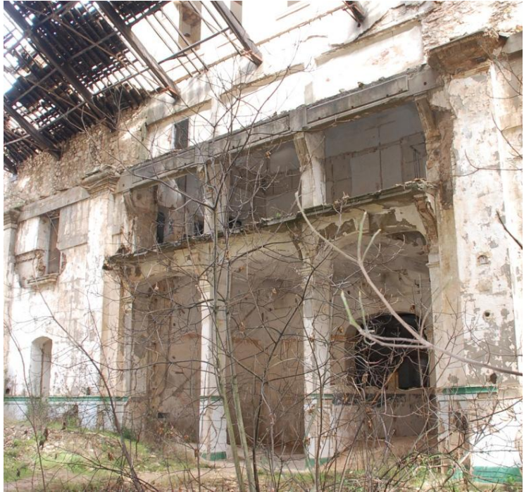
Fig. 8 Pilares de hormigón en la conexión con el edificio de transformadores. Estado actual, 2011. Fuente: El autor
