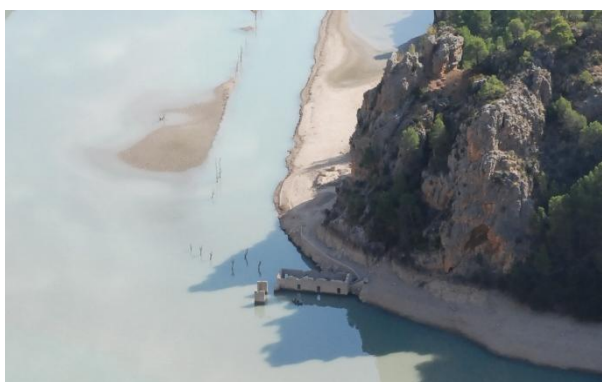
Fig. 8 Caseta de toma de Agua y presa inundadas. 2013 Fuente: del autor.
