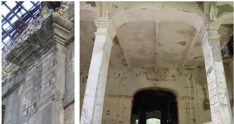
Fig.9 Detalle de pilastras y de pilares de hormigón. Sala de máquinas Estado Actual, 2011. Fuente: El autor
