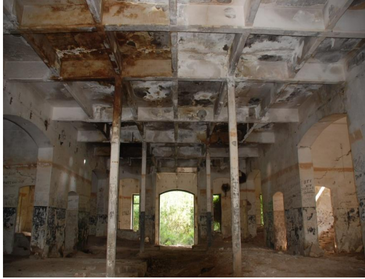
Fig. 24 Sistema estructural. Banda central. Forjado bidireccional cota +6,00 m. Estado actual, 2011. Fuente: el autor
