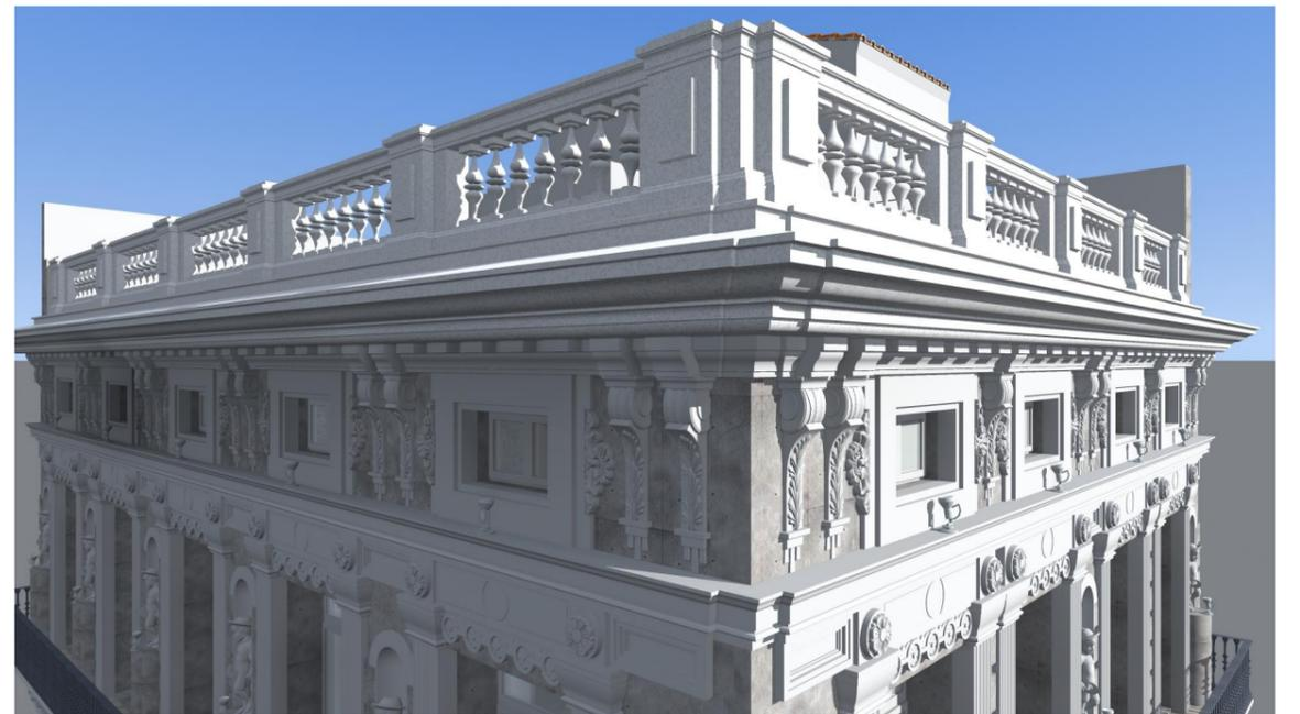
Imagen 93. Detalle 3d ornamentación en planta buhardilla y cubierta con otro tipo de balaustrada
