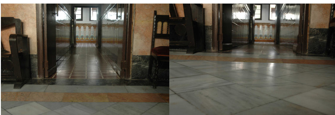
Imagen 62. Pavimento de mármol en zaguán. Fuente propia
