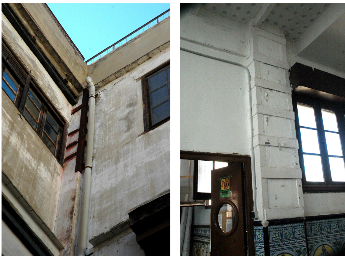
Imagen 68. Refuerzos estructurales. Fuente propia
