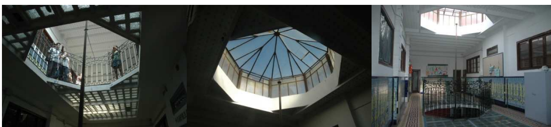
Imagen 51. Patio central y lucernario. Fuente propia.
