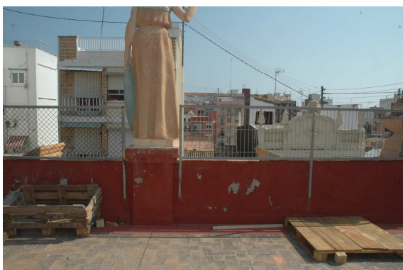
Imagen 60. Cubierta transitable. Fuente propia.
