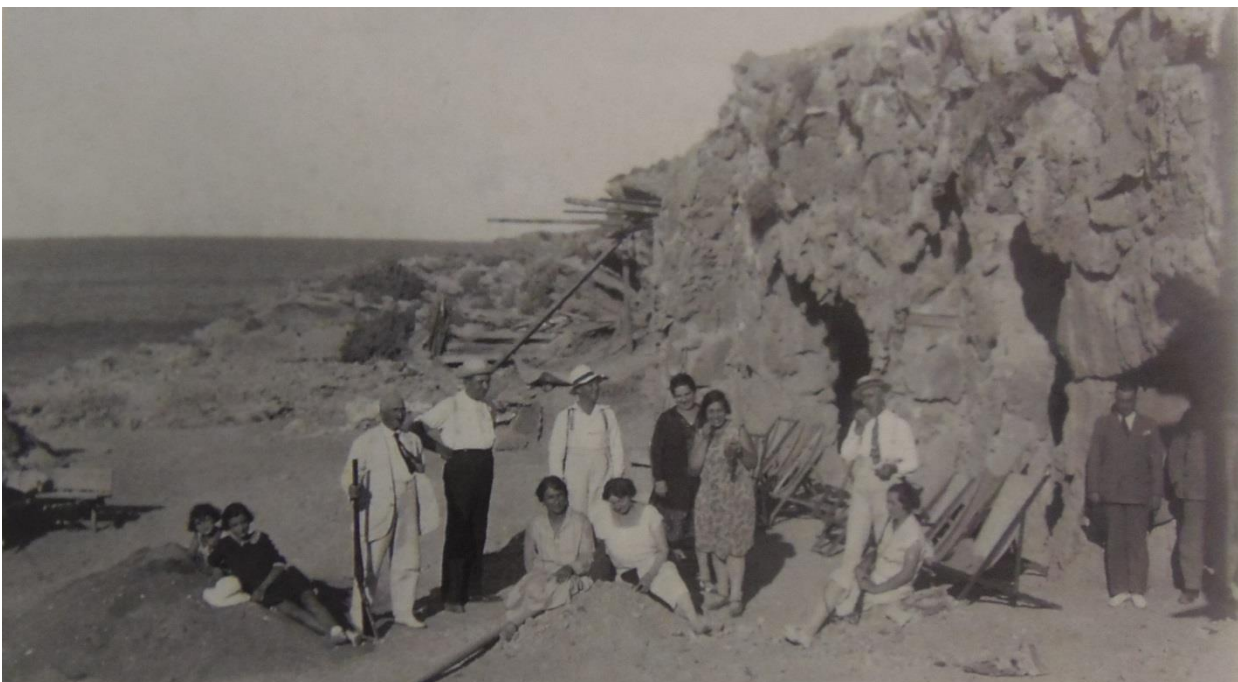
Fotografía de la fase de la construcción de la cafetería. Archivo privado de Ellis Solomidu- Balanu
