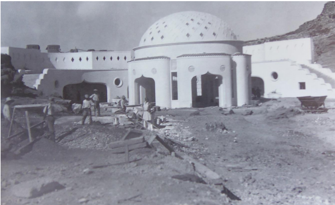
Fotografía durante las obras, la excavación del canal
