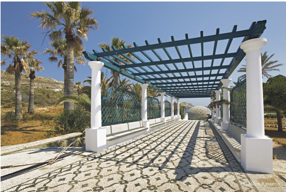
Portico de la pergola de madera
