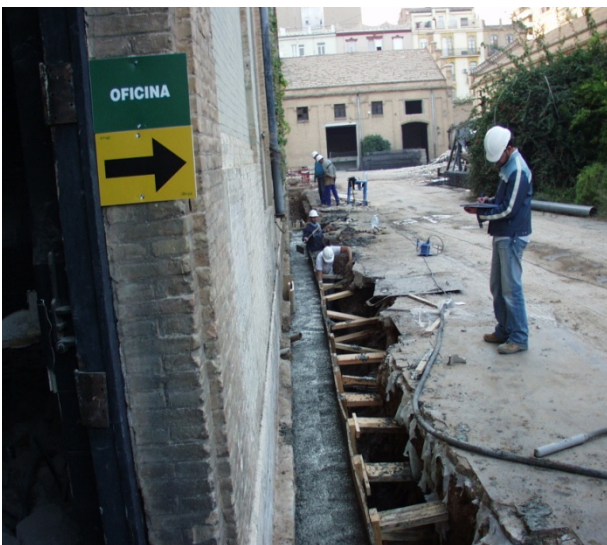
Secuencia exterior de ejecución de rigidizadoras
