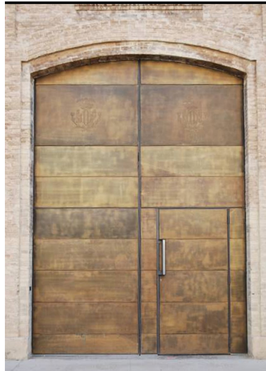
Imagén de la puerta de entrada de la Nave Norte en origen y la ejecutado con Portón de latón
