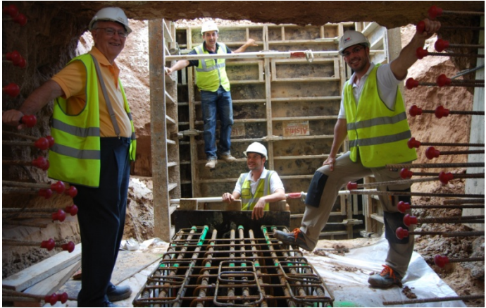
Proceso de Ejecución de la Cimentación de Nave Norte. Sistema descendente-ascendente
