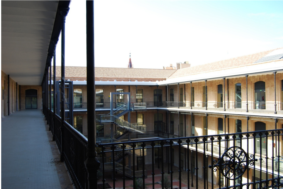
Fotografía del acabado final de los pilares de fundición
