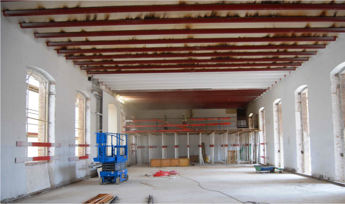
Imagen con la armadura de viga balcón de los altillos al fondo
