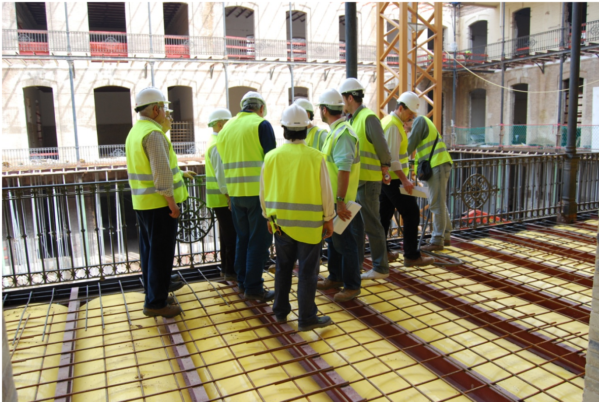
Forjado de Galerías con viguetas y encofrado de bóvedas recuperable
