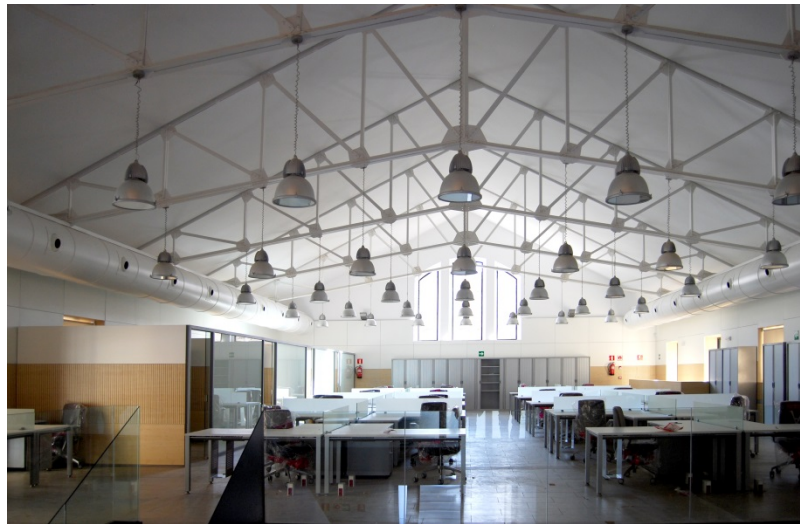
Imagén de los techos de la Nave Este
