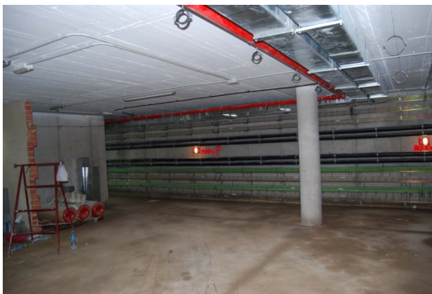
Sótano con las conducciones montadas
