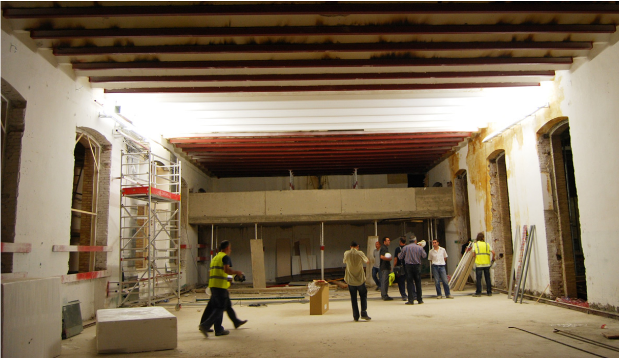
Imagen con la armadura de viga balcón de los altillos ya hormigonada
