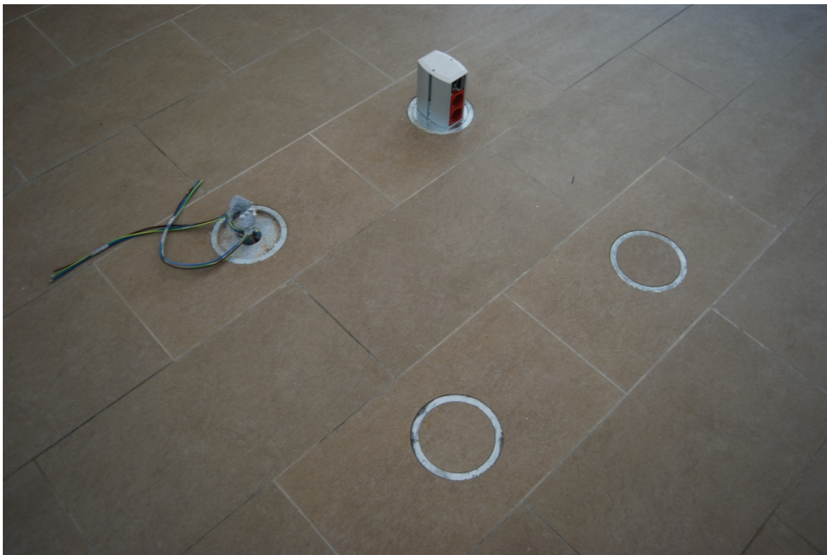
Detalle del montaje de las torres de instalaciones de los puestos de trabajo
