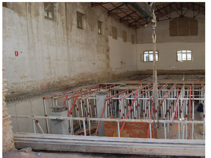
Secuencia interior de ejecución de sótanos
