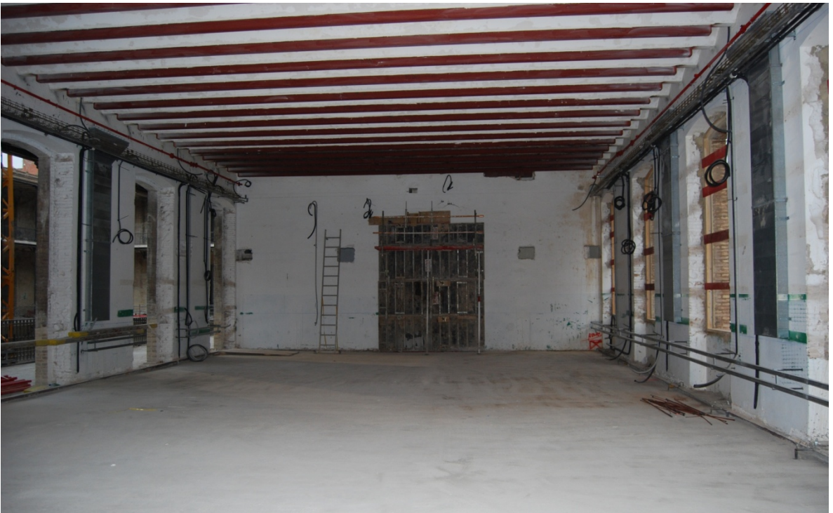
Secuencia refuerzo de forjados existentes por su cara superior
