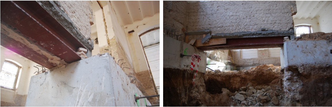
Detalle y fotografías de la Ejecución de dinteles en muros de carga
