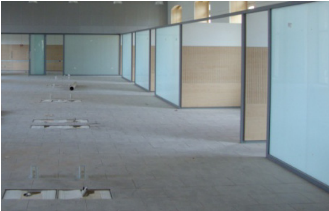
Construcción de solado en seco con baldosas registros pendiente de colocar
