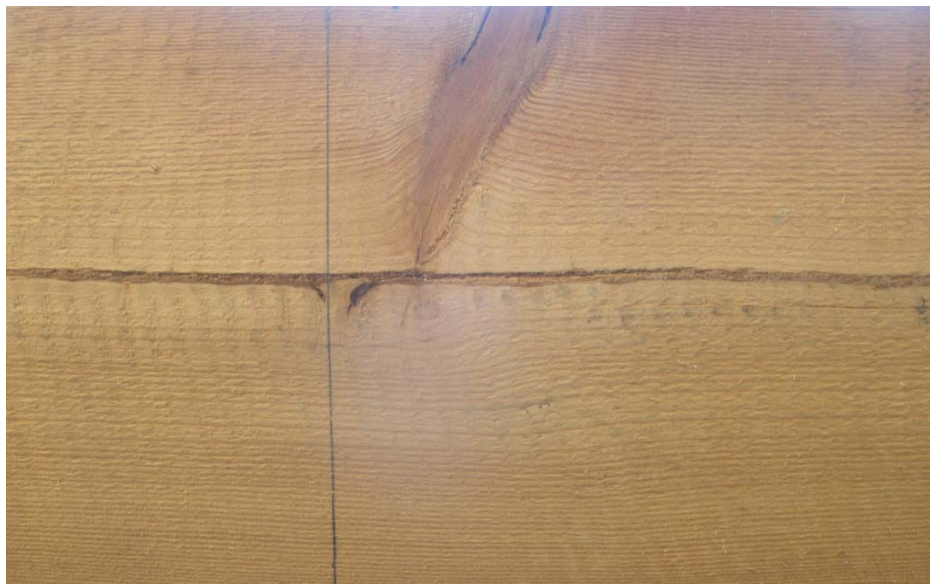
Figura 74. Detalle del nudo de canto la viga PS1-1.
