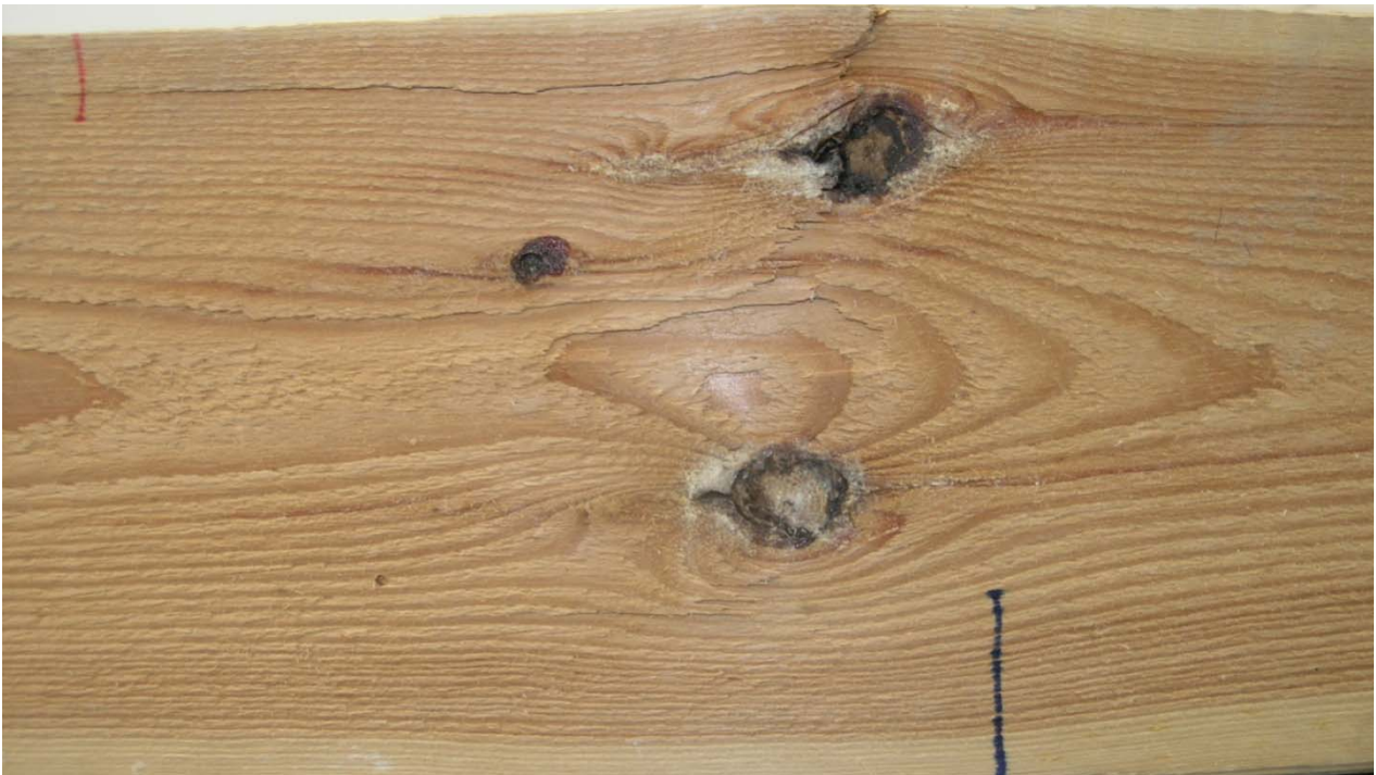
Figura 88. Detalle del nudo de canto la viga PS2-11.
