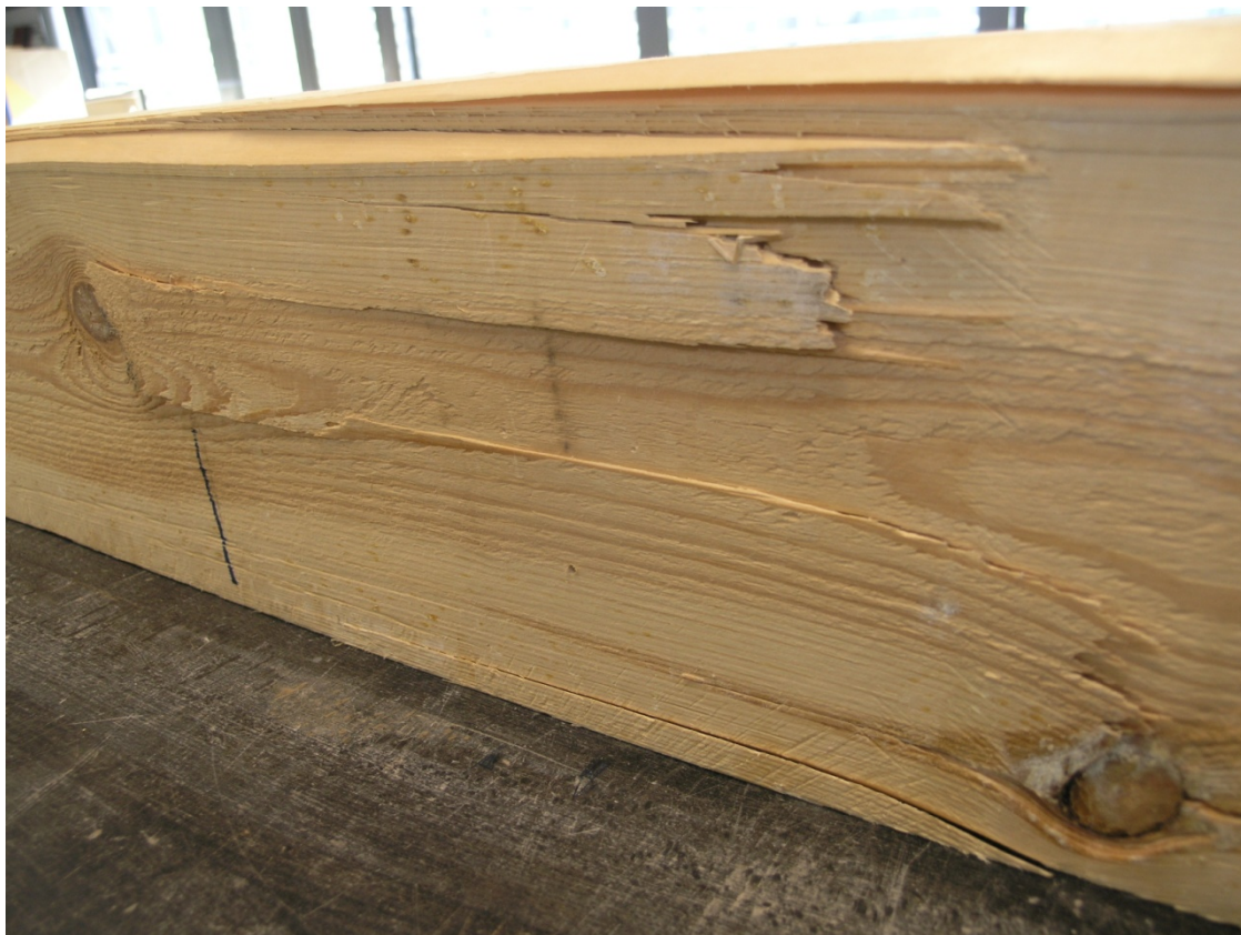
Figura 93. Detalle de rotura de la viga PS2-19.
