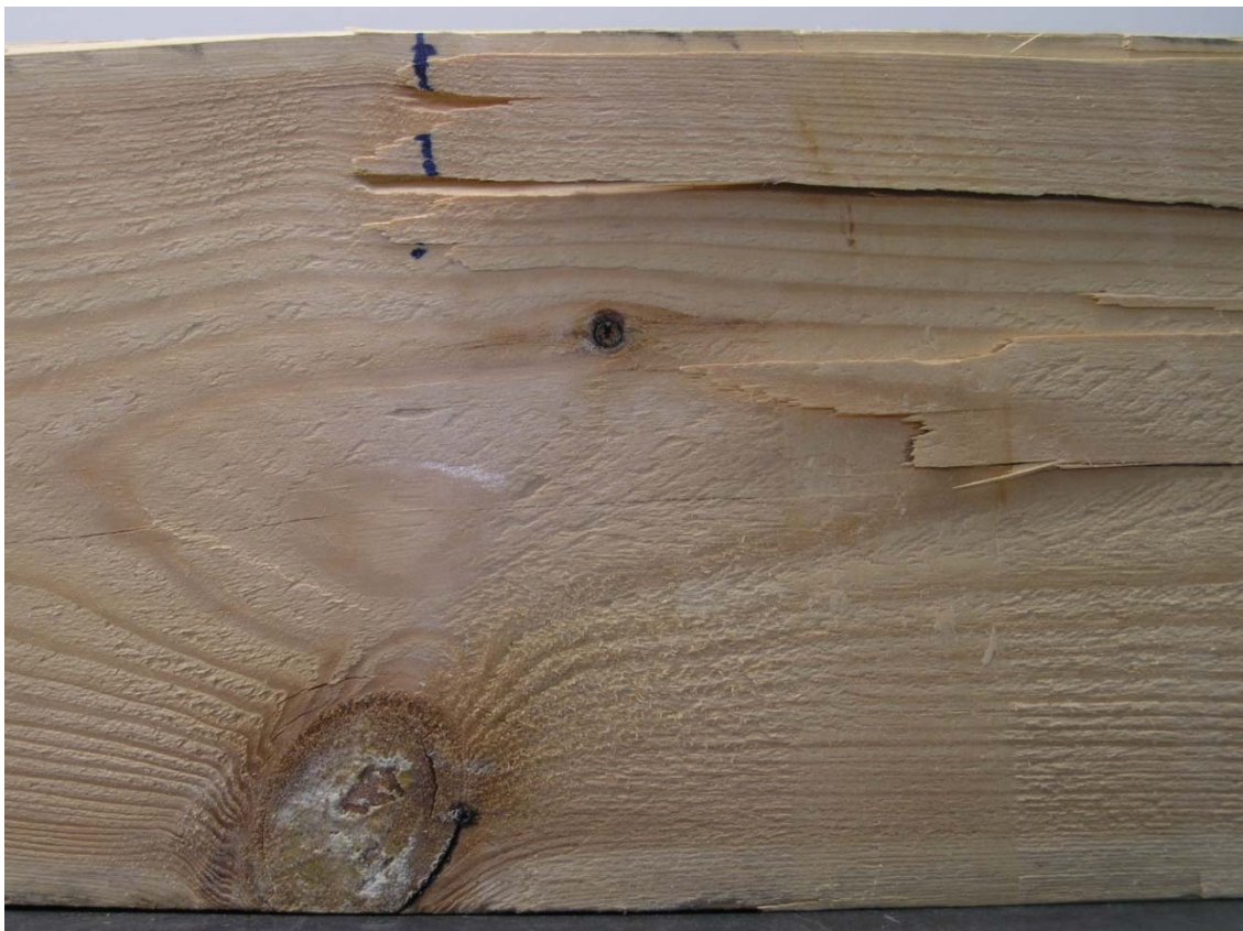
Figura 96. Detalle de rotura de la viga PS2-27.
