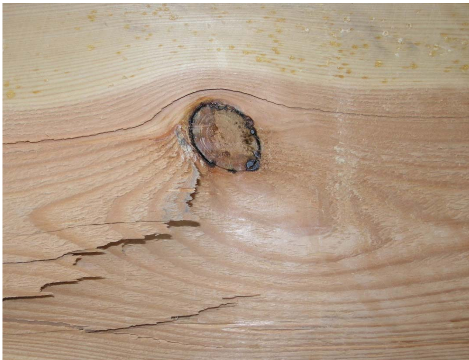
Figura 102. Detalle de rotura por un nudo de la viga PS2-38.
