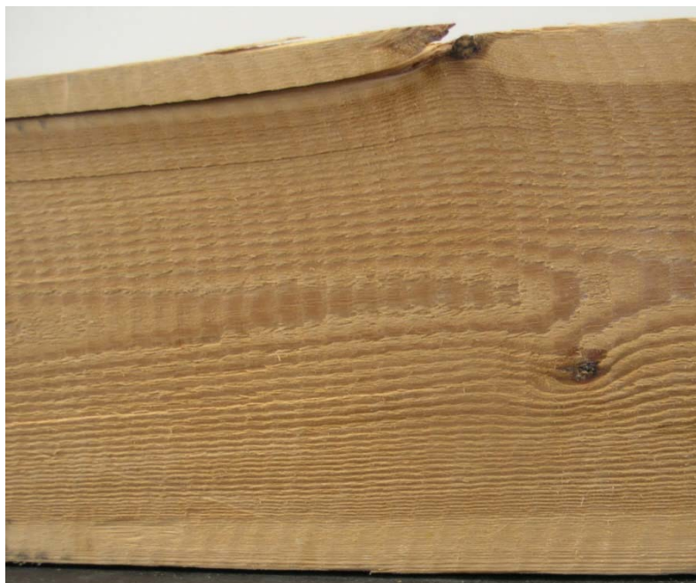
Figura 78. Detalle del nudo de canto la viga PS1-11.
