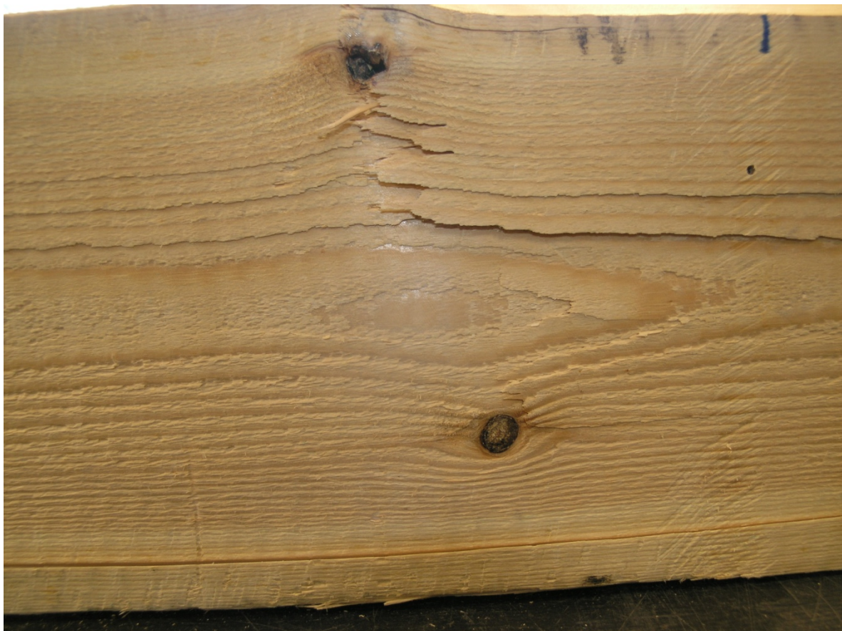
Figura 82. Detalle del nudo de canto la viga PS1-26.
