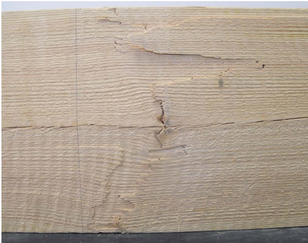
Figura 79. Detalle de la rotura de la viga PS1-13, por una zona libre de imperfecciones en superficie.
