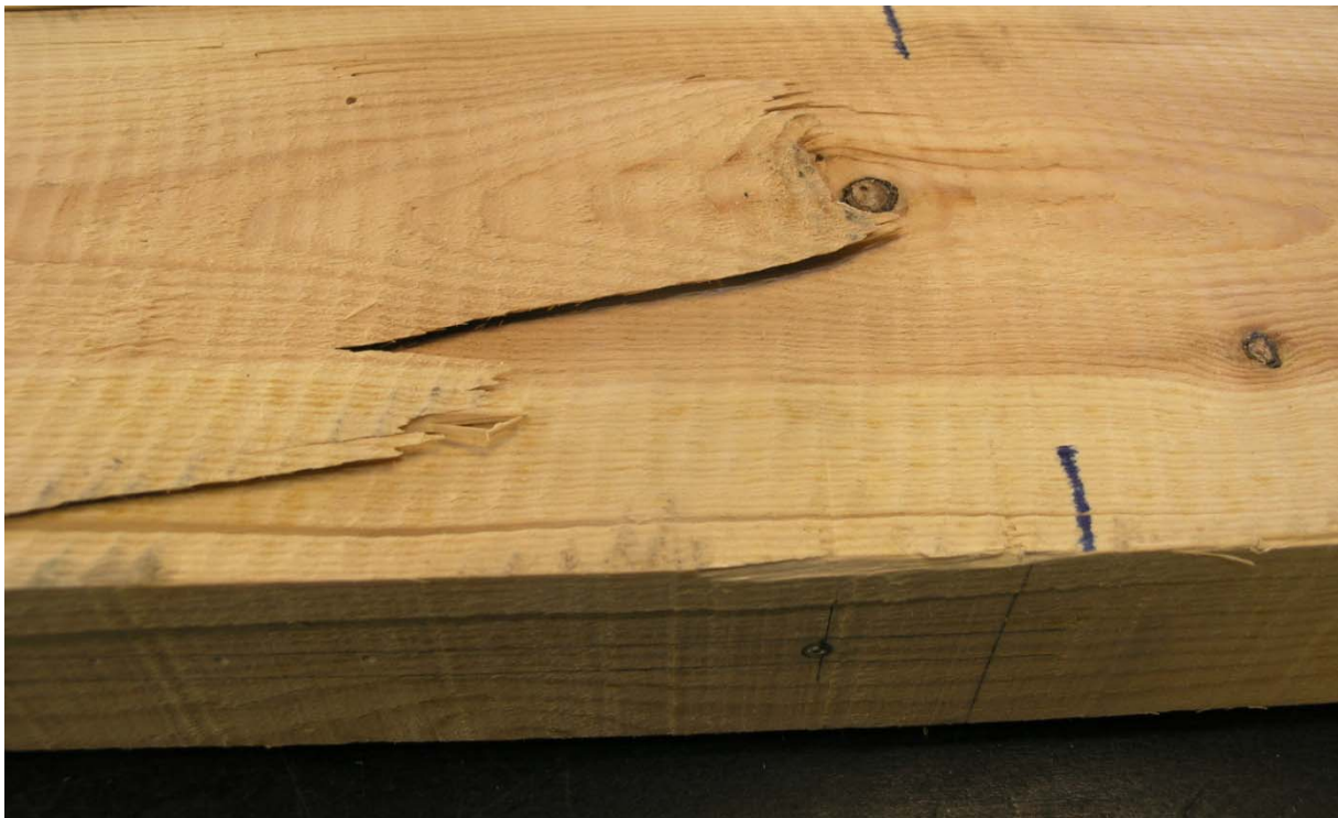
Figura 75. Detalle de rotura por un nudo de la viga PS1-5.
