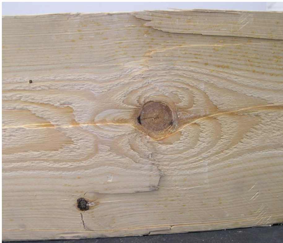
Figura 91. Detalle del nudo de canto la viga PS2-16.
