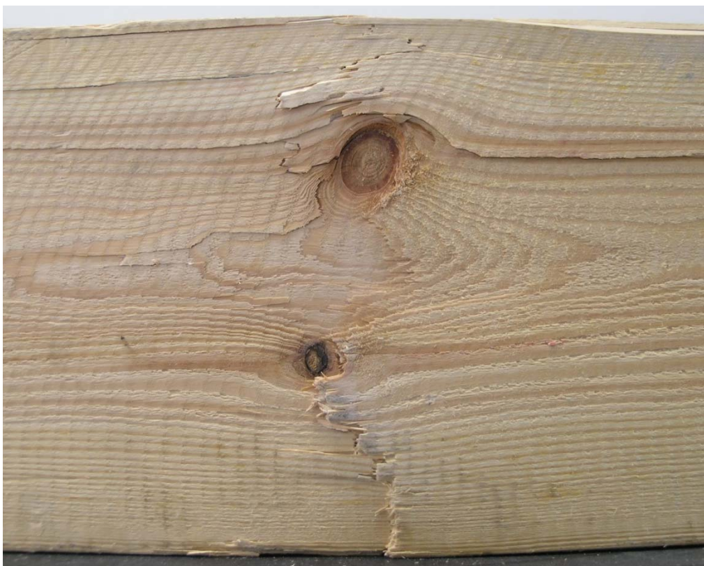
Figura 76. Detalle de rotura por dos nudos de la viga PS1-6.
