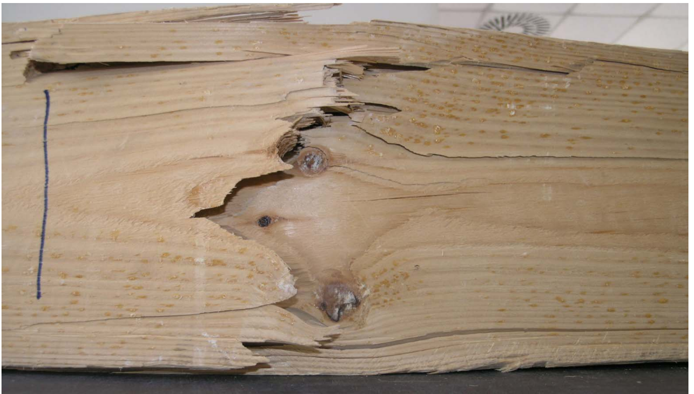
Figura 94. Detalle del nudo de canto la viga PS2-21.
