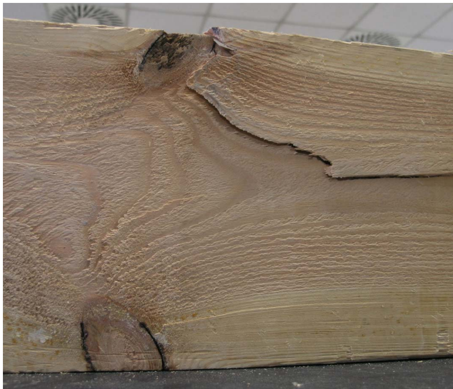
Figura 87. Detalle de rotura de la viga PS2-10.
