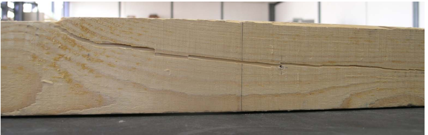
Figura 90. Detalle de rotura de la viga PS2-15.
