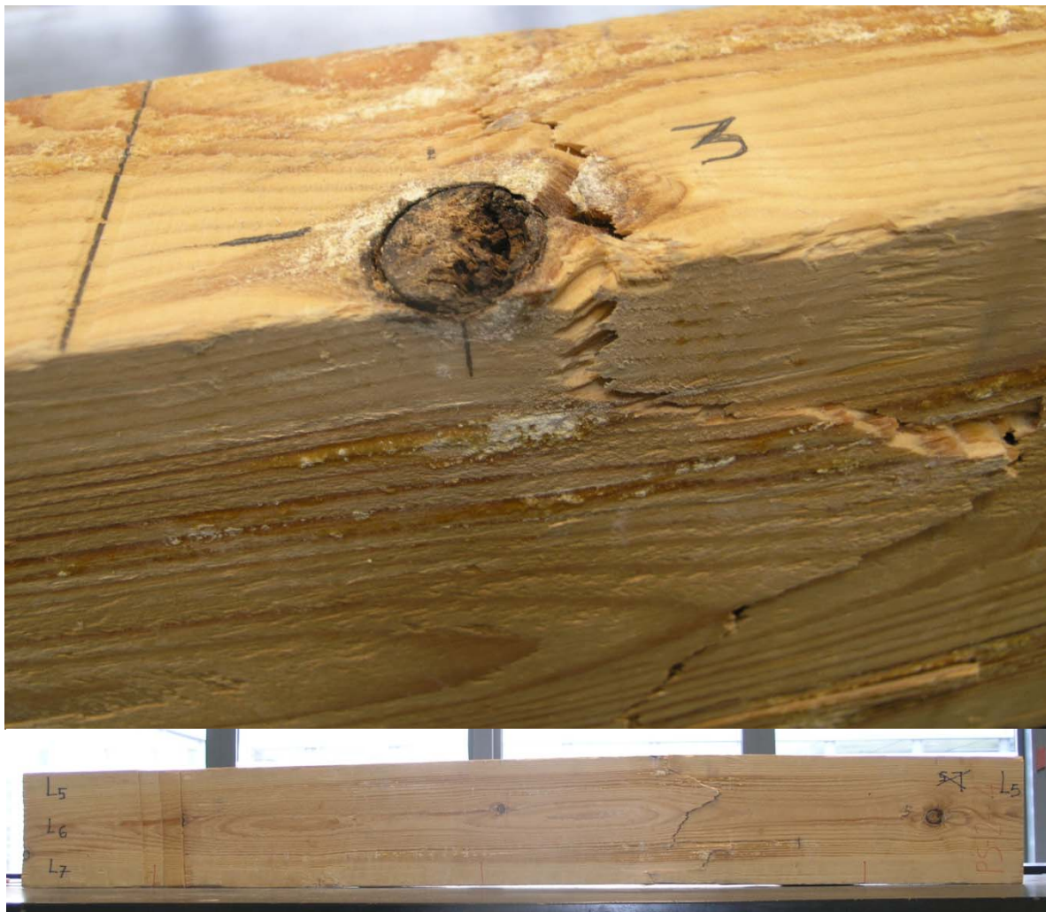
Figura 85. Detalle de rotura de la viga PS2-4.
