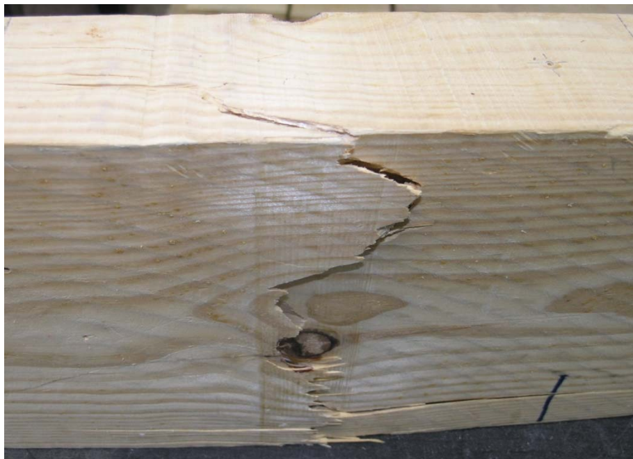
Figura 86. Detalle del nudo de canto la viga PS2-9.
