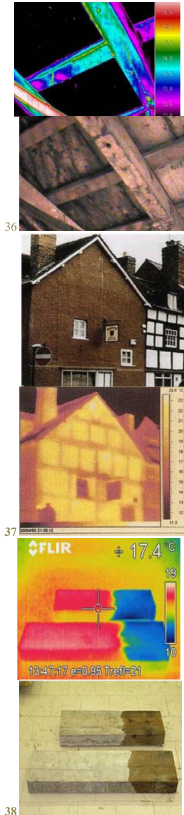
Fig. 36. Termografía de un techo de madera. Fig. 37. Imagen de un muro construido mediante entramado de madera. Fig. 38. Identificación de humedad.
