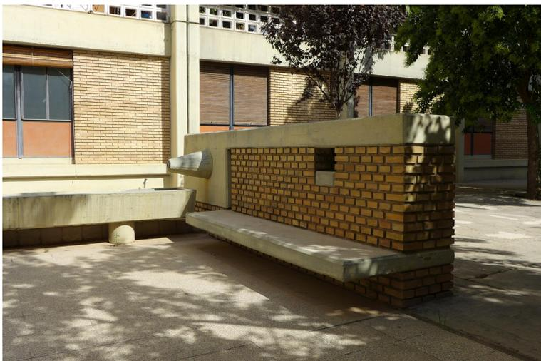
**163.** Bancos y pavimento de hormigón prefabricado de 40x40 cm. de la casa comercial "Butsems" (fotografía actual).
