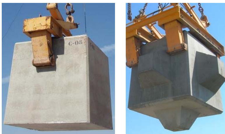
Figura II.14. Manipulación con pinzas de presión de cubos y Cubípodos.
