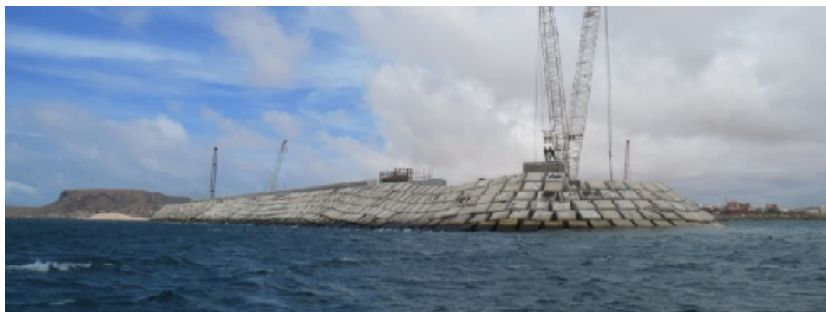
Figura II.20. Manto principal monocapa de cubos con colocación uniforme en el dique de Boa Vista (Cape Verde, 2014). Fuente: Cortesía de M. Van Gent.
