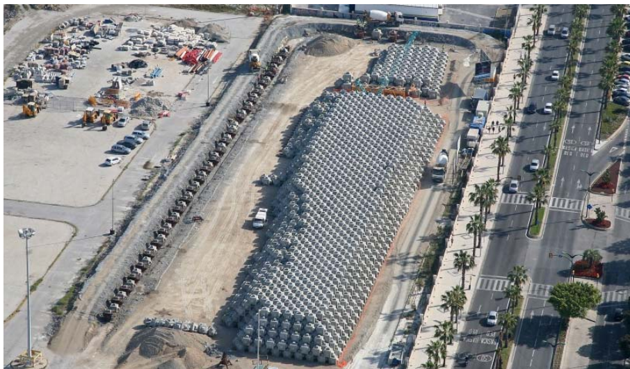
Figura II.17. Parque de almacenamiento de Cubípodos a 5 alturas del Dique de San Andrés (Puerto de Málaga, abril 2012). Fuente: SATO S.A. (Grupo OHL).
