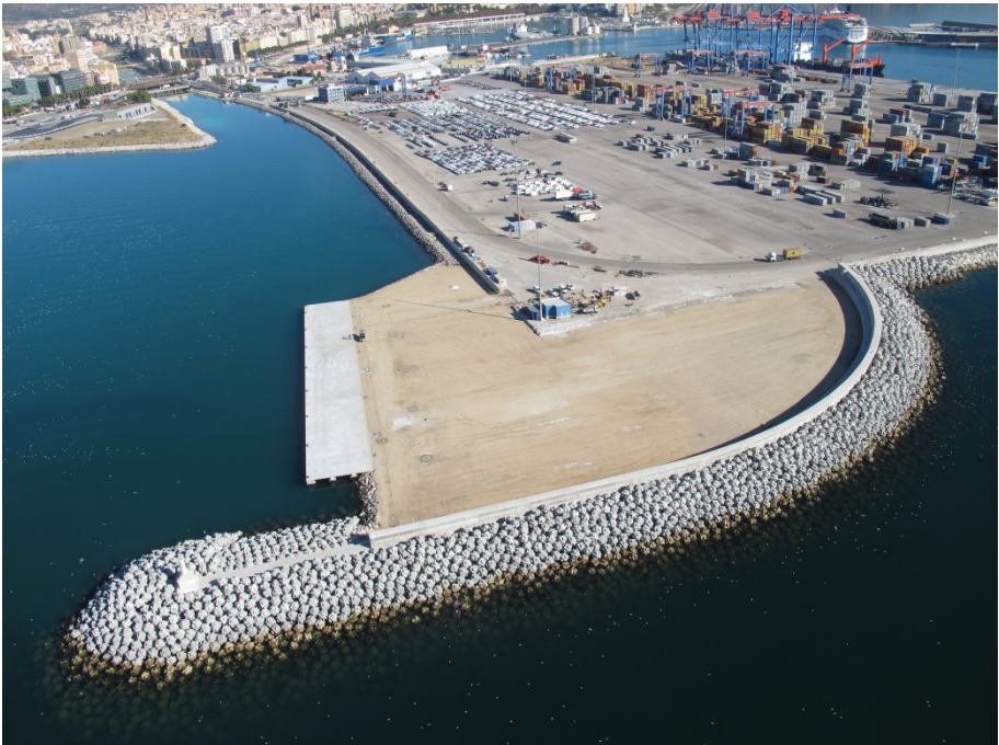
Primera aplicación del Cubípedo (manto bicapa de M[t]=6 ) en el Dique de San Andrés, Puerto de Málaga (noviembre de 2013)
