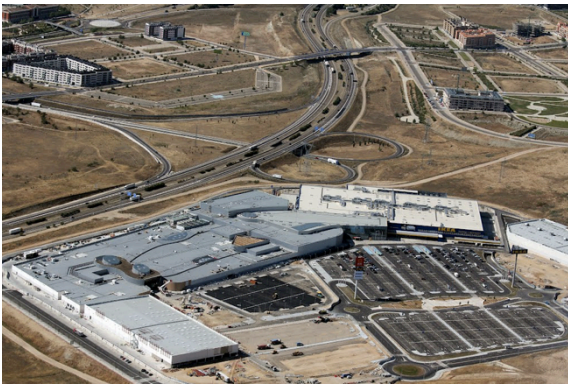
Fig. 43. Centro comercial en Arroyo de la Encomienda. Valladolid, España
