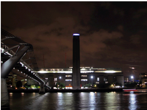
Figs. 45-46. Reconversión de la antigua Central Eléctrica de Bankside en la nueva Tate Modern, Londres, Reino Unido, 2000. Herzog & de Meuron
