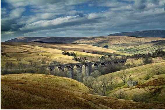
Fig. 131. Viaducto Dent Head, Cumbria, Inglaterra, 1869
