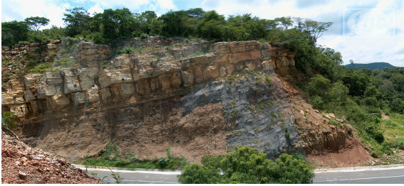
Fig. 143. Talud de roca en carretera Tuxtla, Chiapas, México
