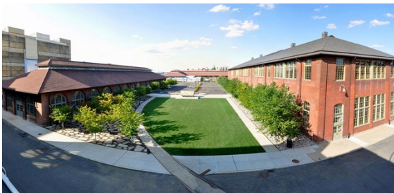
Figs. 84-86. Estado previo, durante las obras y posterior de un sector del Urban Outfitters, Filadelfia, Pensilvania, EEUU, 2011. D.I.R.T. studio
