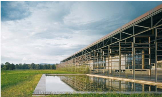
Figs. 69-71. La estructura perimetral de ventanas y las láminas de agua como estrategias de identidad
