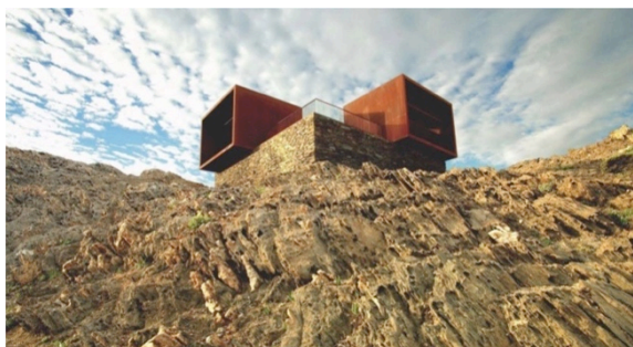
Figs. 37-39. Esquema de la deconstrucción y reciclaje de materiales, marcado de itinerario sobre la piel con la desnudez recuperada y antigua vivienda del guarda reconvertida en mirador
