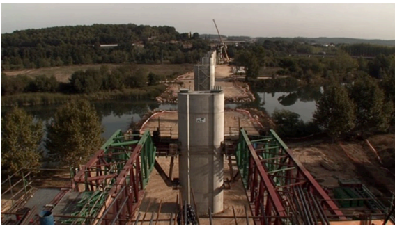
Fig. 2. Construcción de la línea de alta velocidad entre l'Alt Empordà y Catalunya Nord, España
