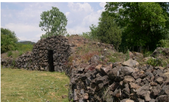
Figs. 19-22. Detalles de la utilización del acero corten en el acceso y la rehabilitación de los muros y construcciones de piedra en seco
