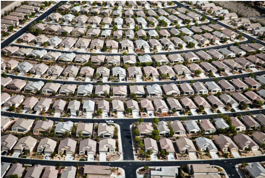
Fig. 7. Unidad residencial, Condado de Clark, Nevada, EEUU
