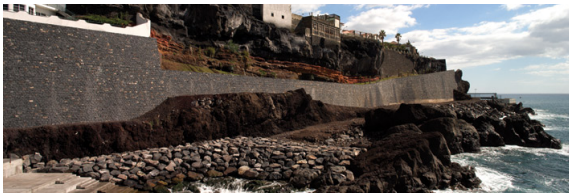
Figs. 63-65. Piscinas Salinas, Câmara de Lobos, Madeira, Portugal, 2006. J. Gomes da Silva. El muro de contención de piedra basáltica labrada genera el solárium y crea un paseo marítimo en su desarrollo
