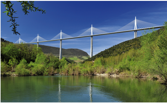
Fig. 145. Golden Gate, San Francisco, EEUU, 1937. J. Strauss Fig. 146. Viaducto de Millau, Aveyron, Francia, 2004. M. Virlogeux y Foster and Partners
