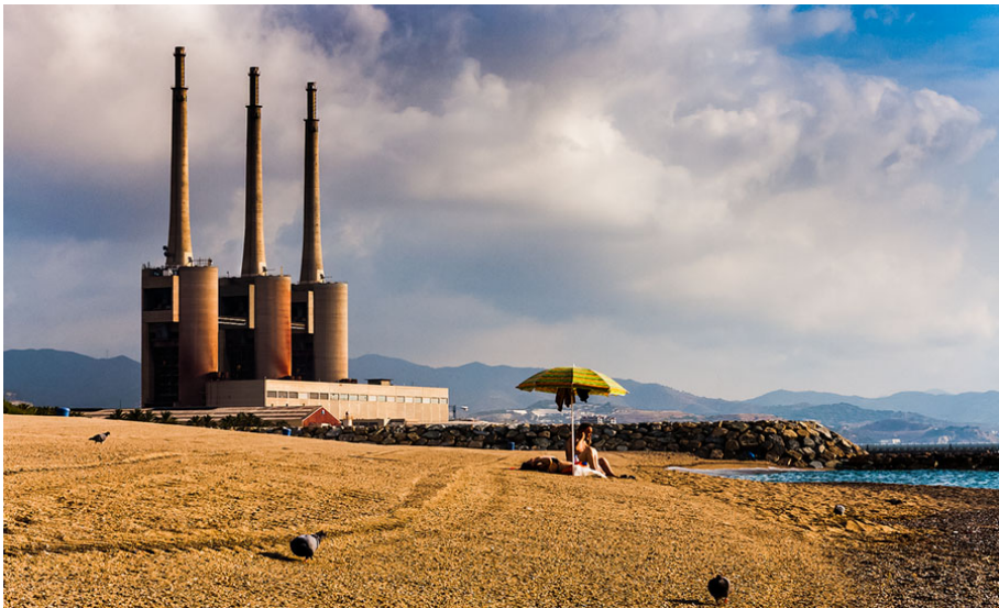
Fig. 44. Chimeneas central térmica. Sant Adrià del Besòs, Barcelona, España
