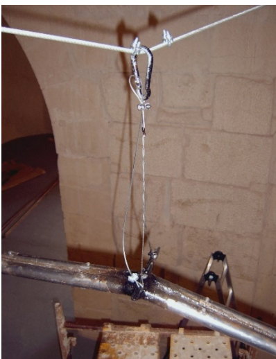
Ilustración 88: Vista del eje central sujeto al cable y posterior colocación del compresor
