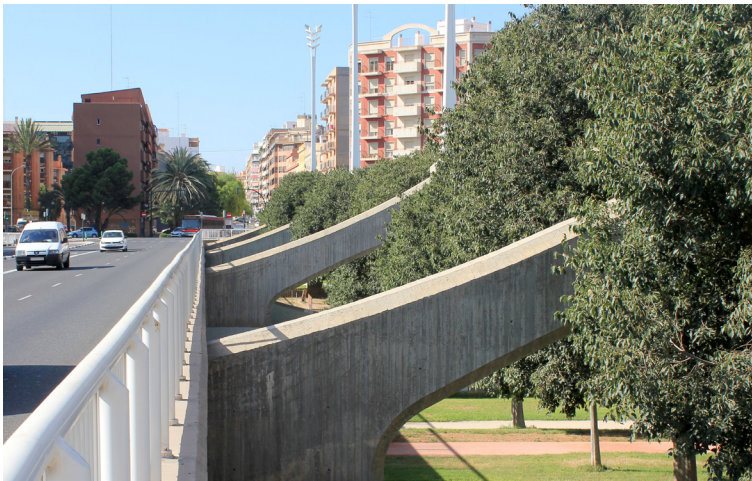
Detalle de las pilas en forma de doble ménsula del puente y que separan los dos tableros del mismo dejando una parte ajardinada en la zona central.
