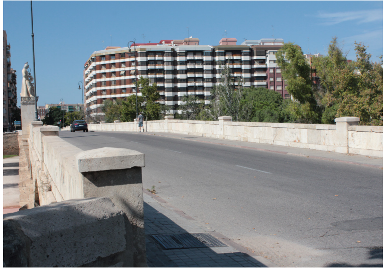
Vista del Puente de San José desde arriba del viejo cauce.
