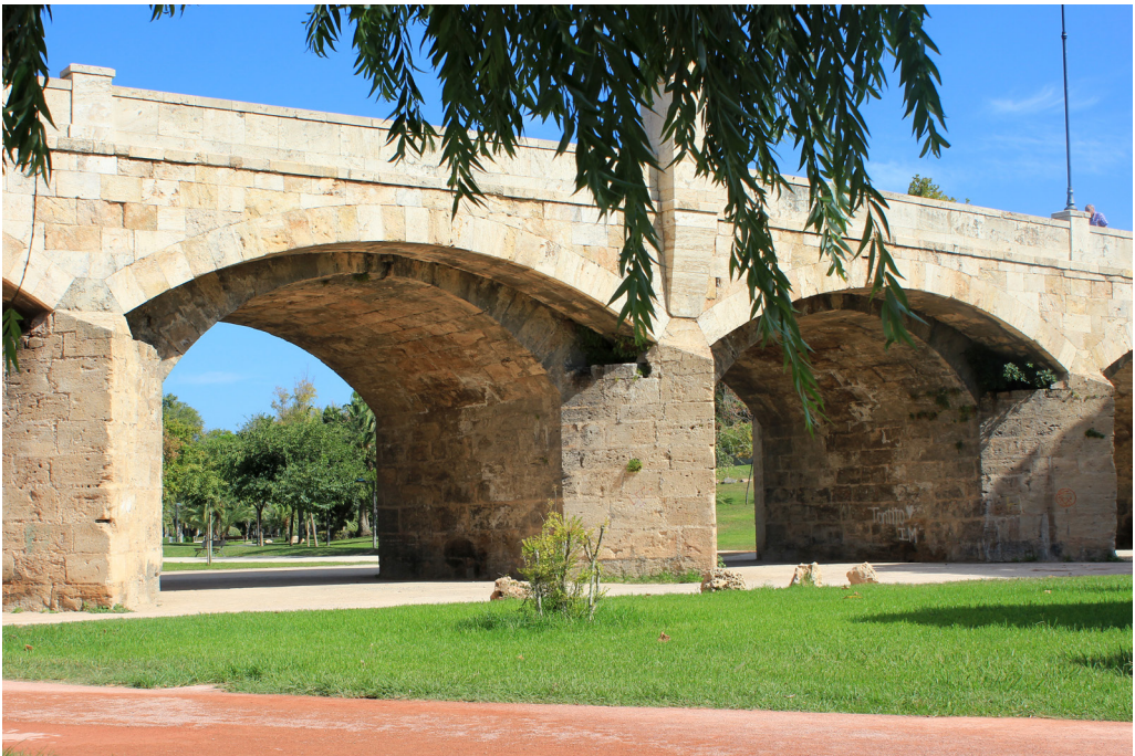
Vista frontal del Puente de San José desde el interior del viejo cauce del Turia. Puede observarse la doble arcada consecuencia del ensanche del puente llevado a cabo a principios del siglo XX.
