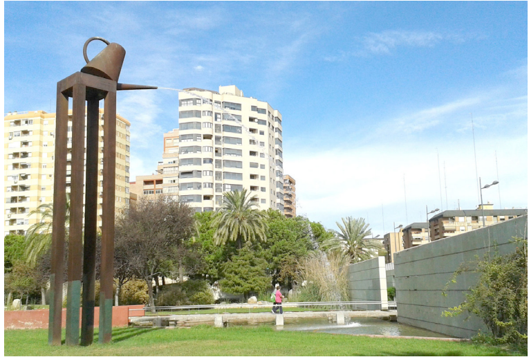
Escultura-fuente Taulatetombant diseñada por Artur Heras en 1987 para el proyecto del tramo II desarrollado por el colectivo de arquitectos Vetges Tu i Mediterrània.
