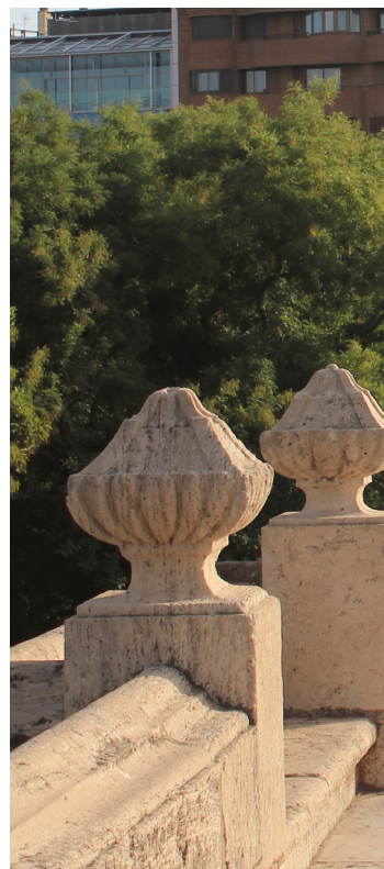
Vista de los pretiles y accesorios que adornan la parte superior del Puente del Real .
