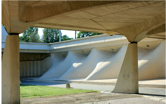
En la foto se observa el sector de pretil que queda entre los dos tableros que conforman el puente y que sus formas onduladas recrean el oleaje de las aguas.
