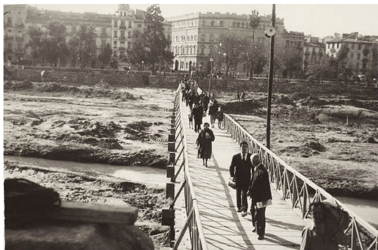
Pasarela provisional que se montó tras la riada de 1949. (RODRIGO, 2011, 355)
