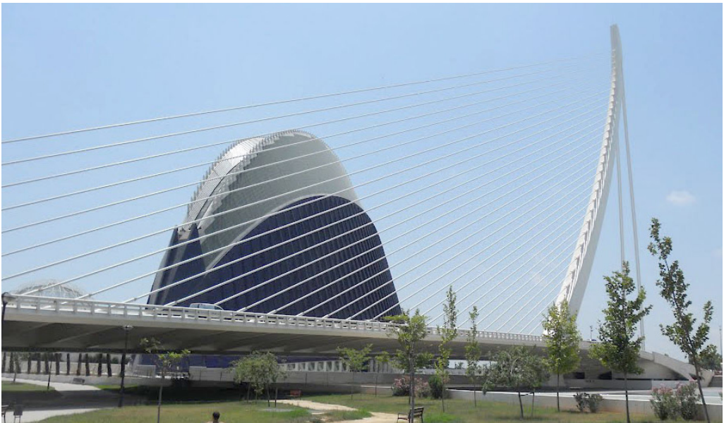
Vista del puente del assut de l'Or diseñado por Santiago Calatrava.
