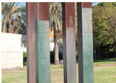
En la imagen se aprecia el cambio de color más verdoso a consecuencia de la pintura dada para proteger el material de la corrosión y tapar los grafitis.
