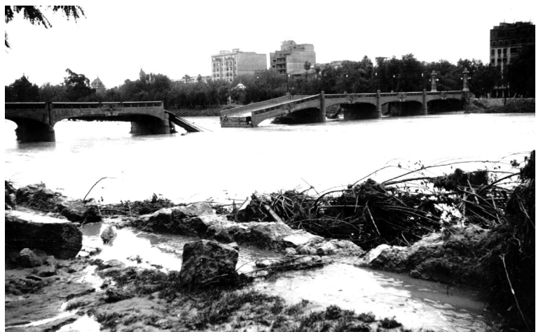
Puente de la Exposición con uno de sus arcos arruinados después de la riada de 1957. Archivo Las Provincias.
